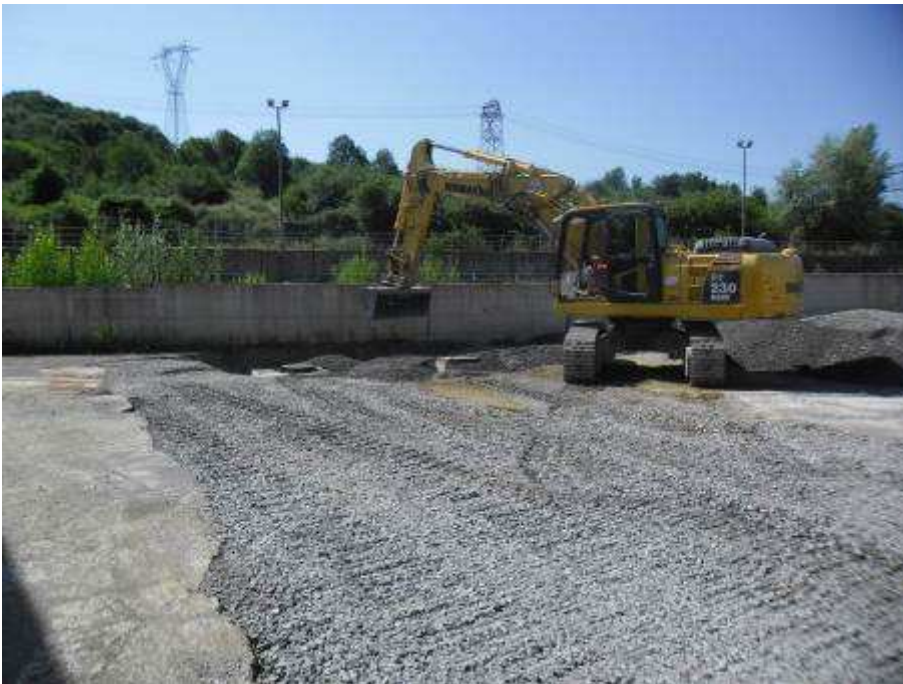
Foto 2 – Sistemazione Piazzale ENEL
