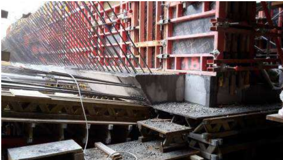
Foto 3 – Getto fondo Cassone e pareti centrali Solaio Fili 4-5
