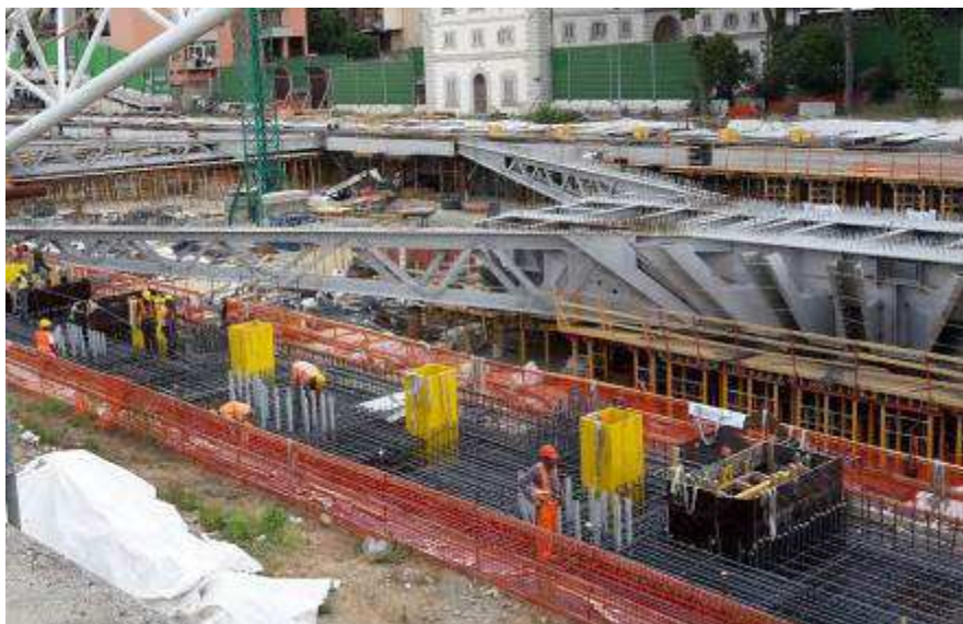
Foto 7 – Posa Armatura Trave cuscino Fili 13-21 lato Est
