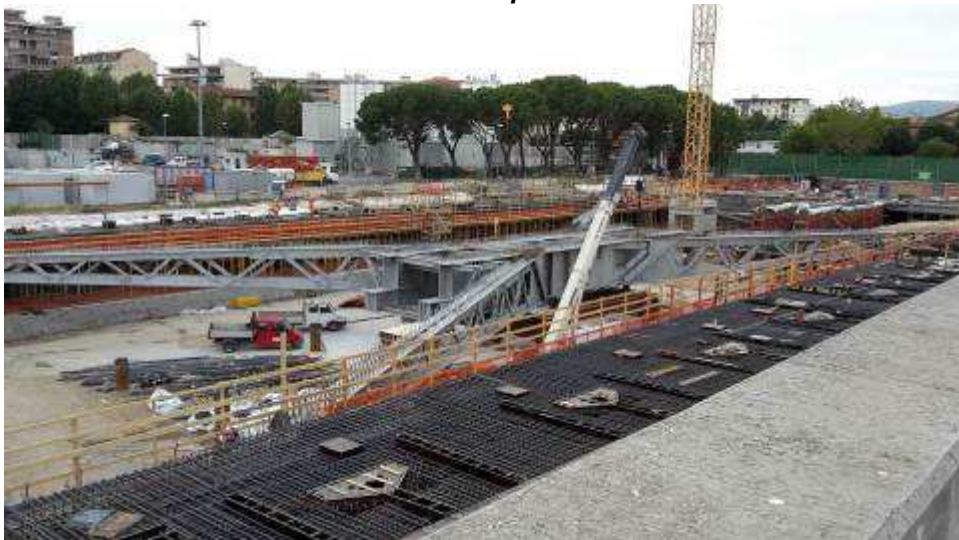
Foto 4 – Posa armatura e getto Trave cuscino Fili 5-13 lato Est
