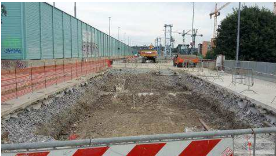
Foto 1 – Interventi per la chiusura della NC 63
