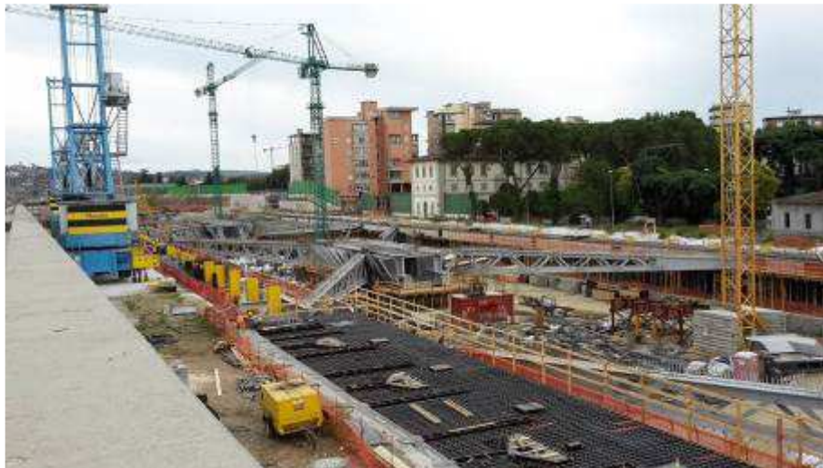
Foto 5 – Posa armatura Trave cuscino Fili 5-13 lato Est
