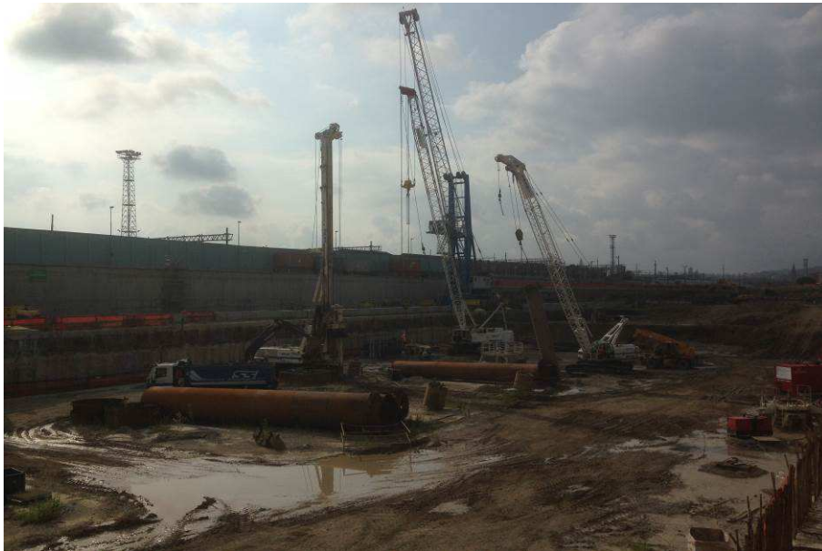
FOTO 1 – Realizzazione pali di fondazione Camerone
