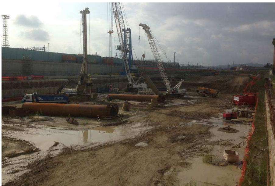
FOTO 1 – Realizzazione pali di fondazione Camerone
