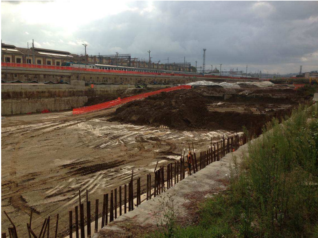
FOTO 2 – Scavo e allontanamento terre interne al camerone
