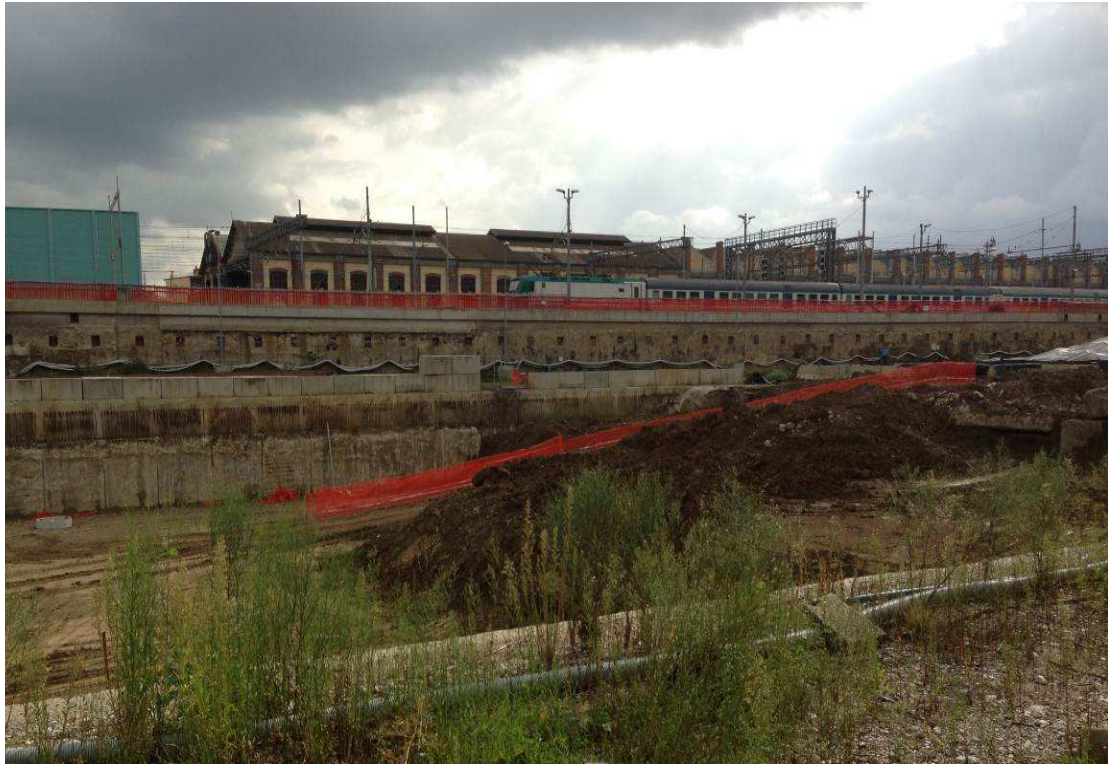
FOTO 2 – Scavo e allontanamento terre interne al camerone
