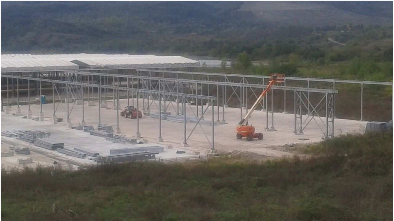
FOTO 1 – Montaggio coperture Piazzola 7
