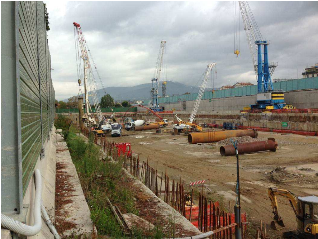
FOTO 1 – Realizzazione Pali Fondazione Camerone
