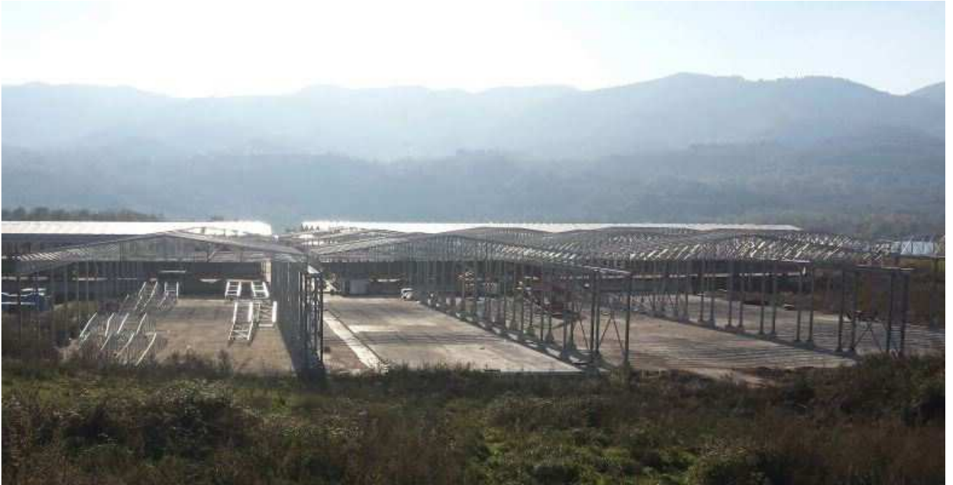
FOTO 1 – Montaggio coperture Piazzola 7 e 8
