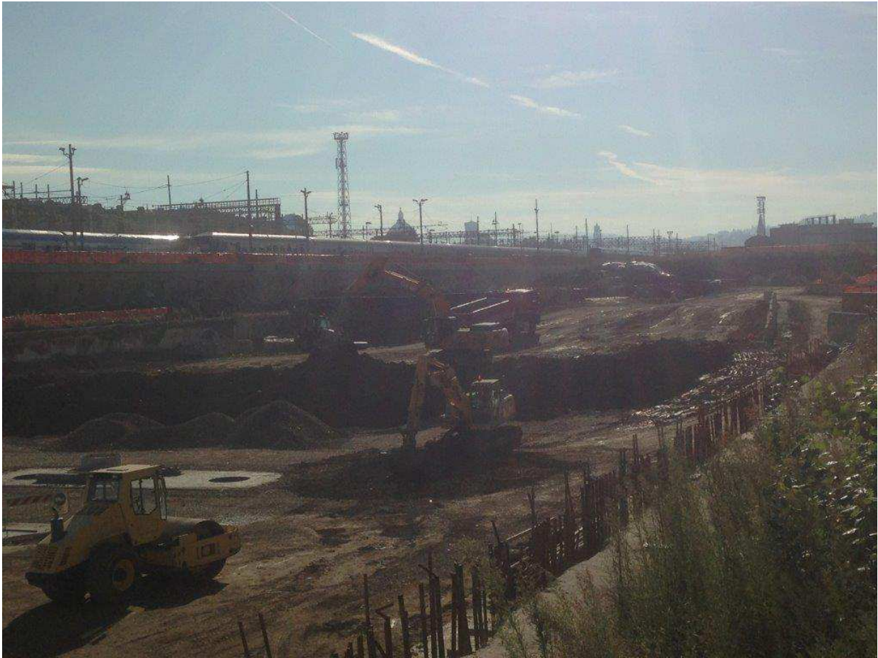
FOTO 2 – Scavo e allontanamento terre interne al camerone
