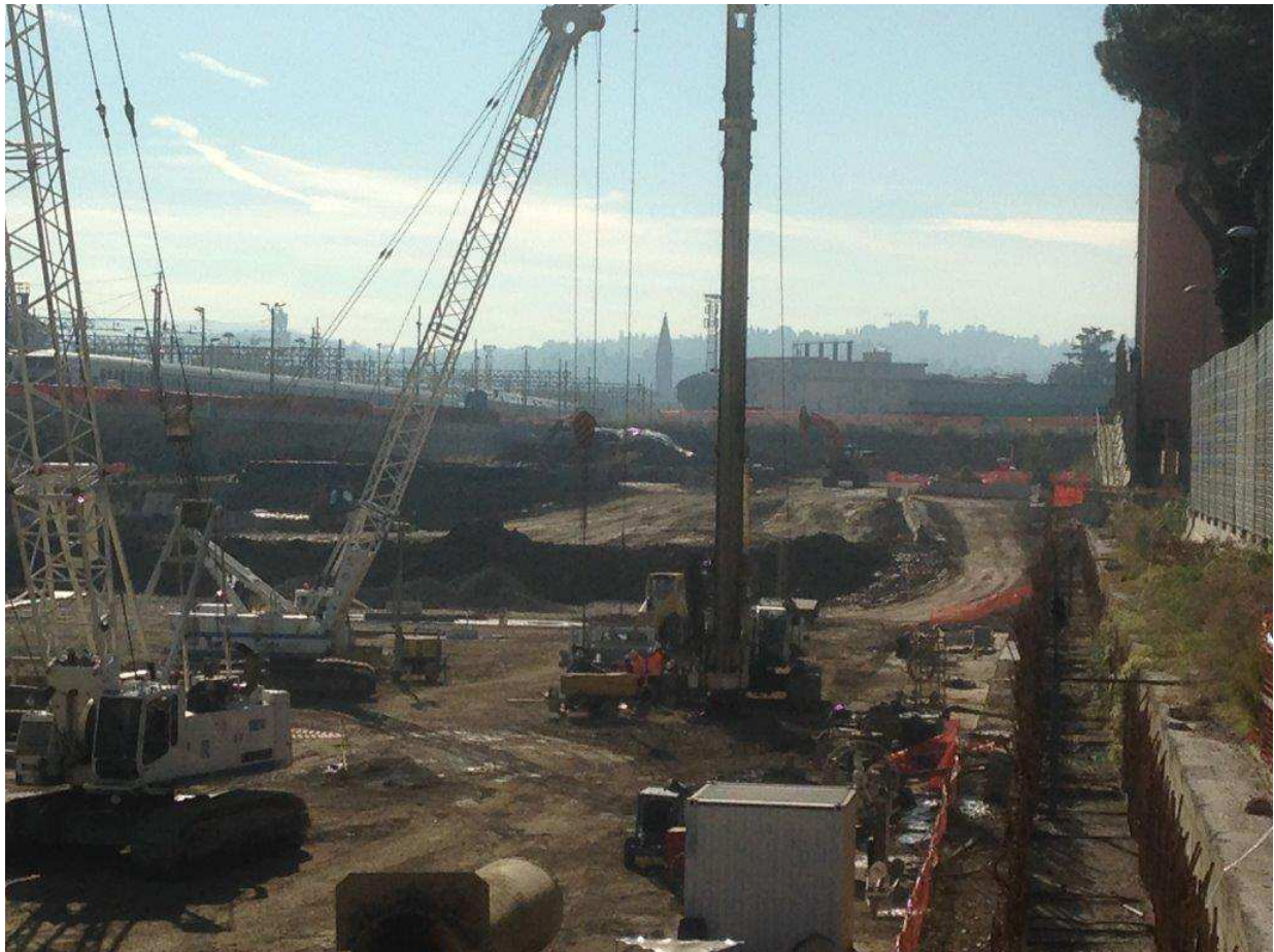
FOTO 1 – Realizzazione Pali Fondazione Camerone
