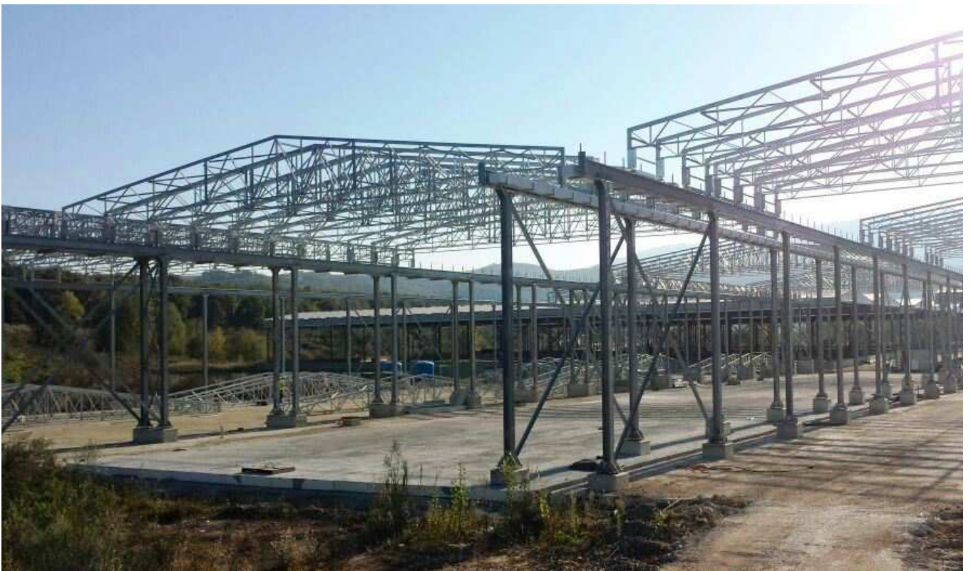
FOTO 2 – Montaggio coperture Piazzola 7 e 8
