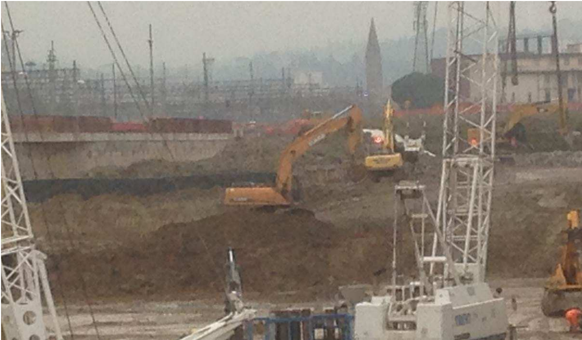
FOTO 2 – Scavo e allontanamento terre interne al camerone
