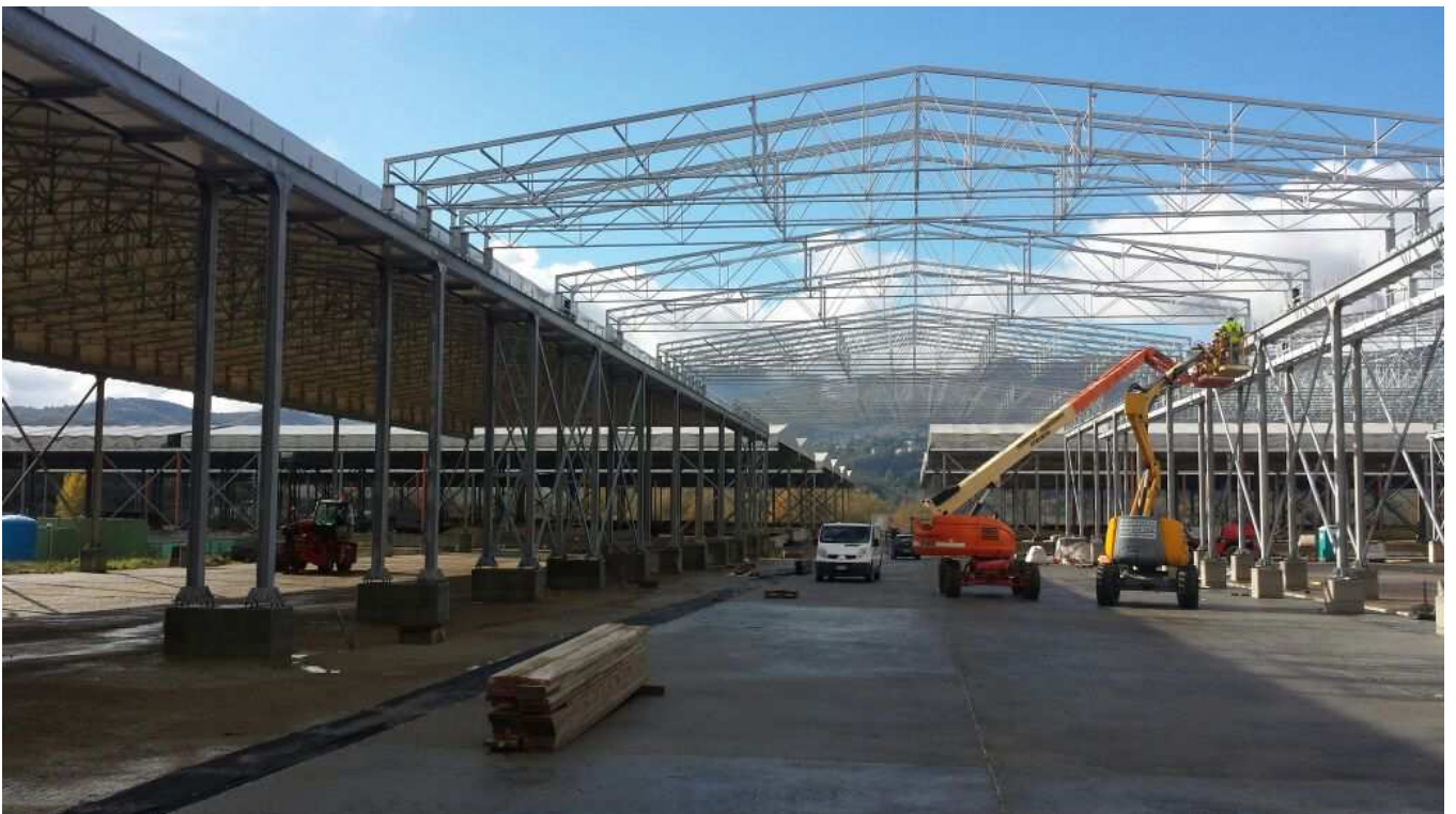
FOTO 2 – Montaggio coperture Piazzole 7 e 8
