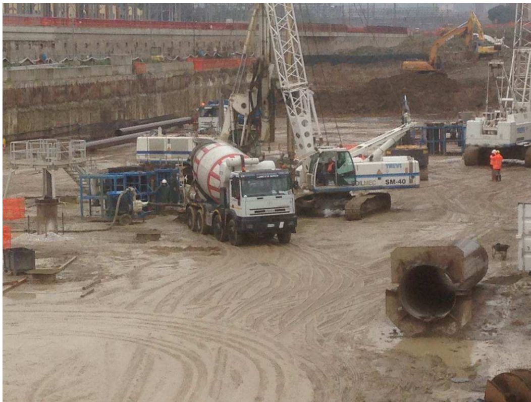
FOTO 1 – Realizzazione Pali Fondazione Camerone
