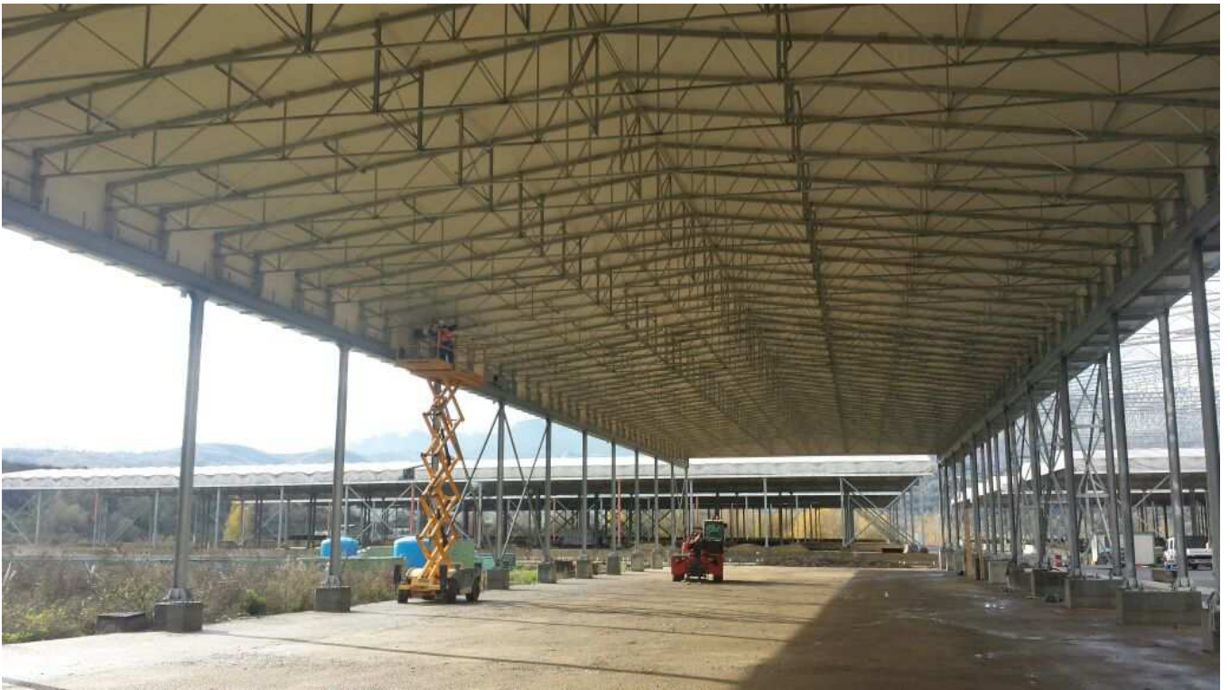
FOTO 1 – Montaggio coperture Piazzole 7 e 8
