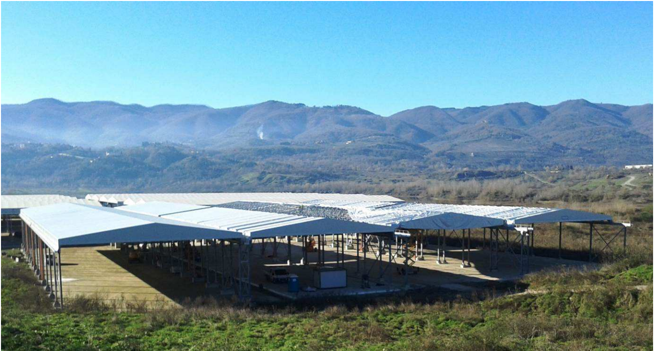
FOTO 1 – Montaggio coperture Piazzole 7 e 8
