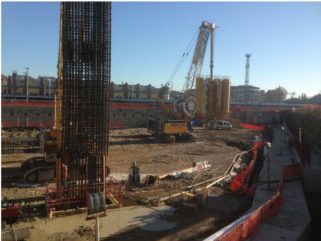
FOTO 3 – Esecuzione Diaframmi Camerone
