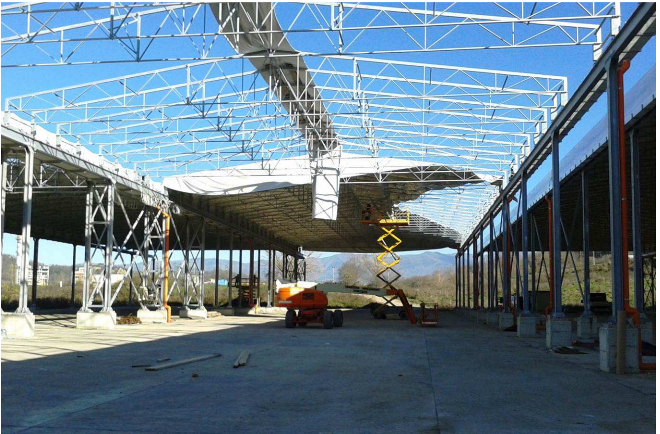
FOTO 2 – Montaggio coperture Piazzole 7 e 8
