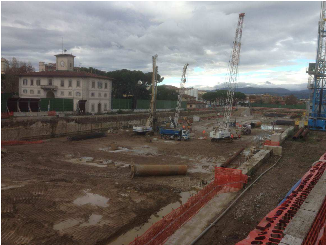
FOTO 1 – Realizzazione Pali Fondazione Camerone
