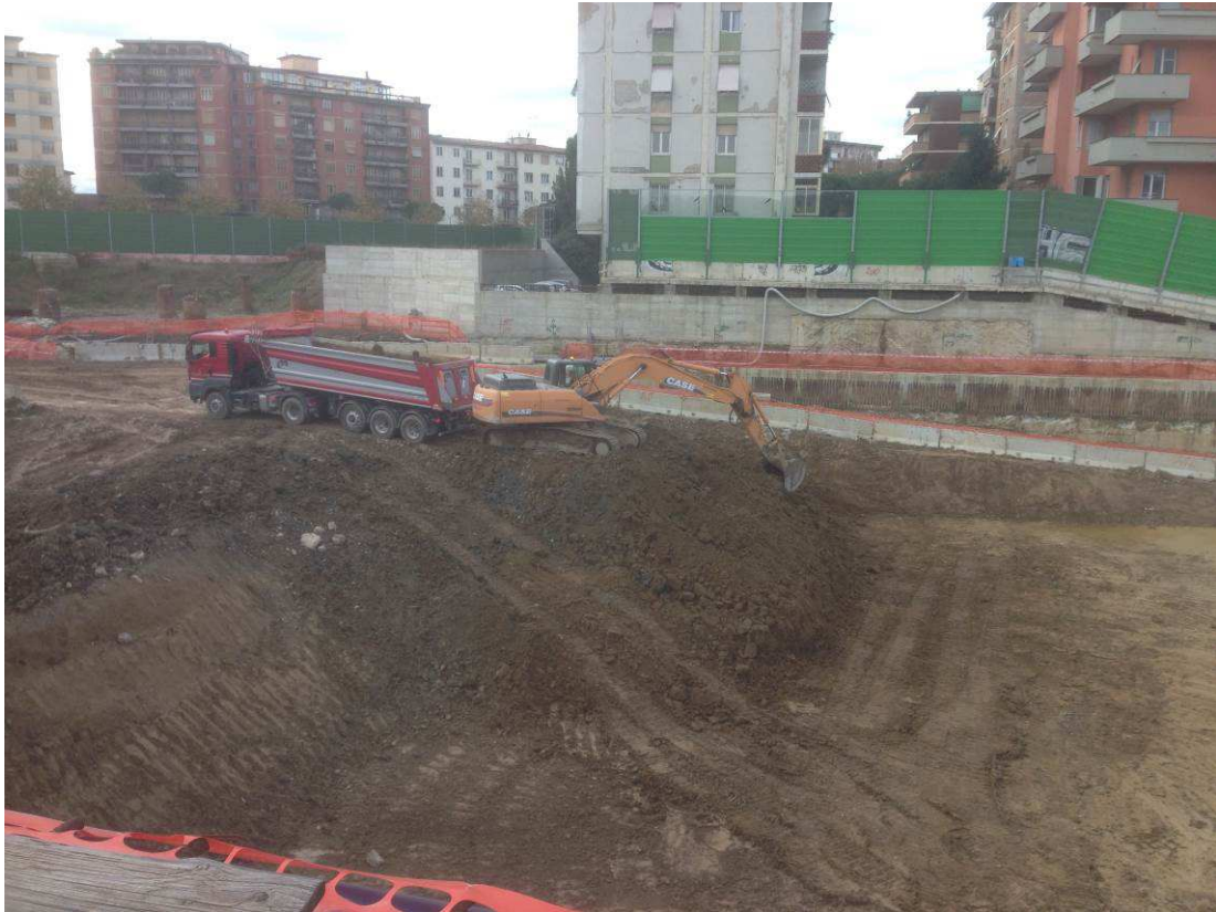
FOTO 2 – Scavo e allontanamento terre interne al camerone
