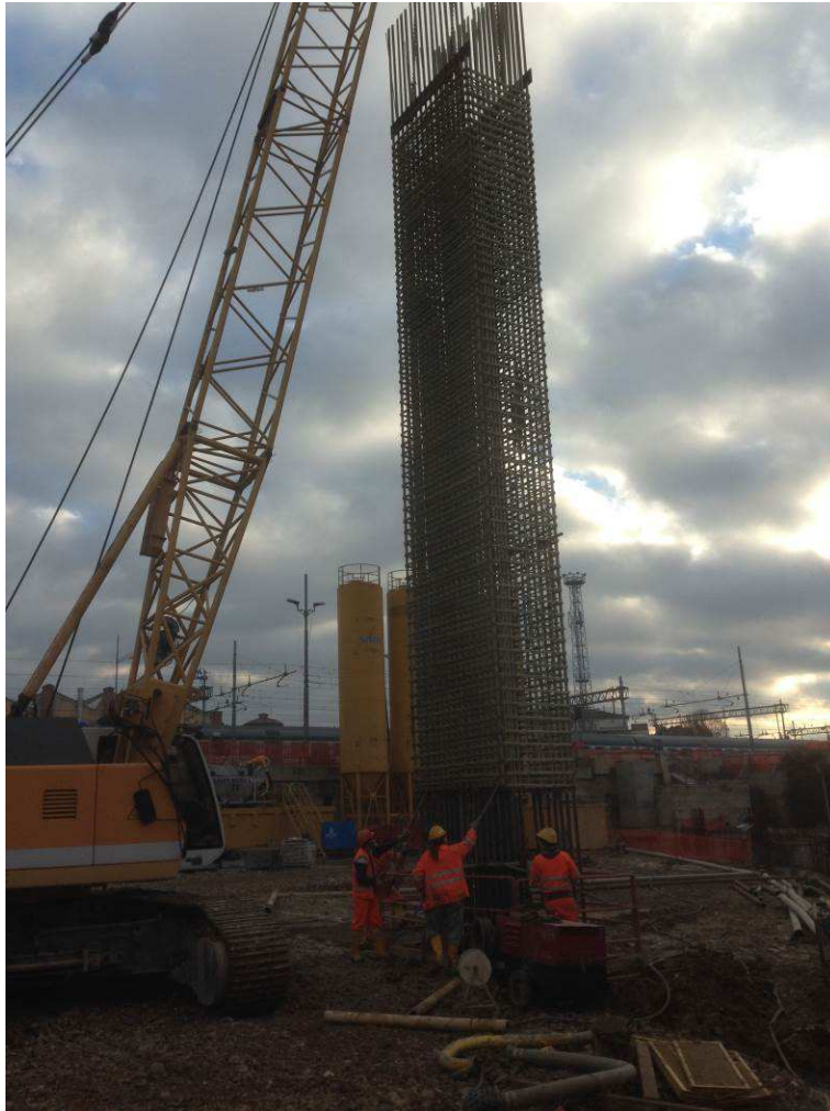
FOTO 2 – Esecuzione Diaframmi Camerone
