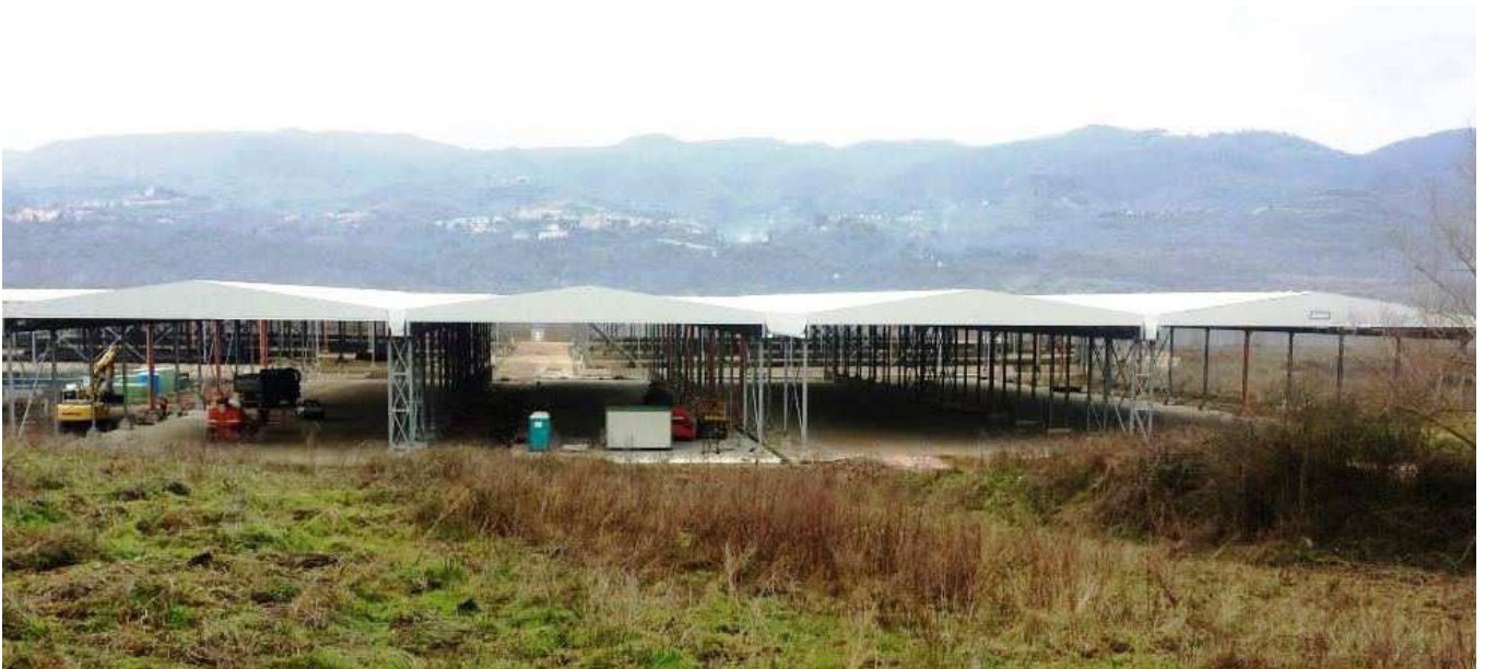
FOTO 1 – Montaggio coperture Piazzole 7 e 8
