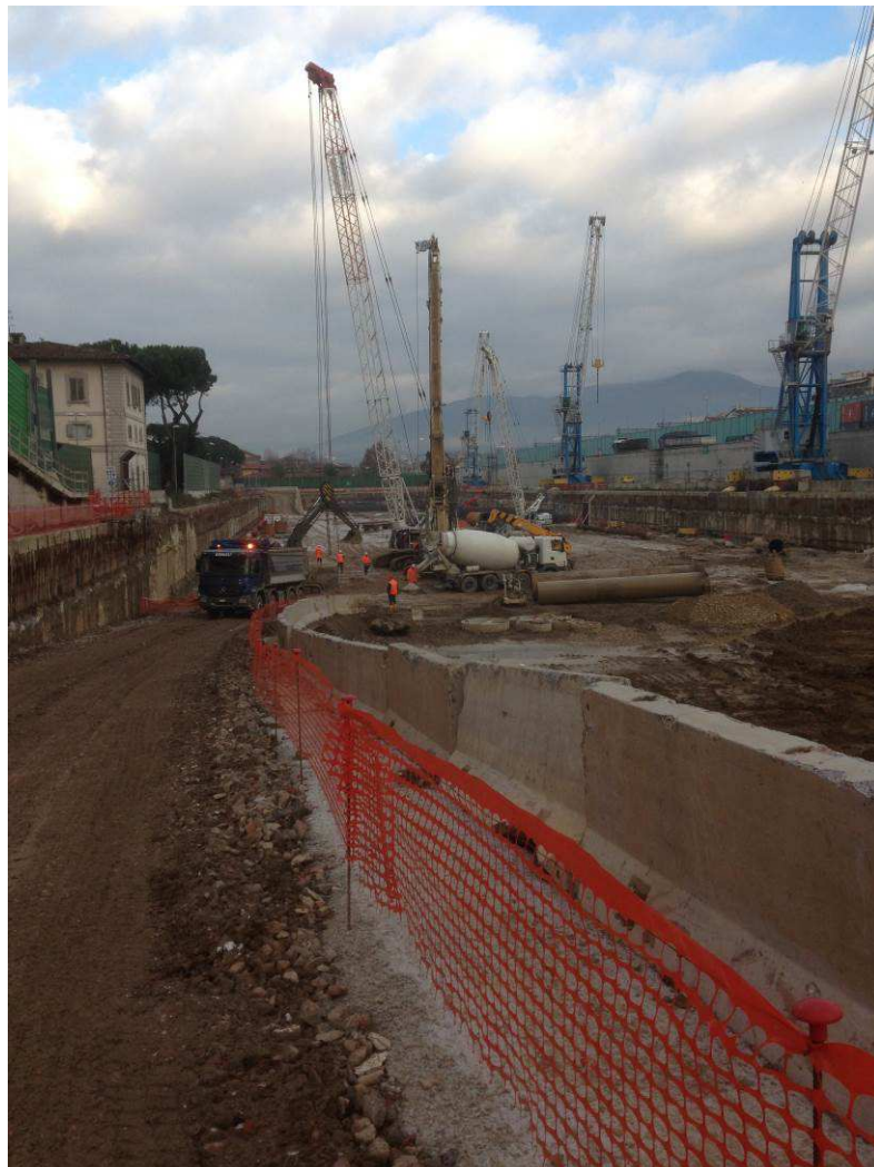
FOTO 1 – Realizzazione Pali Fondazione Camerone
