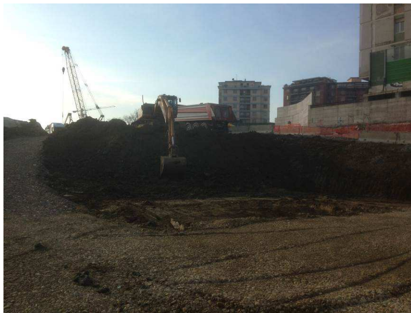
FOTO 3 – Scavo e allontanamento terre interne al camerone
