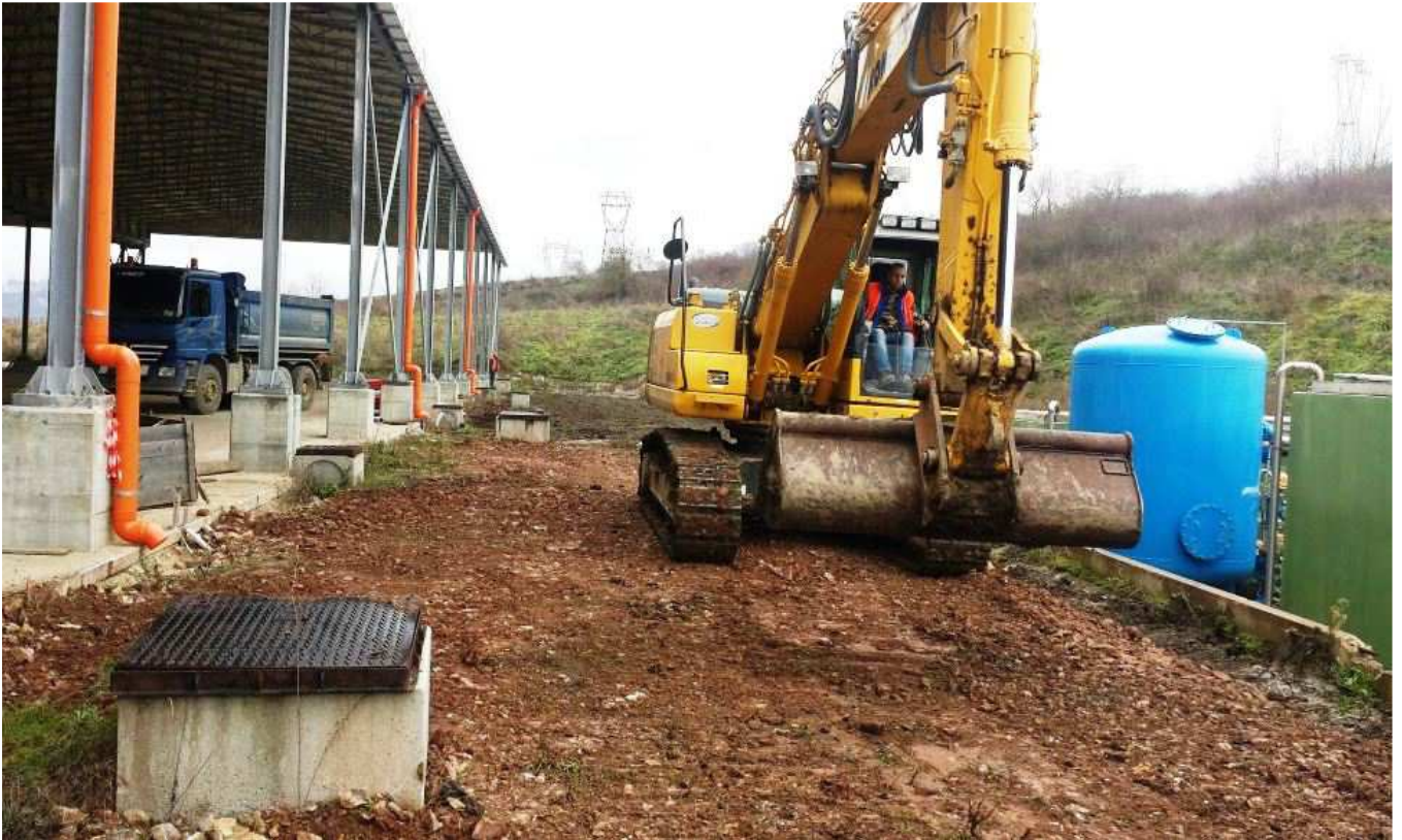
FOTO 2 – Completamento viabilità Piazzole 7 e 8
