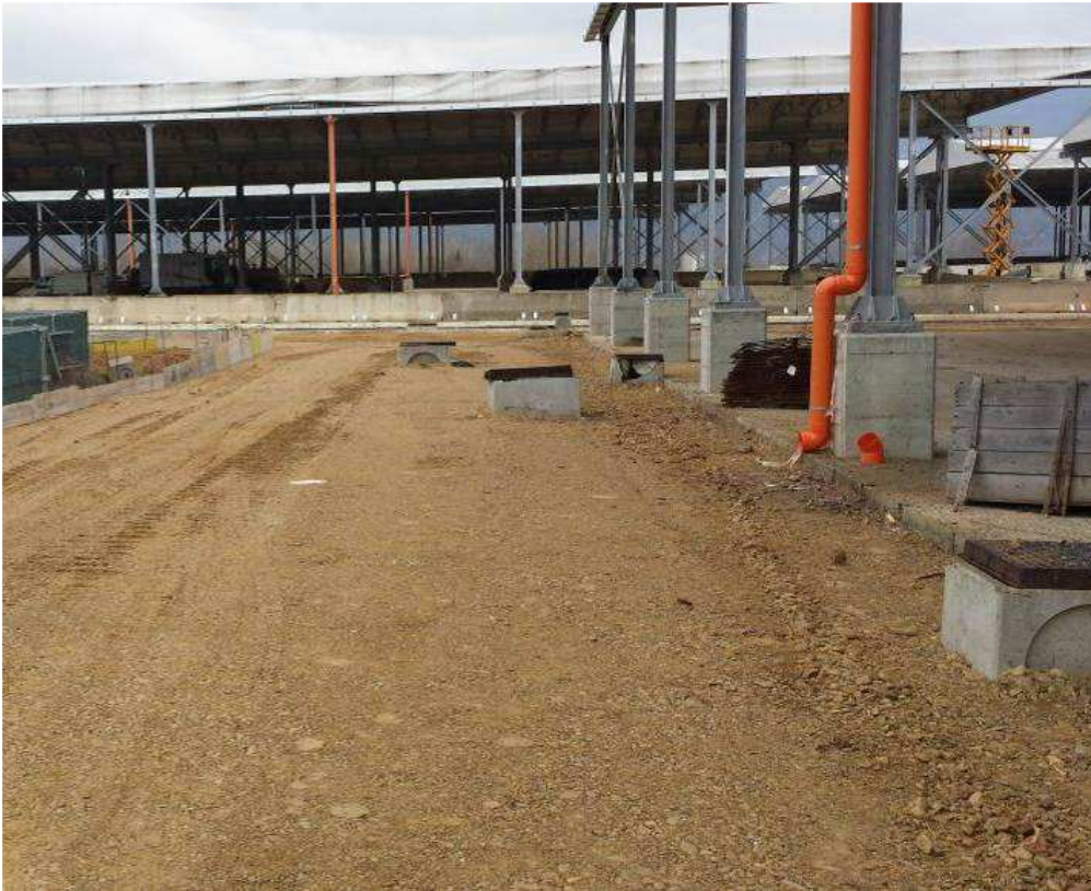
FOTO 2 – Completamento viabilità Piazzole 7 e 8
