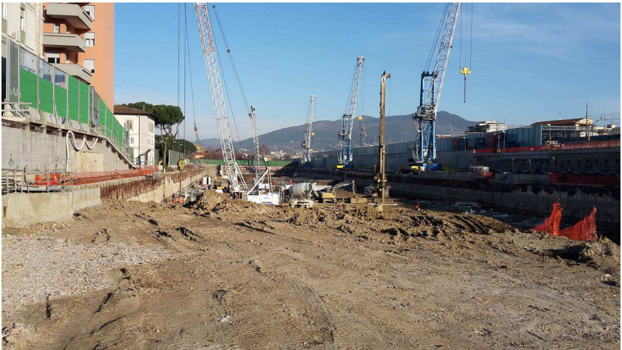
FOTO 1 – Realizzazione Pali Fondazione Camerone
