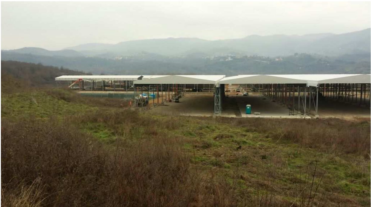
FOTO 1 – Montaggio coperture Piazzole 7 e 8
