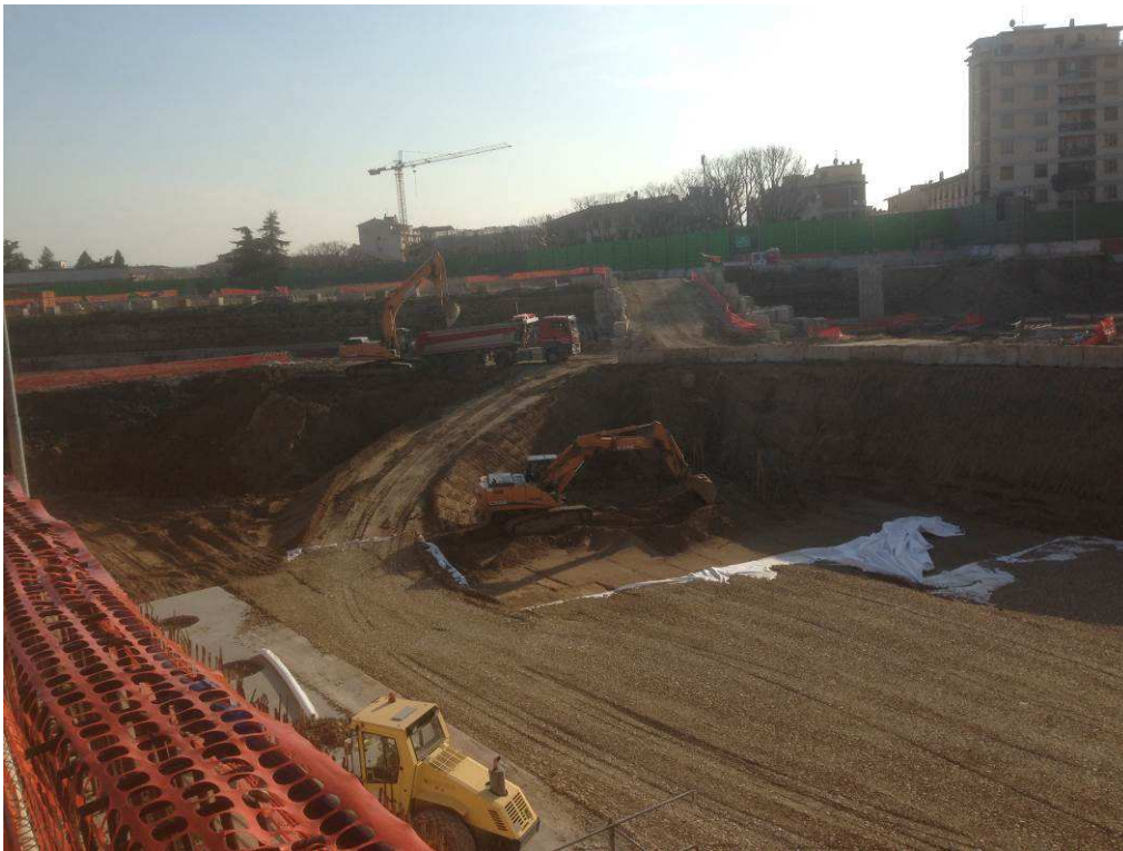
FOTO 1– Scavo all'interno del camerone di stazione
