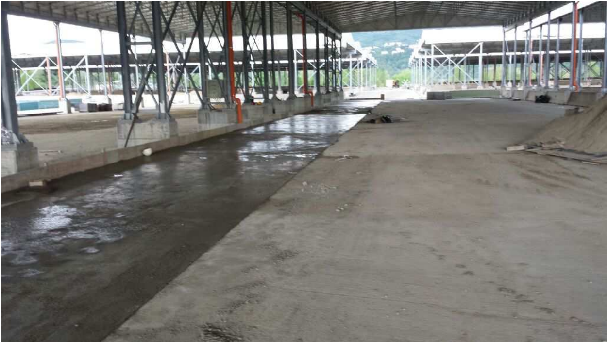
FOTO 1 – Completamento soletta pavimentazione Piazzola 8
