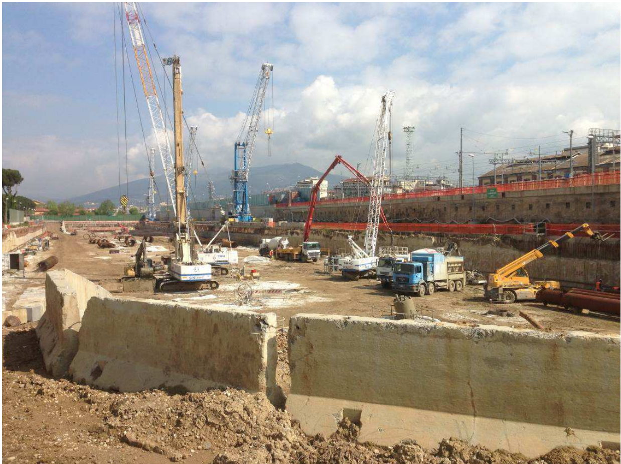
FOTO 1– Realizzazione Pali camerone di Stazione
