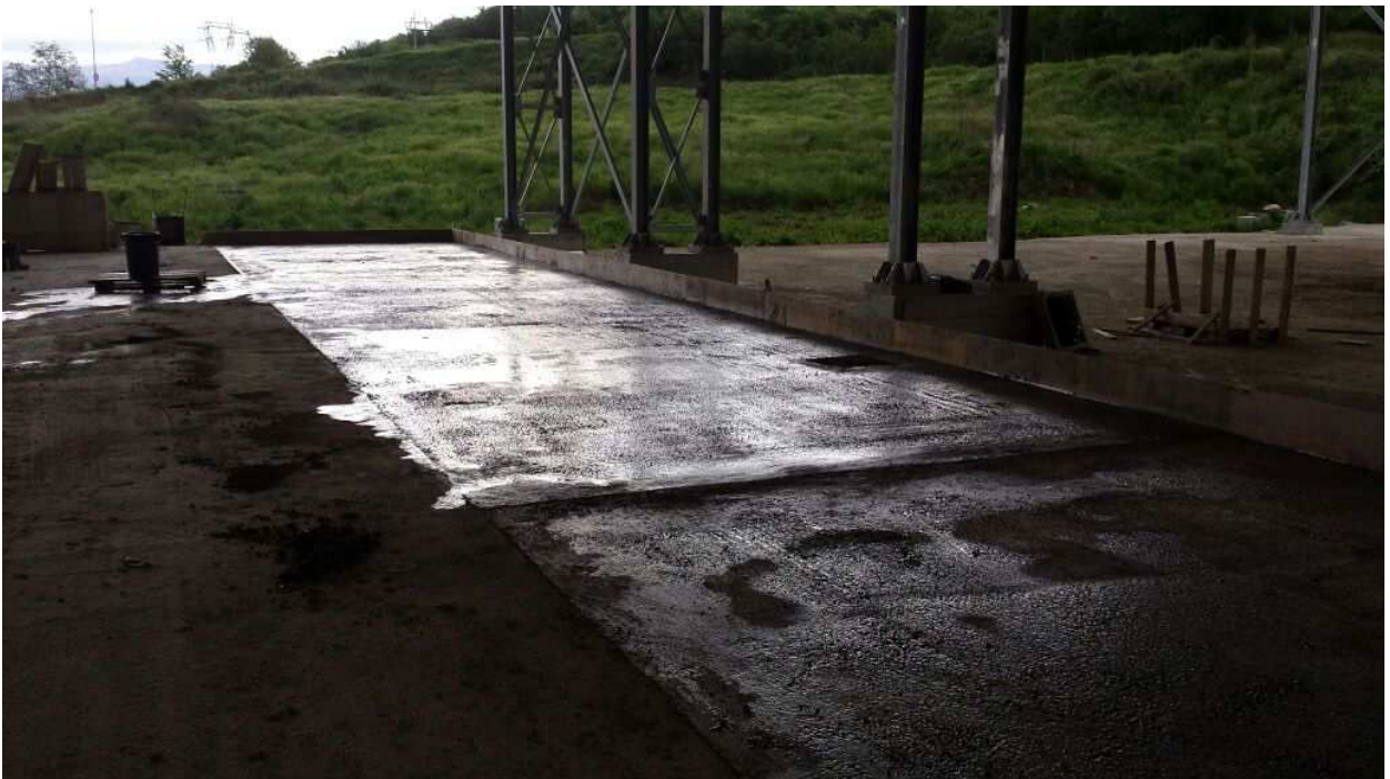
FOTO 2 – Completamento soletta pavimentazione Piazzola 8
