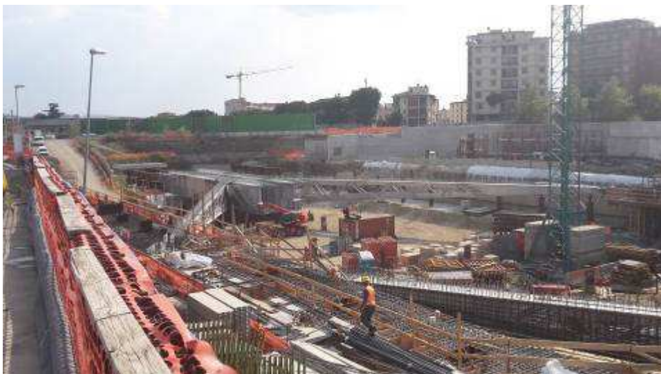
Foto 9 – Montaggio carpenterie metalliche Ventaglio Asse 33
