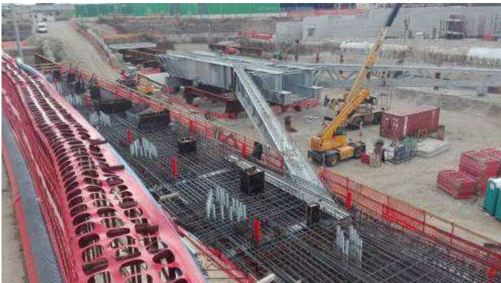
Foto 10 – Montaggio armatura Trave cuscino Fili 29-34 lato Est
