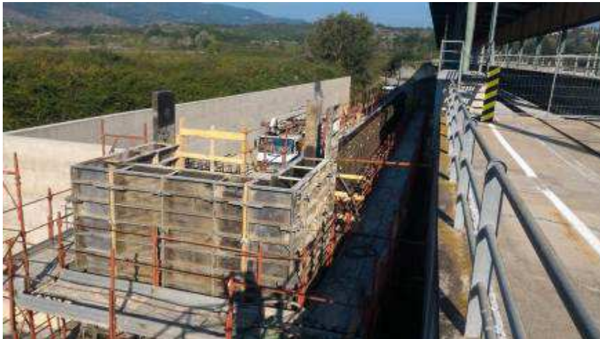
Foto 4 – Realizzazione Vasca di accumulo acque Collina Schermo
