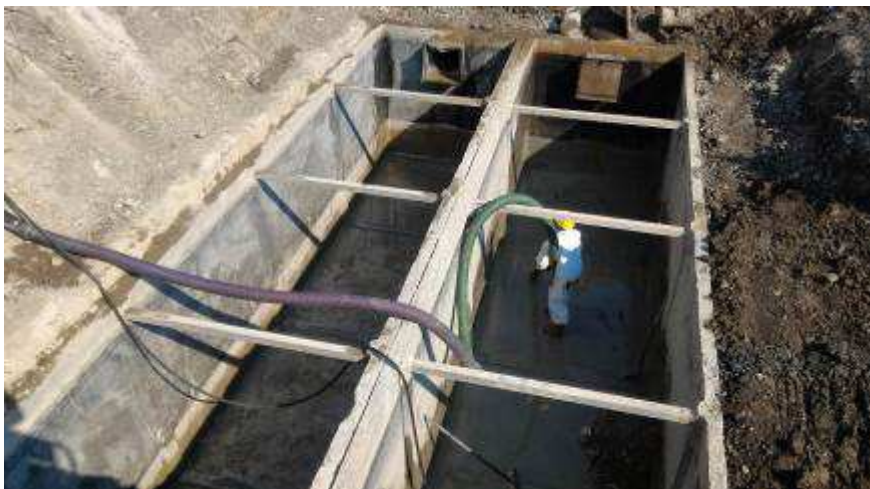
Foto 5 – Interventi per la Risoluzione della NC177
