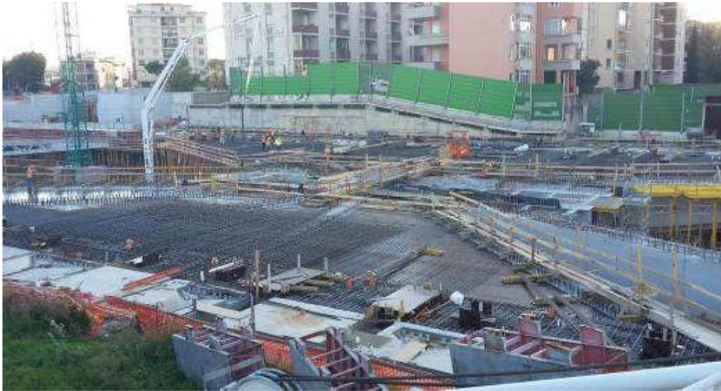
**Foto 5 – Banchinaggio e montaggio armatura solaio, Ventaglio Asse 25**
