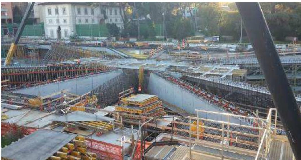
**Foto 3– Montaggio Casseratura e getto Travi intermedie e corte lato Est, Ventaglio Asse 17**
