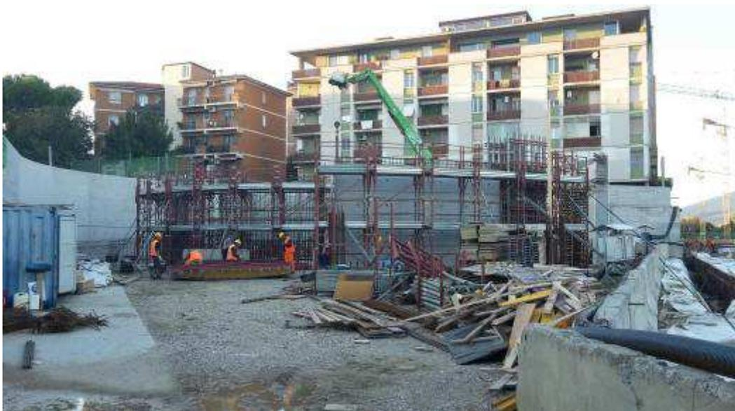
**Foto 10 – Montaggio casseri e getto Muro Rampa Kiss&Ride**
