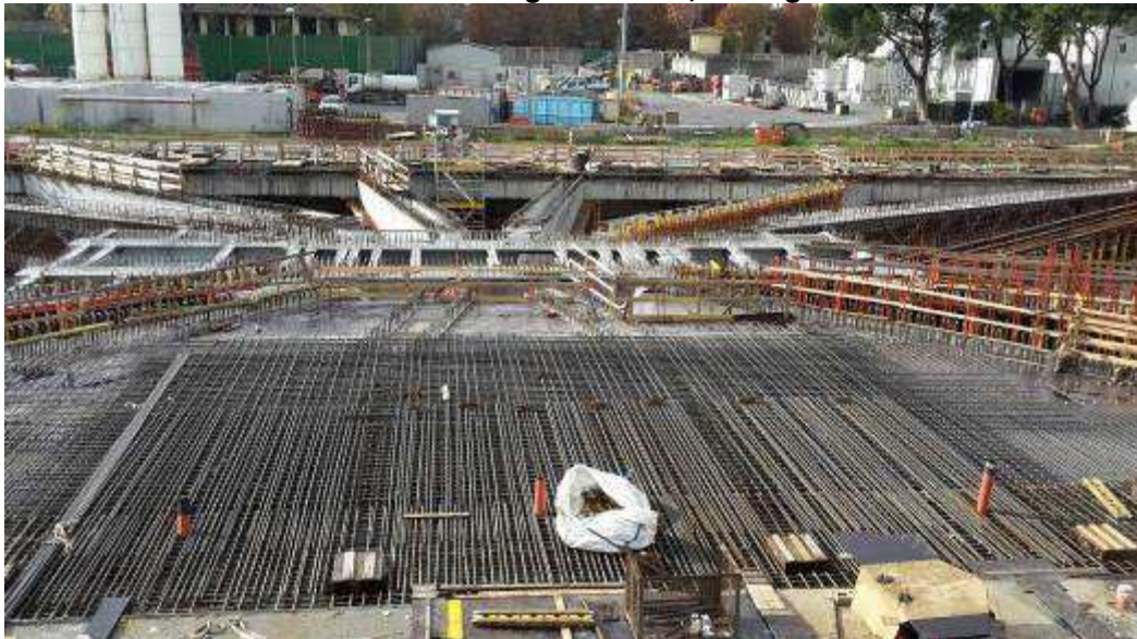
Foto 3 – Montaggio armatura soletta lato Est, Ventaglio Asse 9
