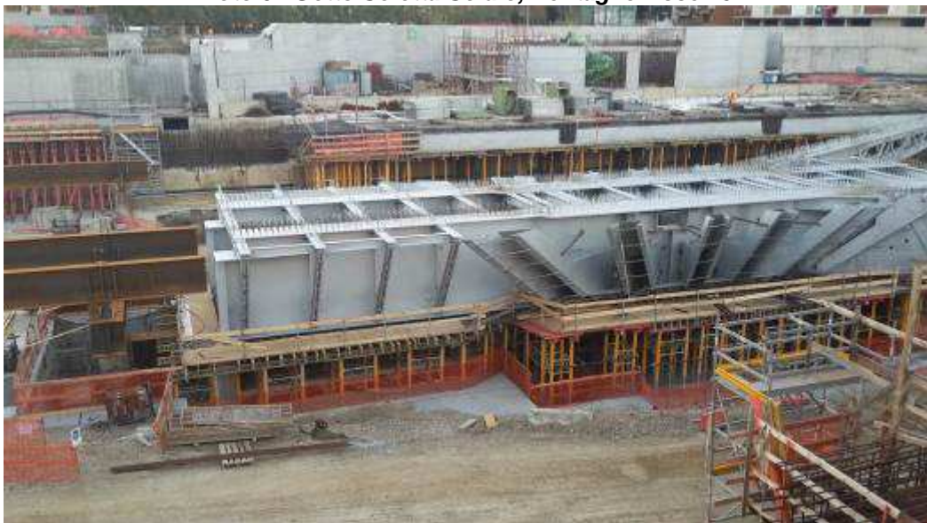
Foto 7 – Completamento armatura Fondo Cassone, Ventaglio Asse 33
