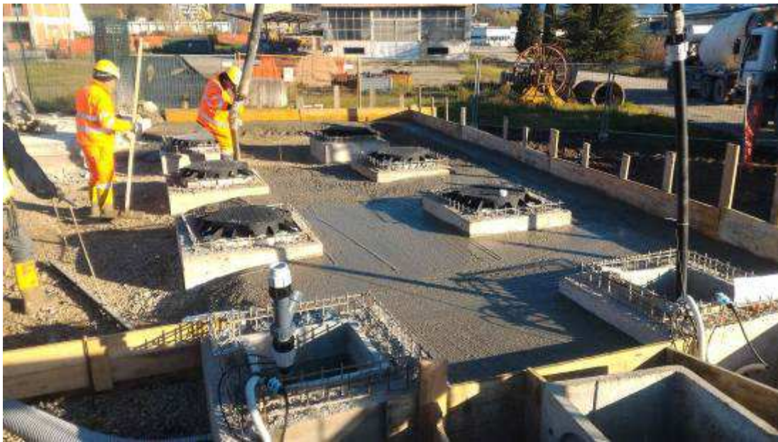
Foto 1 – Getto pavimentazione su Vasca di Prima Pioggia – NC177
