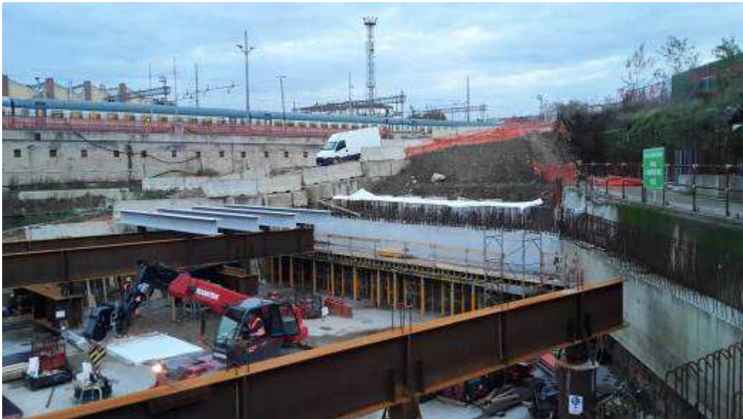
Foto 9– Getto Cordolo di Testa Diaframmi in Testata Sud-lato Sud
