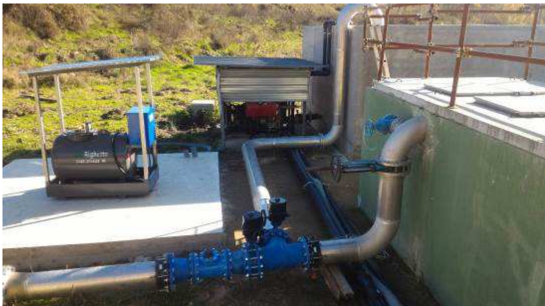
Foto 2 – Posa tubazione e valvole d'irrigazione Piazzole
