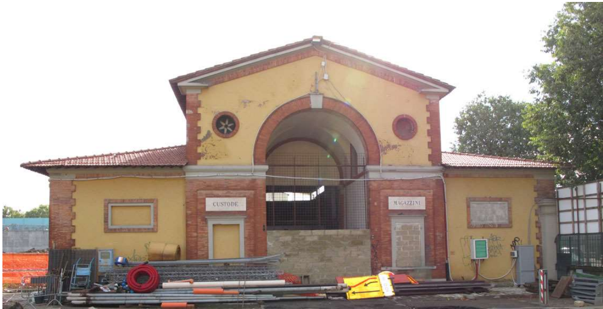
figura 4.3: Edificio n°177 – Vista prospetto Ovest (porzione in muratura)
