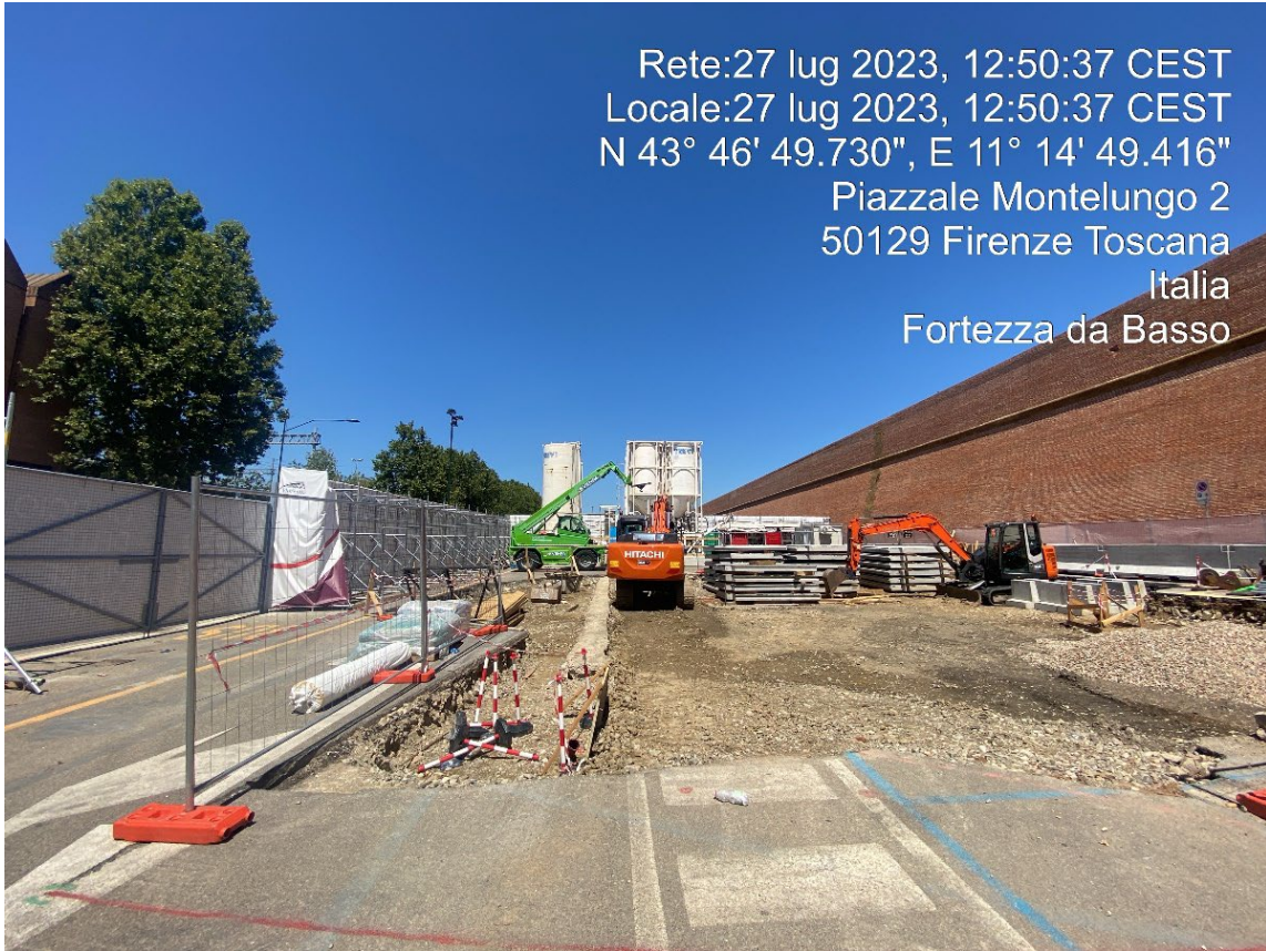
Figura 16 - Fortezza Area 4 - Attività di cantierizzazione
