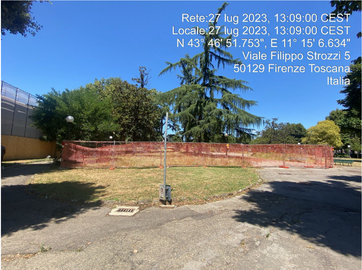
Figura 12 - Fortezza Area 1 – Montaggio recinzioni provvisorie per attività di cantierizzazione
