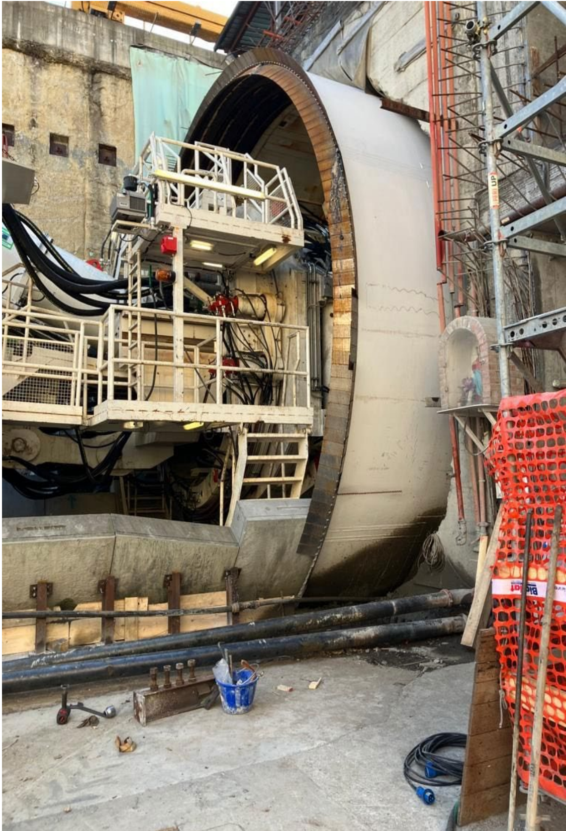
Figura 5 - Inizio Scavo Tampone
