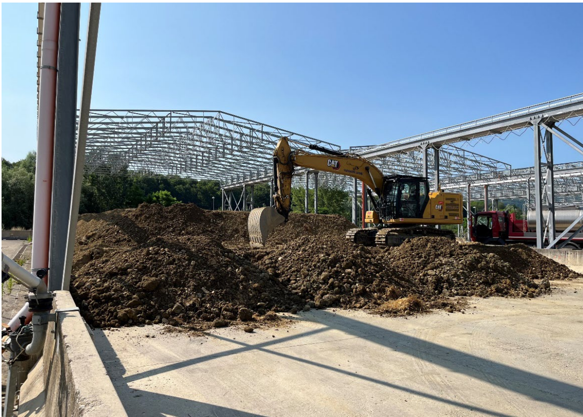
Figura 11 - Movimentazione terre nelle piazzole
