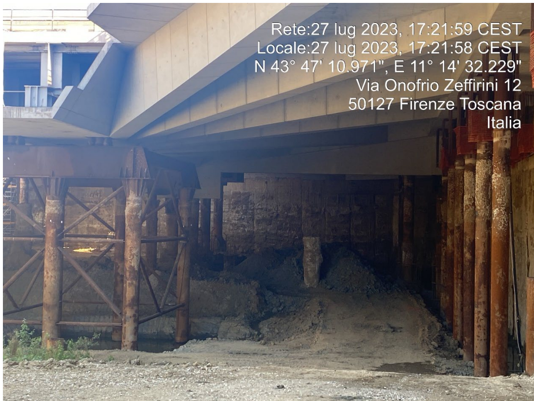
Figura 2 - Stazione AV Testata Sud
