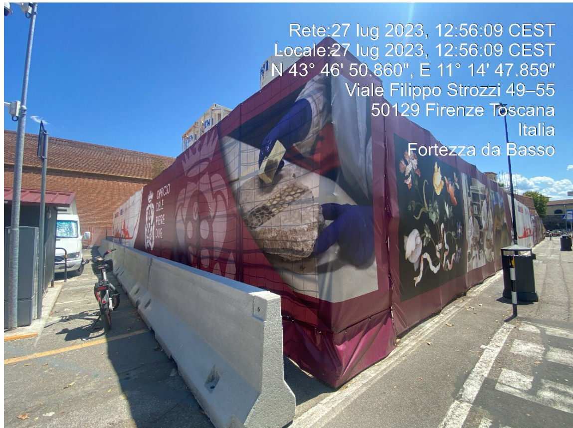
Figura 15 - Fortezza Area 4 - Installazione telo serigrafato e New Jersey di protezione
