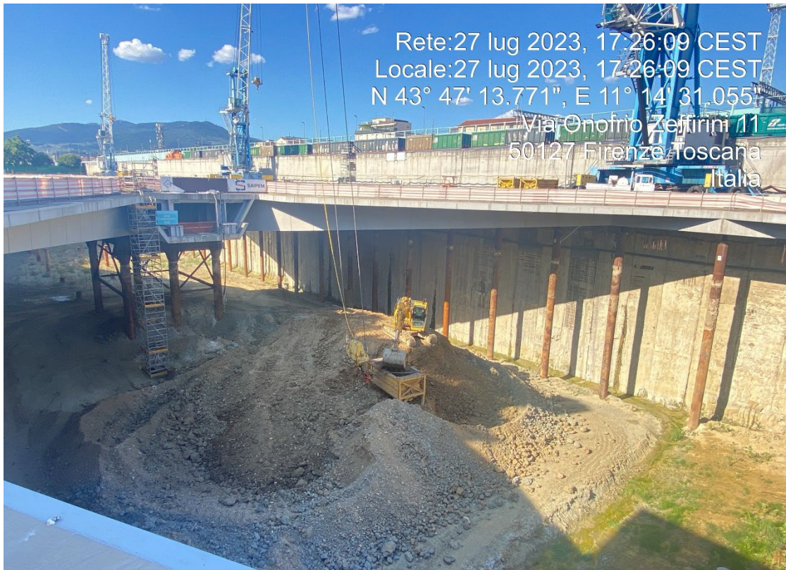
Figura 3 Stazione - Deposito materiale di accumulo proveniente da testata sud e carico sui cassoni
