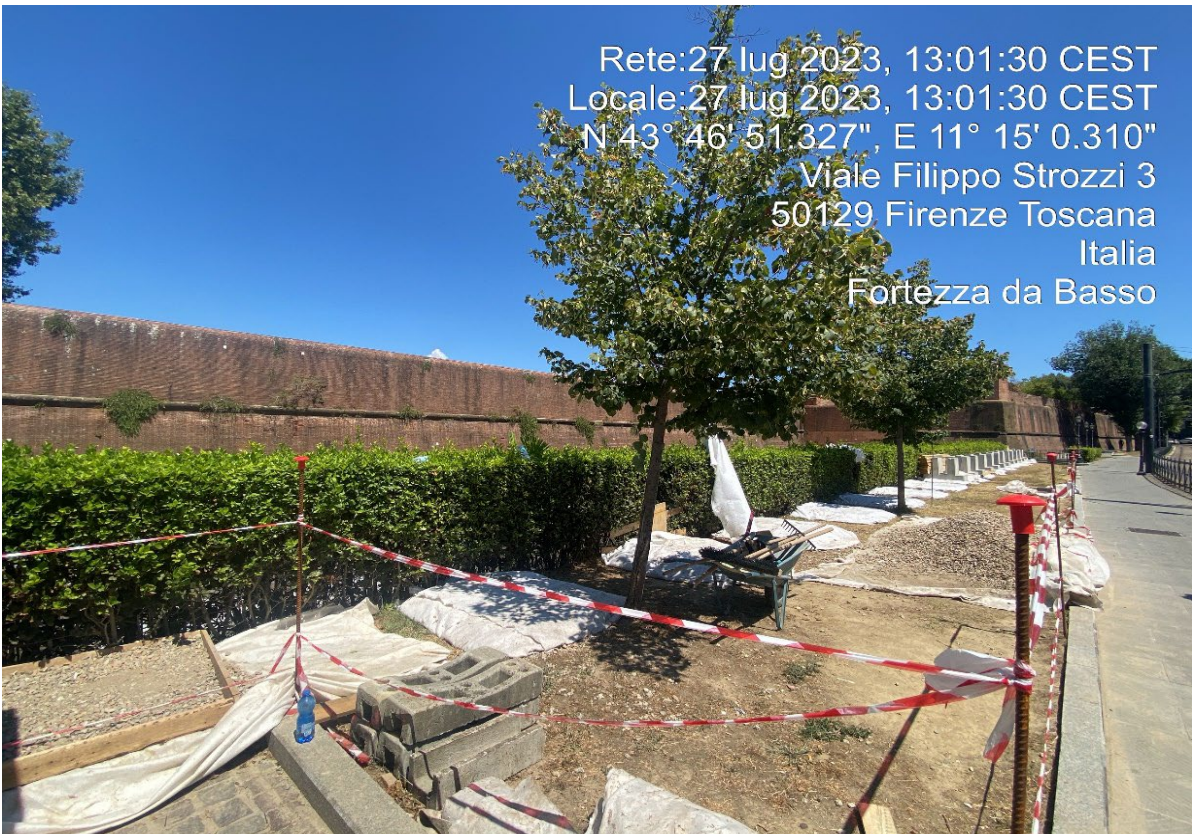
Figura 13 - Fortezza Area 2 - Attività di cantierizzazione
