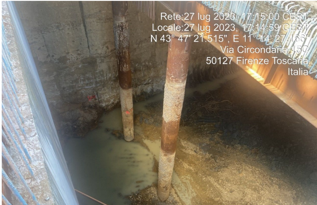
Figura 1 Stazione AV - Testata Nord
