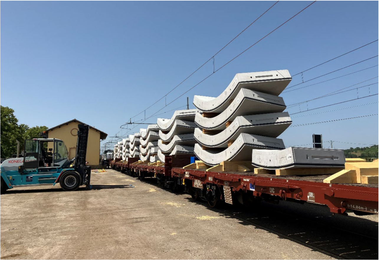
Figura 6 - Trasporto Conci via Treno dallo di Stabilimento Lucignano a CdM
