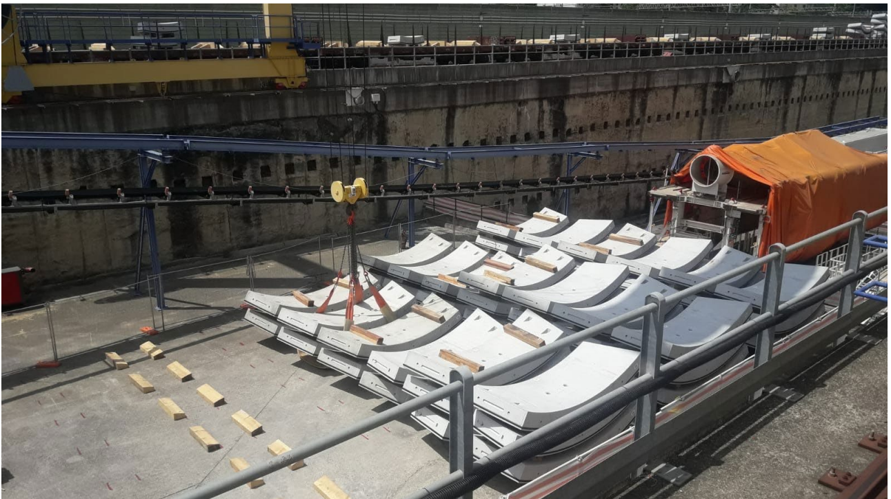
Figura 7 - Scarico e stoccaggio conci (CdM)
