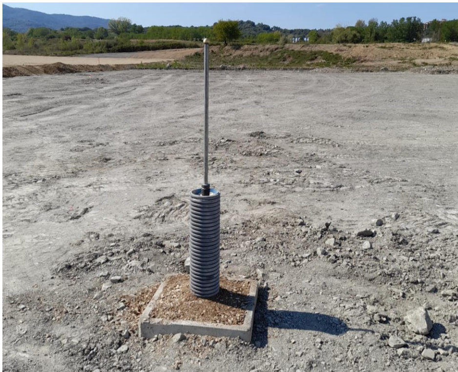
Foto 09 – posizionamento assestmetro per attività di monitoraggio
