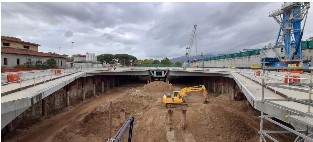
Foto 01 – attività di scavo (1° strato su terra – da quota 41 m s.l.m. a quota + 37 m sl.m.)
