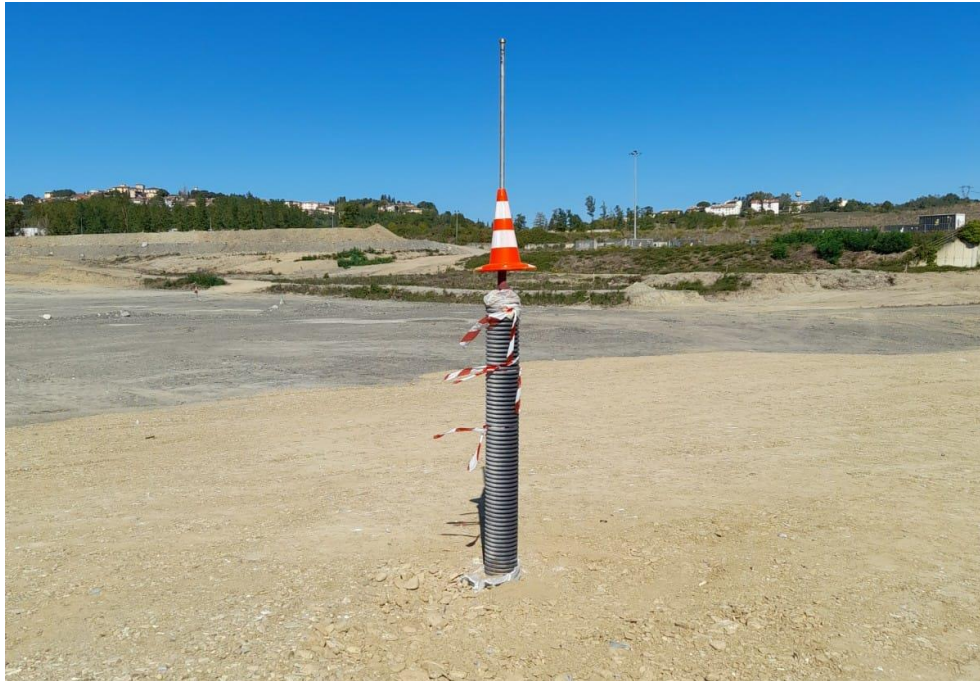
Foto 09 – posizionamento assestimetro per attività di monitoraggio
