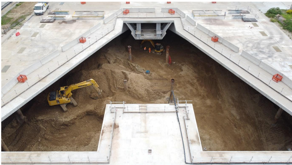
Foto 02 – attività di scavo (1° strato su terra – da quota 41 m s.l.m. a quota + 37 m sl.m.)
