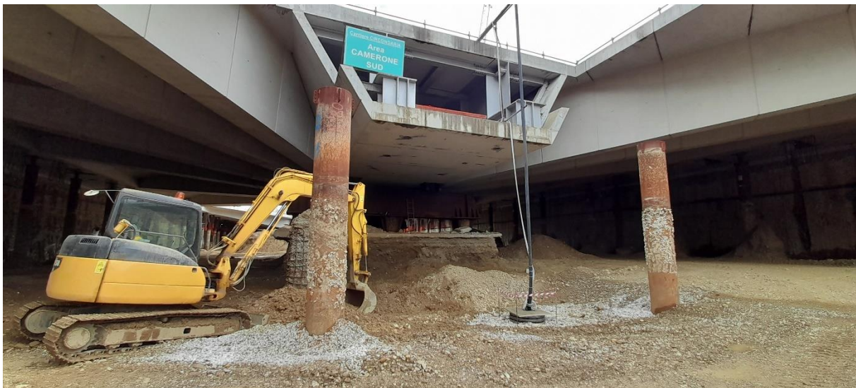
Foto 06 – Aggottamento dell'acqua tramite il sistema di pompe
