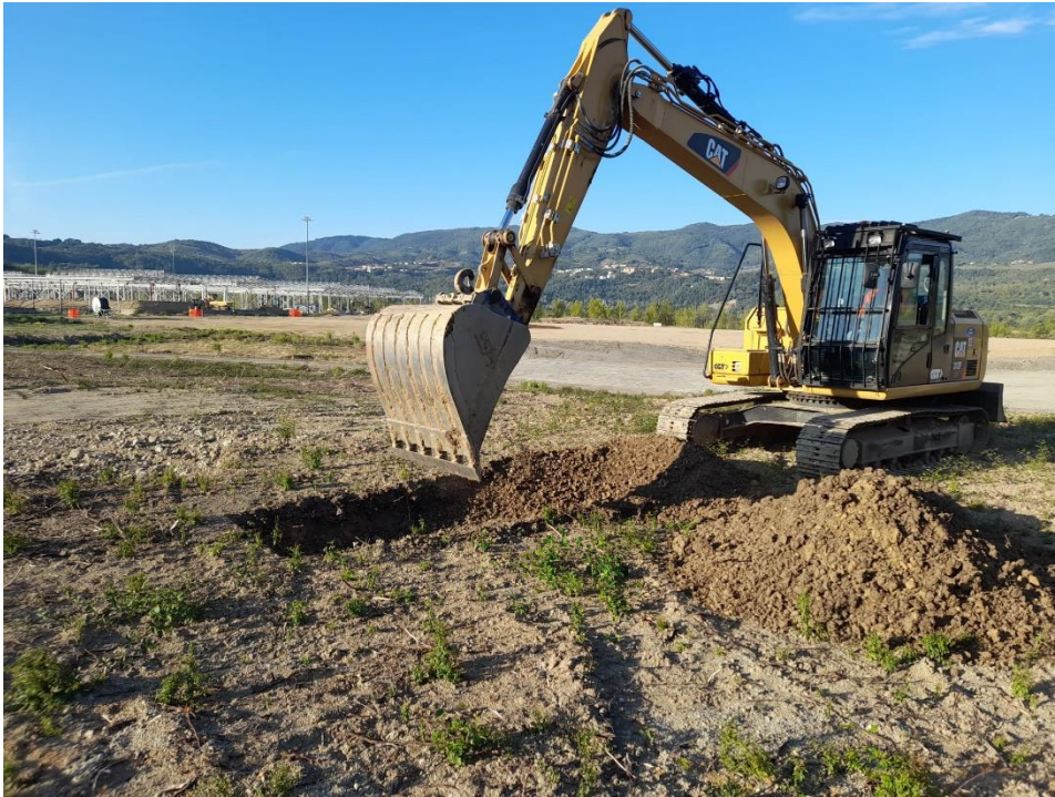
Foto 08 – scarifica impronta collina schermo
