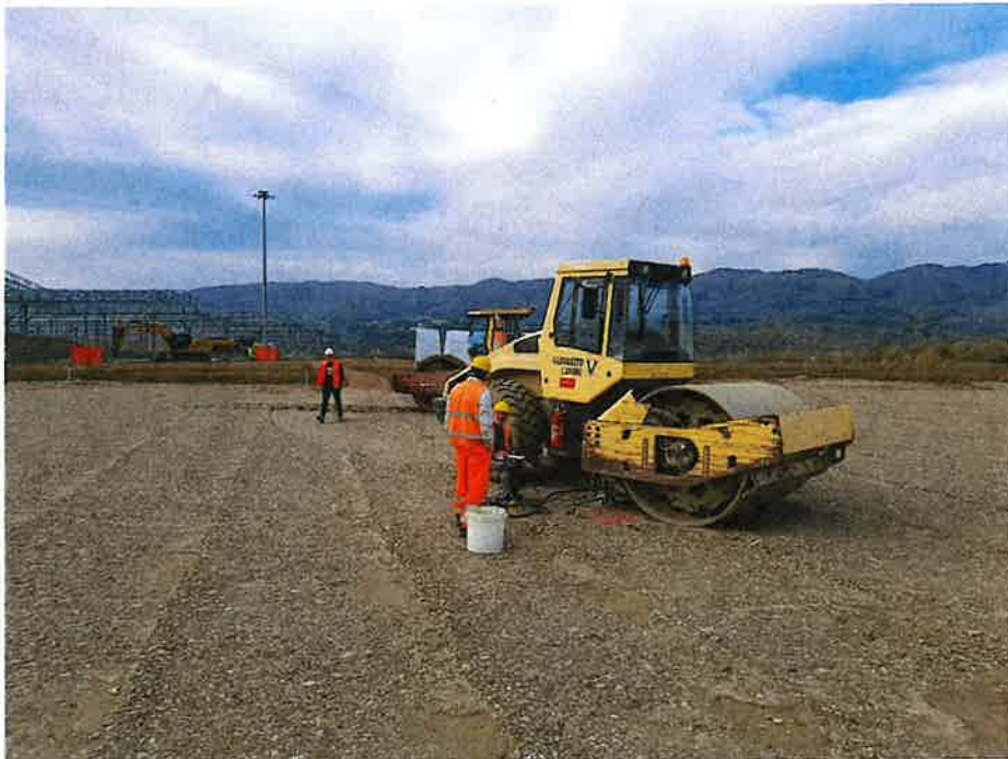
Foto 08 – Esecuzione prove di compattazione collina schermo
