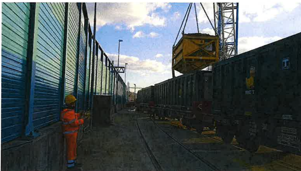
Foto 03 – coordinamento per riempimento containers ferroviari
