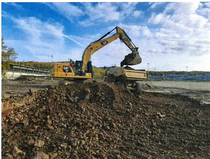
Foto 11 – Attività di scarifica collina schermo
