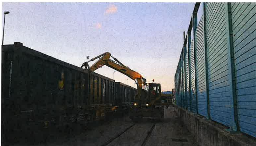
Foto 05 – attività di spianamento terra propedeutica alla partenza del treno
