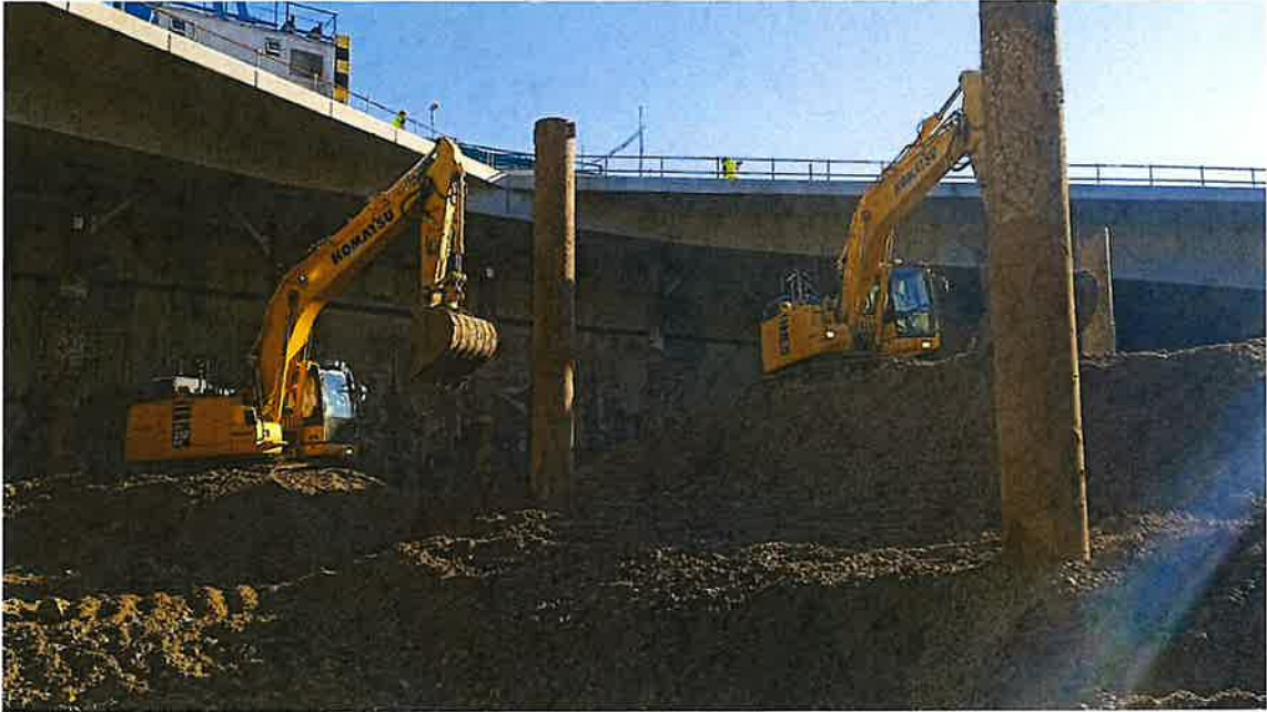
Foto 05 – attività di scavo e realizzazione cumuli
