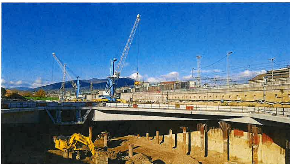
Foto 01 – attività di scavo e caricamento tramite Gru (2° strato su terra – da quota 37 m s.l.m. a quota + 35 m s.l.m.)
