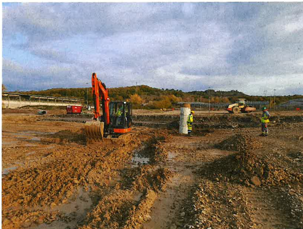
Foto 10 – Attività di scarifica collina schermo
