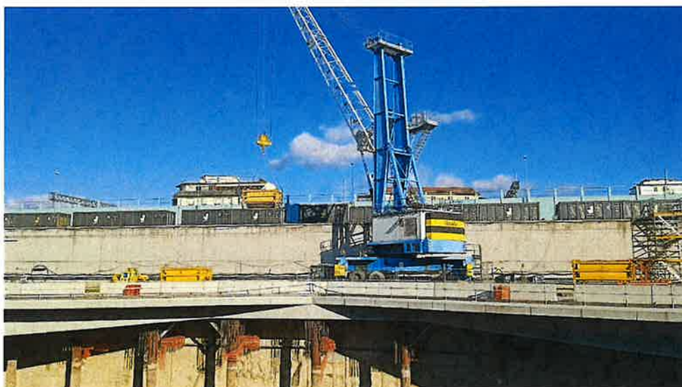
Foto 02 – attività di riempimento containers ferroviari
