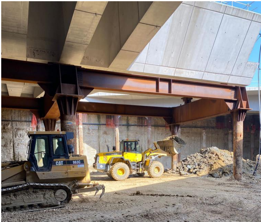
Movimentazione delle terre
