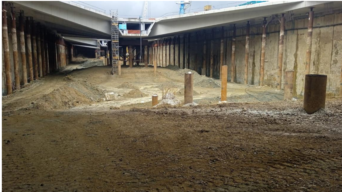
Abbassamento fondo scavo (quota 33 m s.l.m. - quota 31 m s.l.m.)
