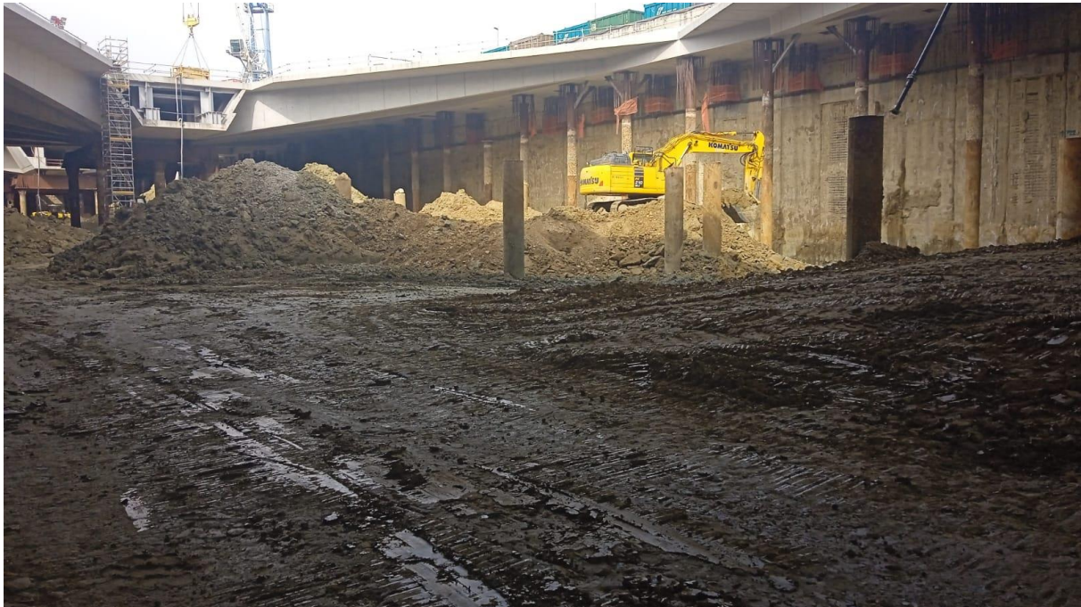
Creazione cumuli presso il camerone della Nuova Stazione AV
