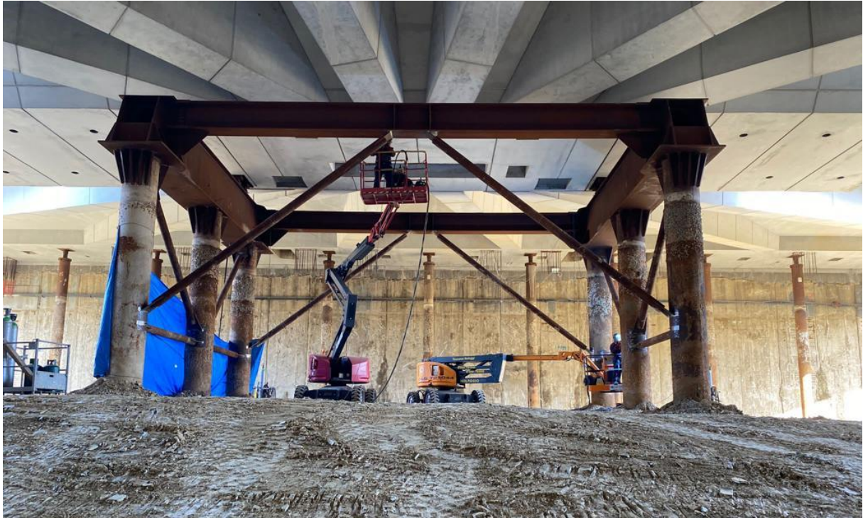
Installazione carpenteria metallica provvisoria
