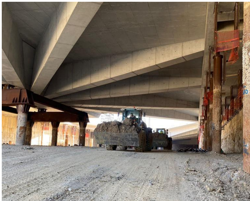
Movimentazione delle terre
