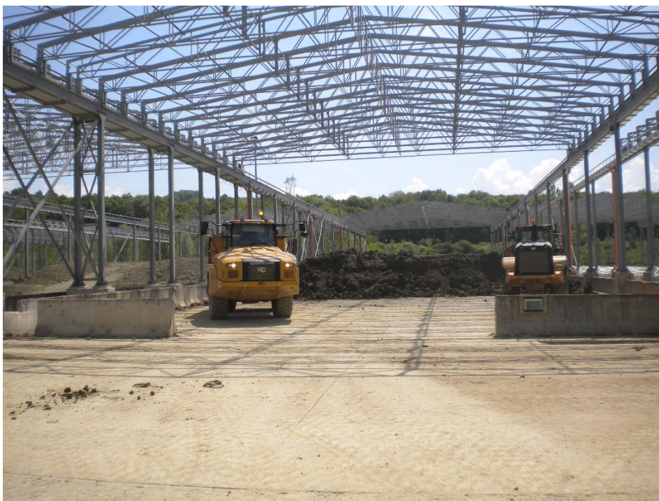
Attività di scarico presso la piazzola di caratterizzazione
