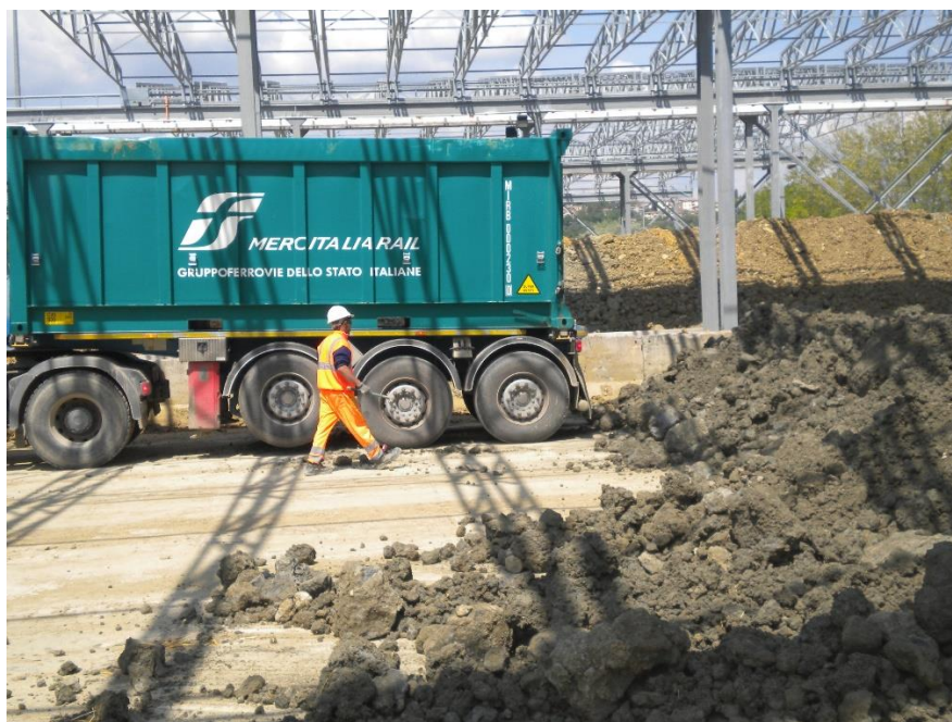
Attività di scarico delle terre presso le piazzole di caratterizzazione
