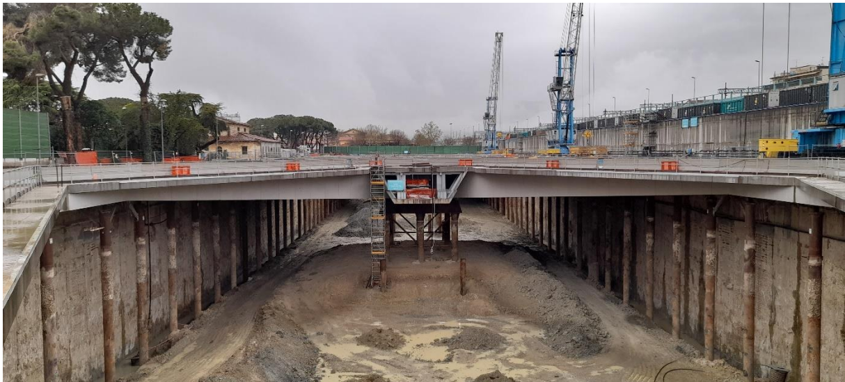
Abbassamento fondo scavo Nuova Stazione AV (quota 33 m s.l.m. - 31 m s.l.m.)
