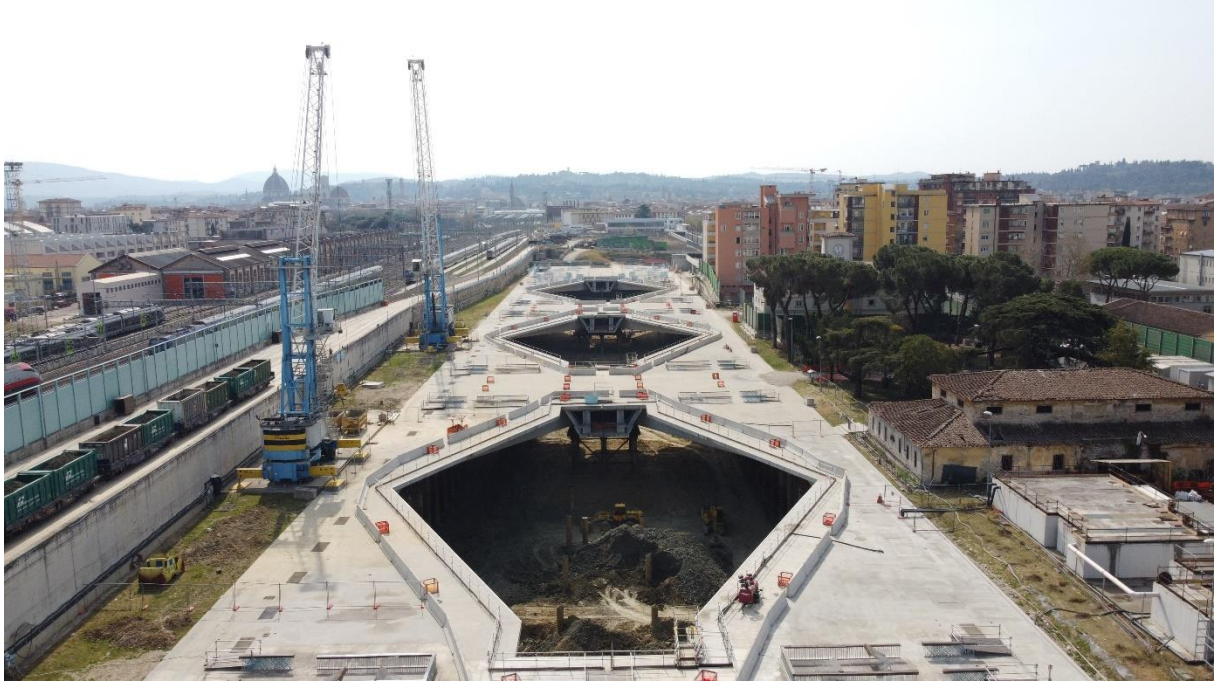
Attività di scavo e carico presso la Nuova Stazione AV (quota 33 m s.l.m. - quota 31 m s.l.m.)
