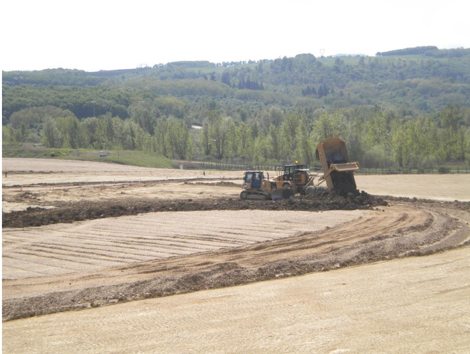
Attività di abbancamento delle terre presso la collina schermo
