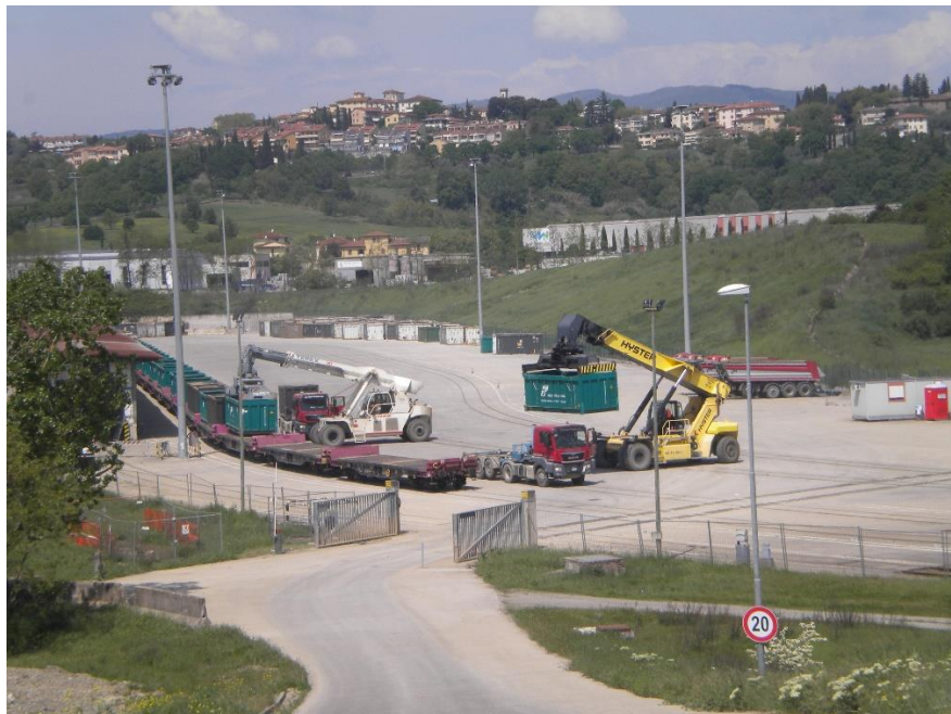
Attività di scarico dei cassoni ferroviari tramite l'ausilio di mezzi Stacker e successivo ricarico degli stessi sui bilici, ai fini dello scarico delle terre presso le piazzole di caratterizzazione
