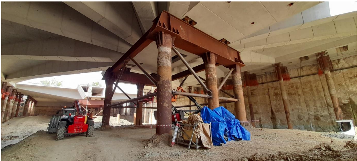
Posa in opera carpenteria metallica provvisoria
