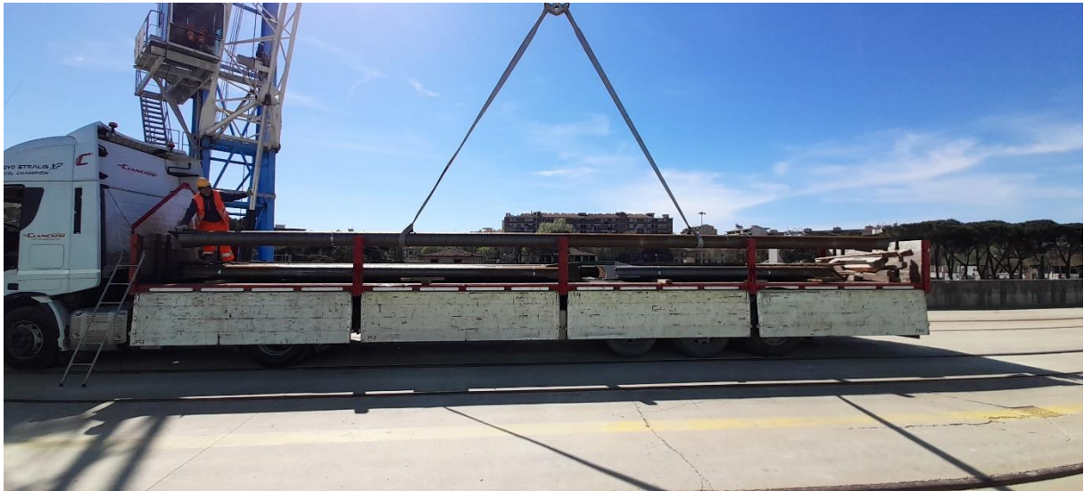
Movimentazione carpenteria metallica provvisoria
