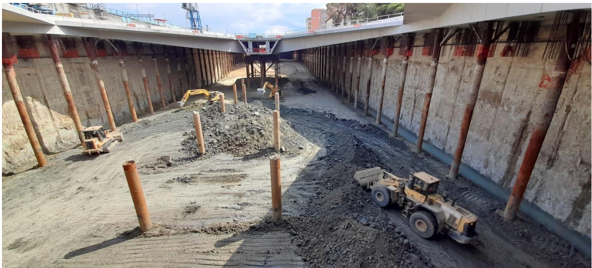
Creazione dei cumuli presso il camerone della Nuova Stazione AV
