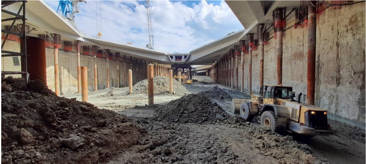
Creazione cumuli presso il camerone della Nuova Stazione AV
