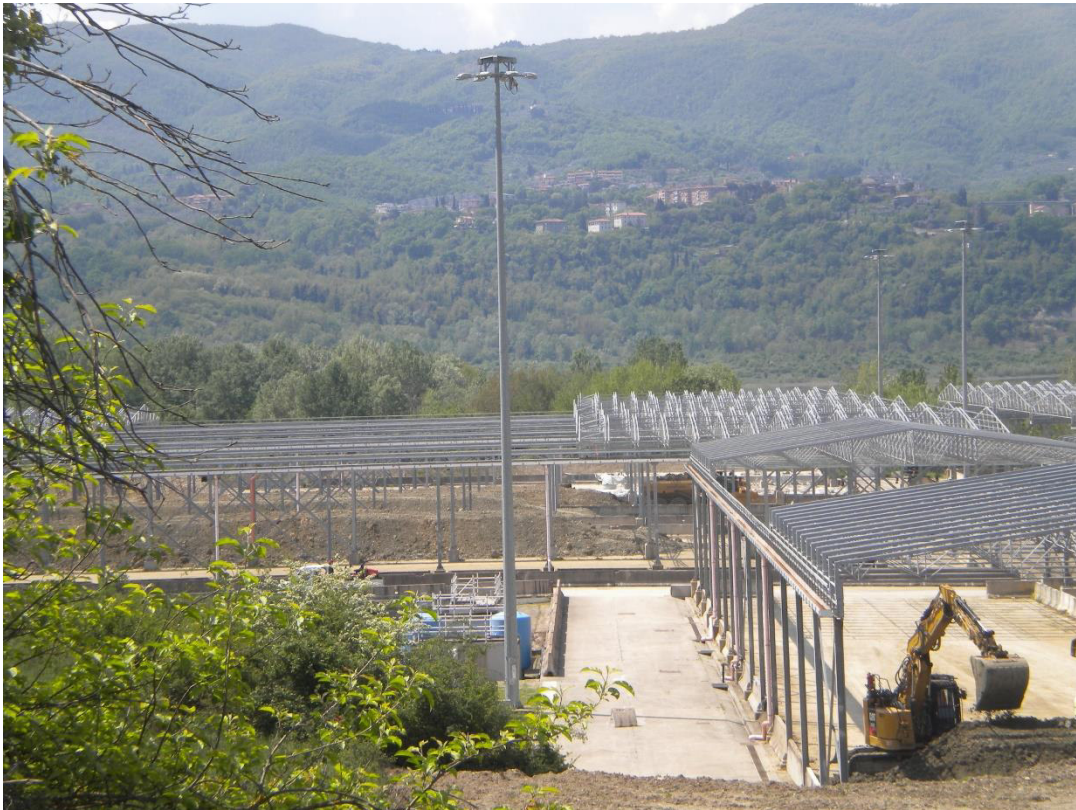
Attività di scavo delle terre dalle piazzole di caratterizzazione
