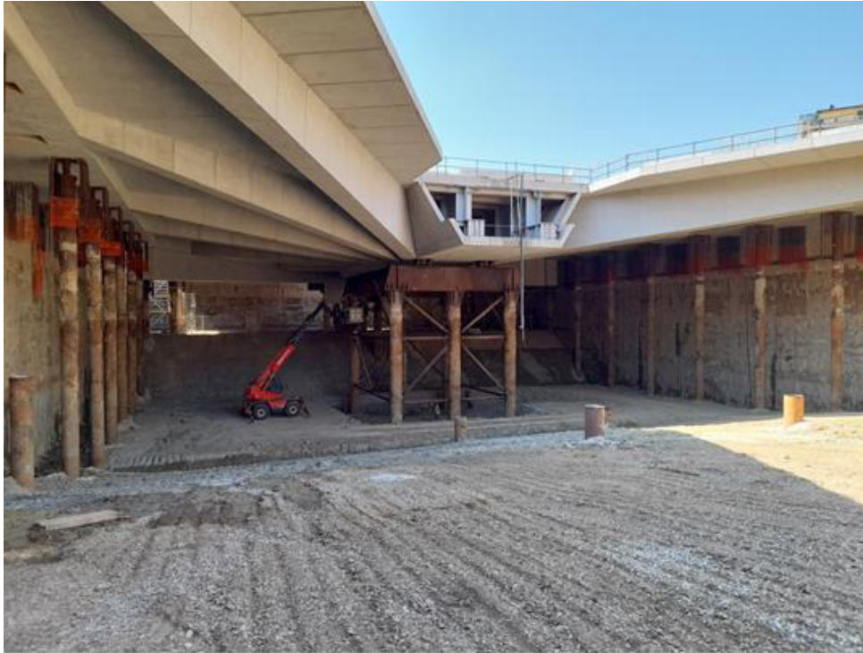
Carpenterie metalliche installate nel castelletto n.33
