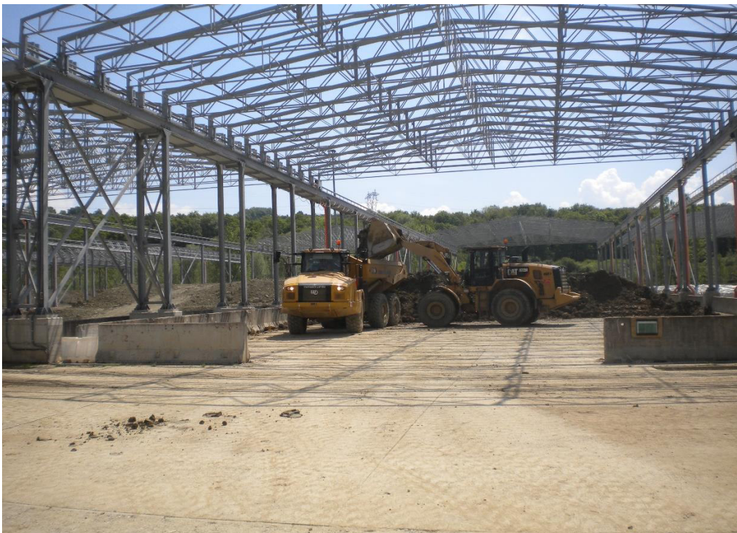
Attività di ricarica delle terre per abbancamento presso la collina schermo
