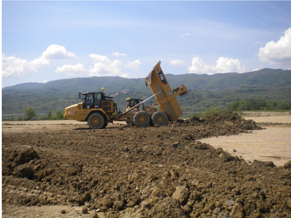
Attività di scarico delle terre presso la collina schermo
