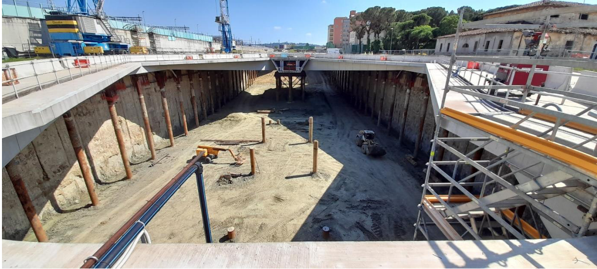
Abbassamento fondo scavo all'interno del camerone della Nuova Stazione AV
