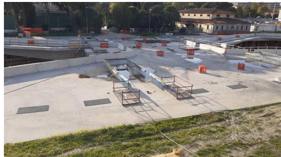
Vista panoramica del solaio a p.c.
