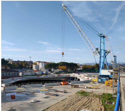
Vista panoramica del solaio a p.c.
