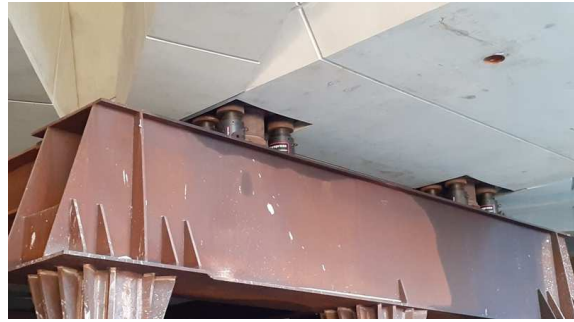
Particolare della struttura provvisoria in acciaio, con vista dei capitelli e martinetti
