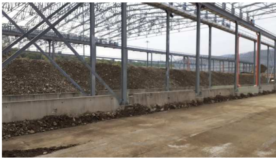
Vista panoramica di una piazzola con terreno in attesa di essere depositato in situ e una attualmente vuota
