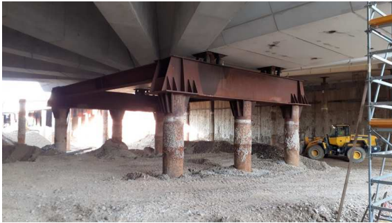
Struttura provvisoria in acciaio
