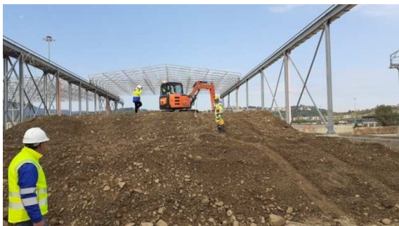
Prelievo di terreno per il campionamento
