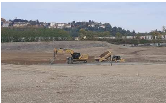
Fase di scarico del terreno nel sito della collina
