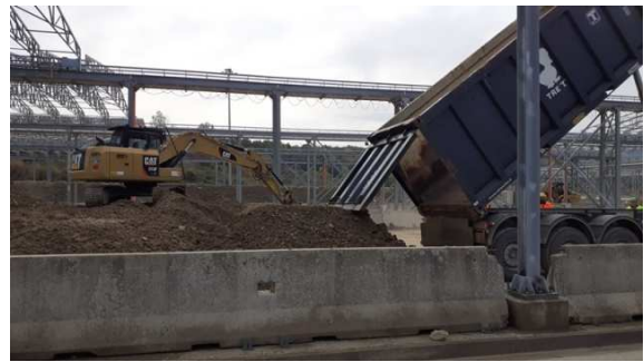
Fase di scarico del terreno in piazzola
