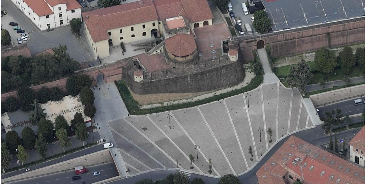
Figura 10-8. Cinta muraria della Fortezza da Basso: Mastio
