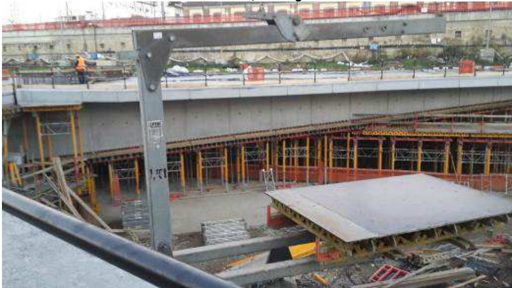
Foto 6 – Scassero Solaio, Ventaglio Asse 25
