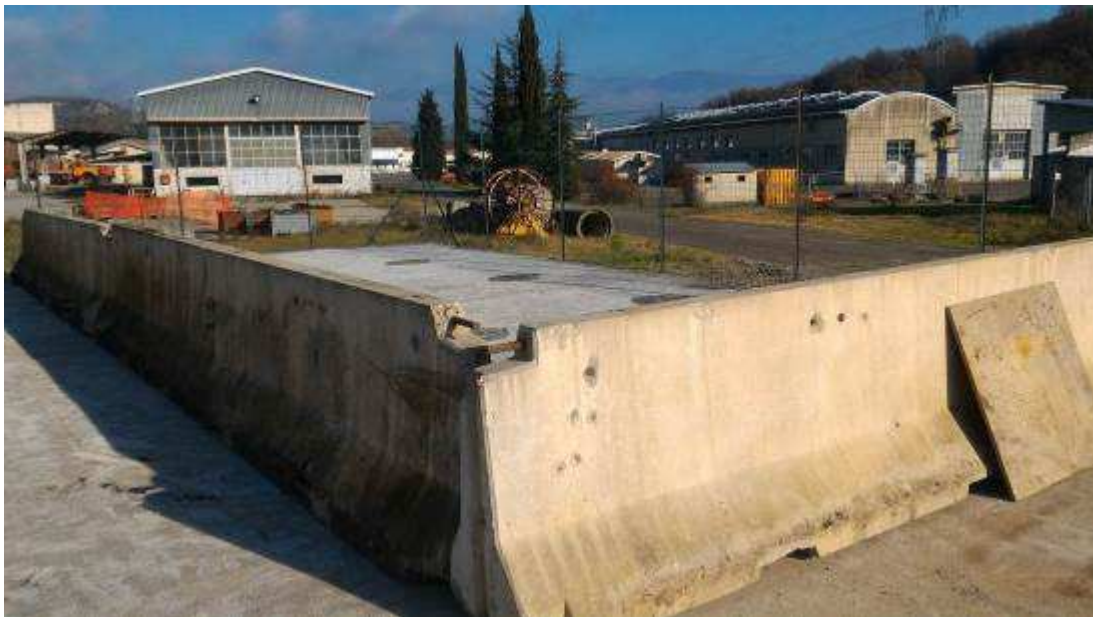
Foto 2 – Vasca di Prima Pioggia – NC177
