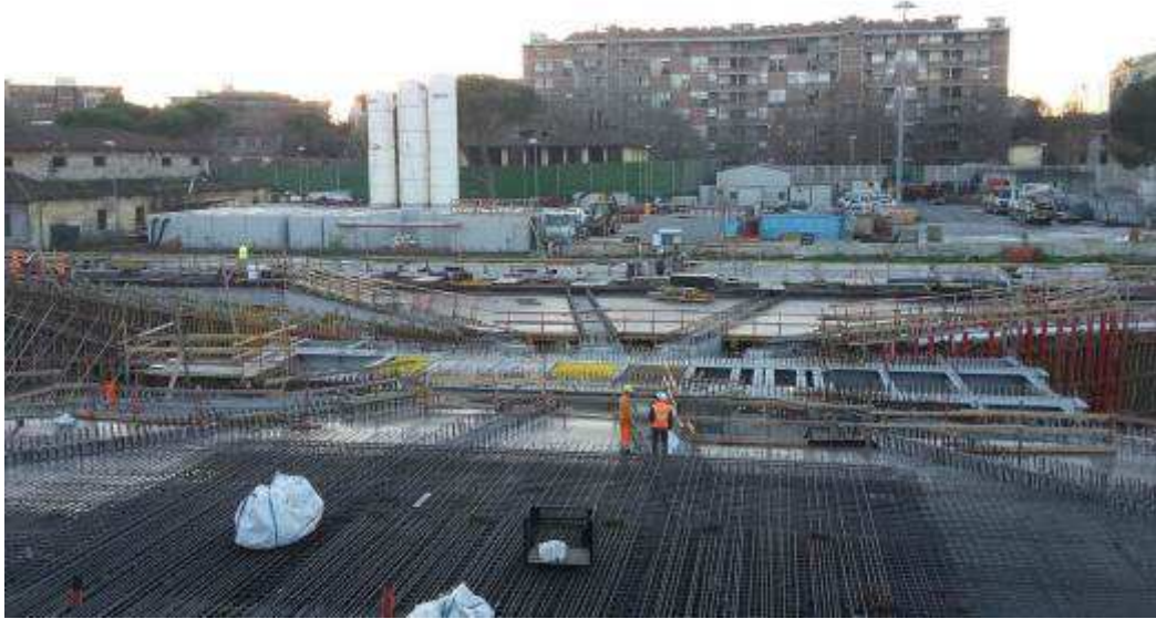
Foto 2 – Montaggio armatura soletta lato Est, Ventaglio Asse 9
