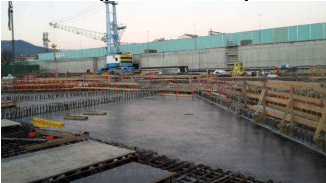
Foto 3 – Banchinaggio soletta lato Ovest, Ventaglio Asse 9
