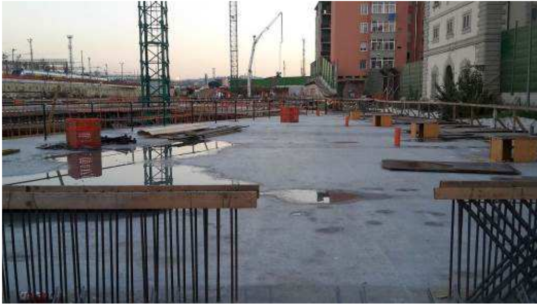
Foto 5 – Getto Soletta Solaio, Ventaglio Asse 17 lato Ovest
