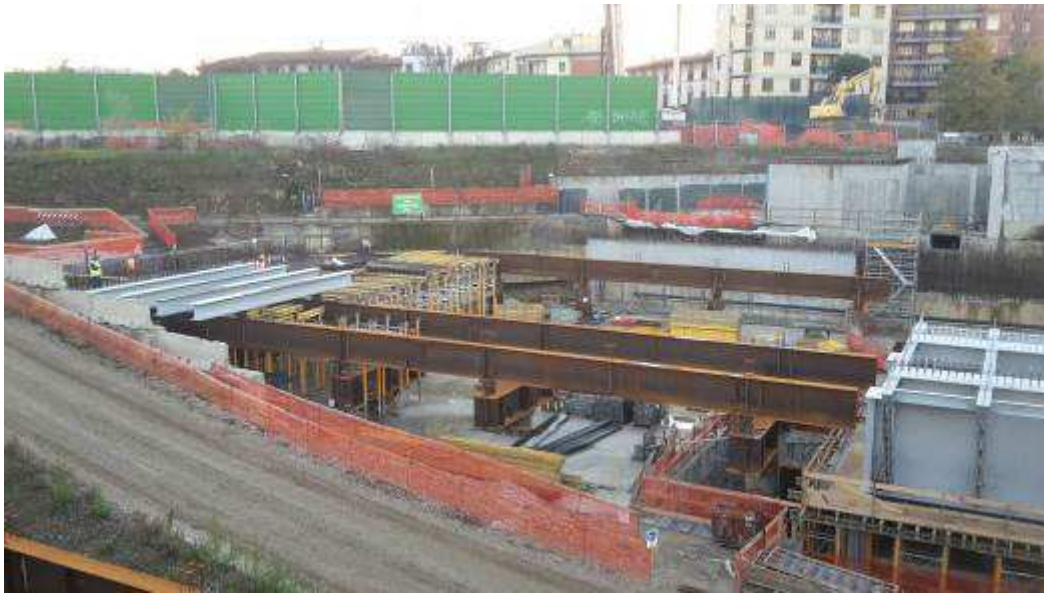
Foto 8 – Banchinaggio Testata Sud - lato Ovest
