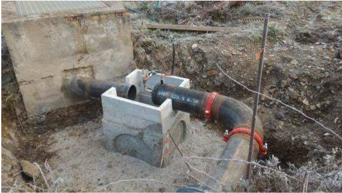
Foto 3 – Posa tubazione di mandata Pozzetto di campionamento
