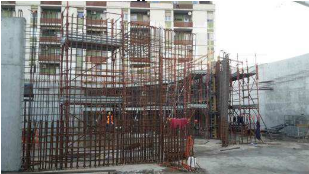
Foto 9 – Montaggio casseri e getto Muro MU10, Rampa Kiss&Ride
