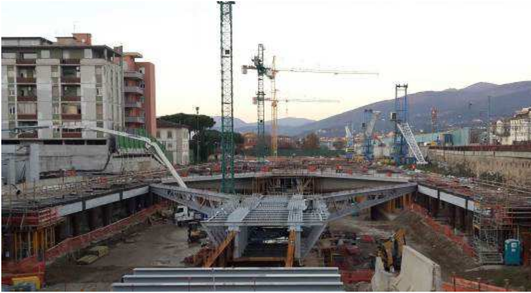
Foto 11 – Panoramica da Sud
