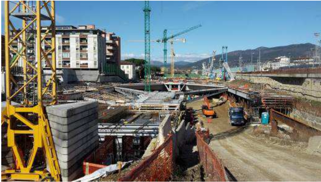
Foto 11 – Panoramica da Sud
