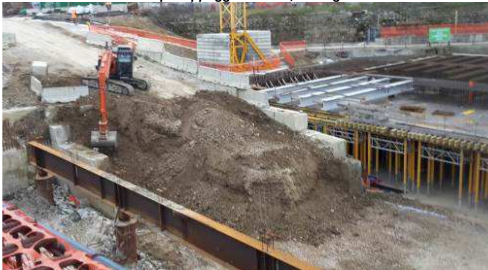
Foto 7 – Rimozione Rampa di accesso camerone, Zona Testata Sud
