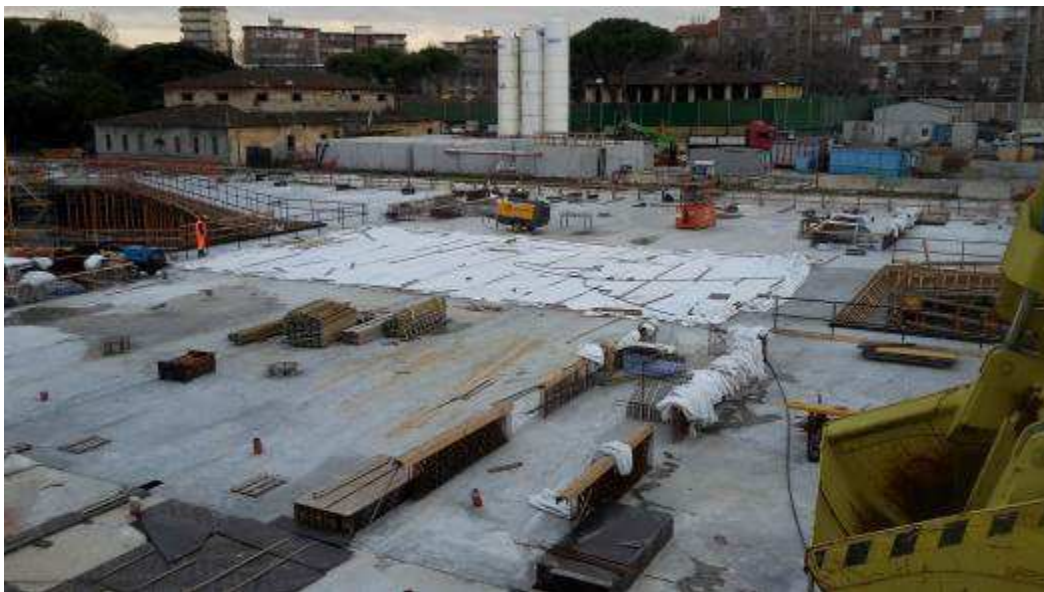
Foto 1 – Completamento getti soletta, Ventaglio Asse 9
