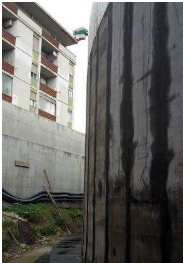
Foto 12 – Impermeabilizzazione Muro MU3-MU4, Rampa Kiss&Ride
