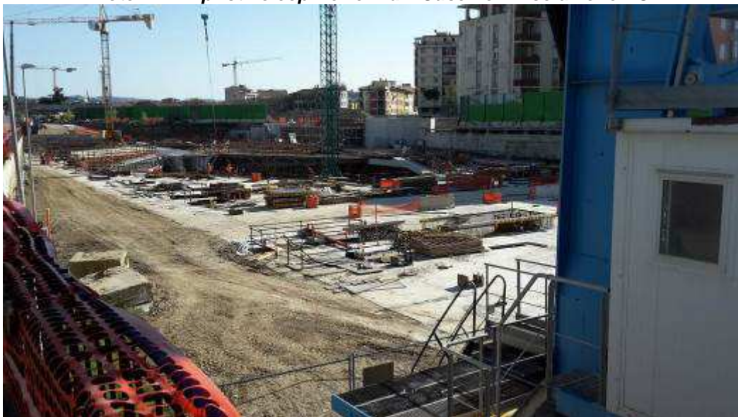
Foto 15 – Rinterro a monte diaframmi camerone lato Est
