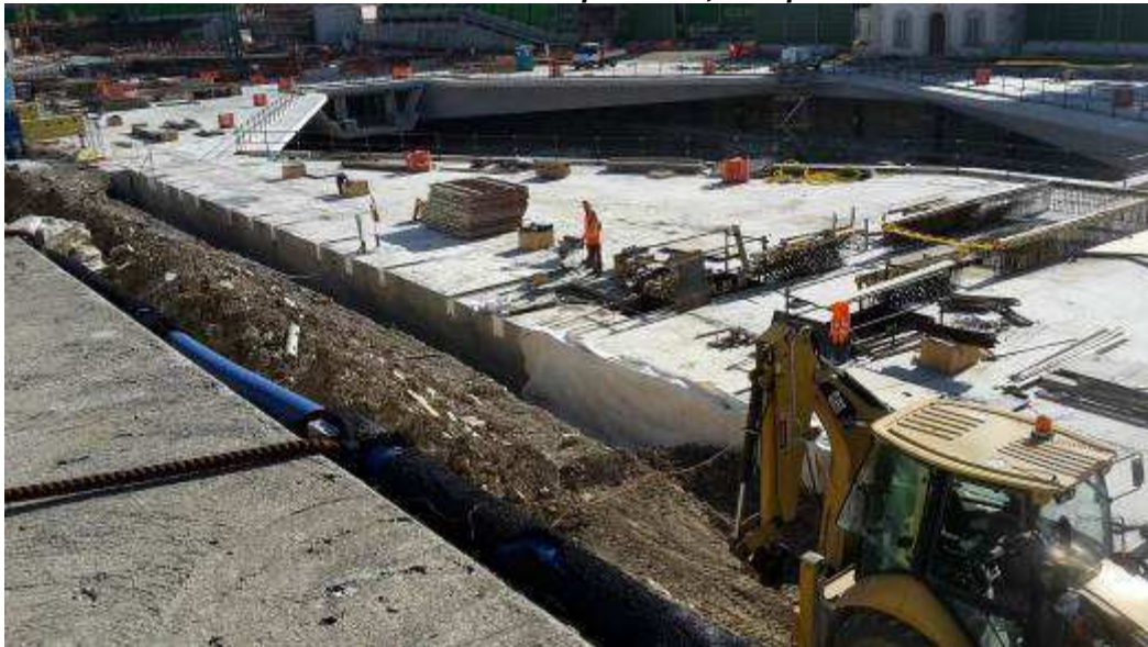
Foto 14 – Ripristino copriferro Travi Cuscino - Risoluzione NC
