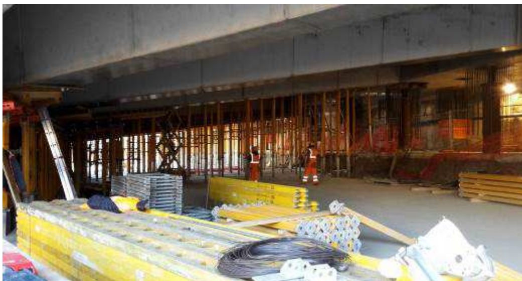
Foto 1 – Rimozione Puntelli e Banchinaggi, Ventaglio Asse 9
