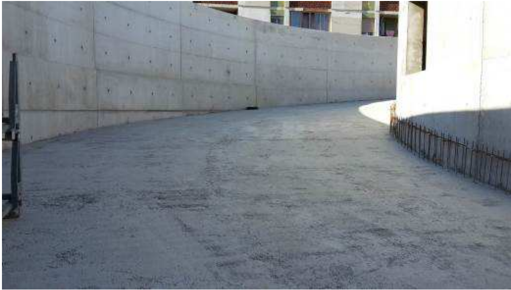
Foto 13 – Getto Soletta Rampa L0204, Rampa Kiss&Ride
