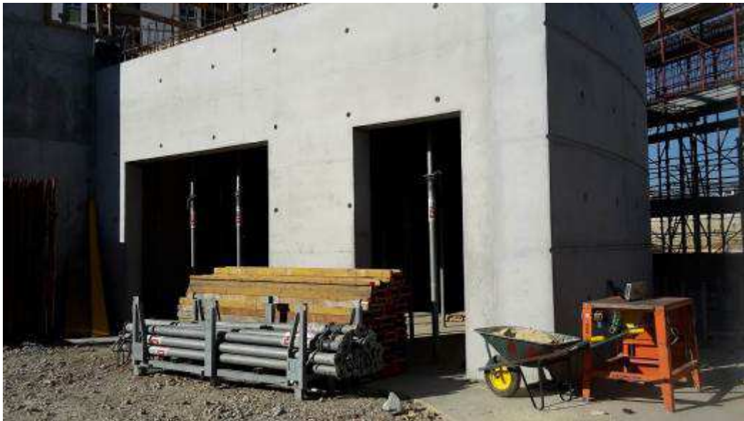
Foto 11 – Scassero Muro MU9, Rampa Kiss&Ride
