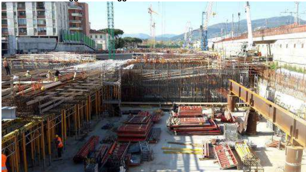
Foto 9 – Montaggio armatura Trave TPT01 Testata Sud - lato Est
