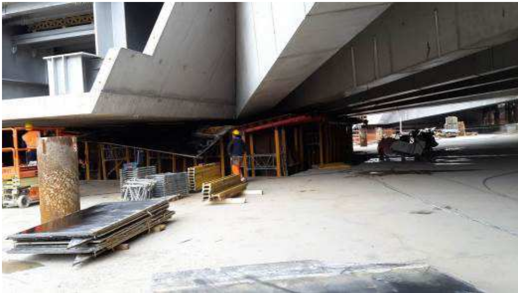
Foto 2 – Rimozione Puntelli e Banchinaggi, Ventaglio Asse 9
