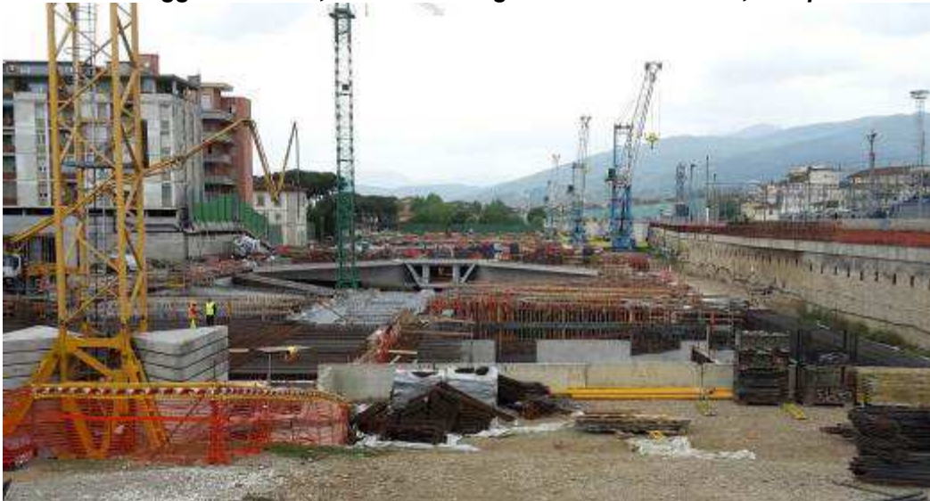
Foto 9 – Panoramica da Sud
