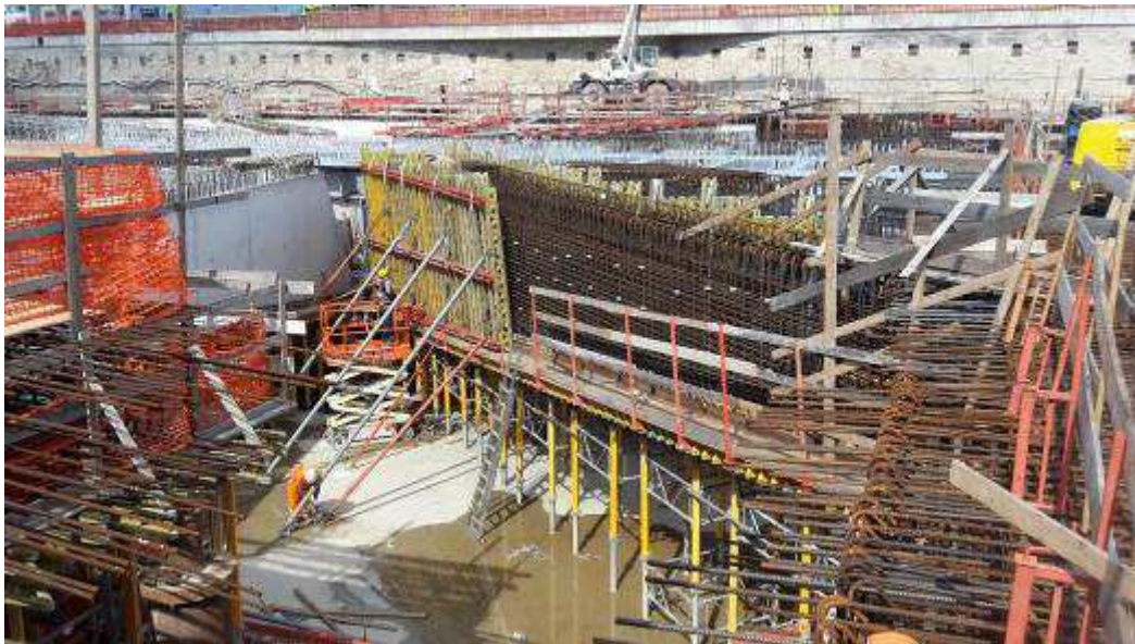
Foto 5 – Casseratura Trave T4 lato Ovest, Ventaglio Asse 33
