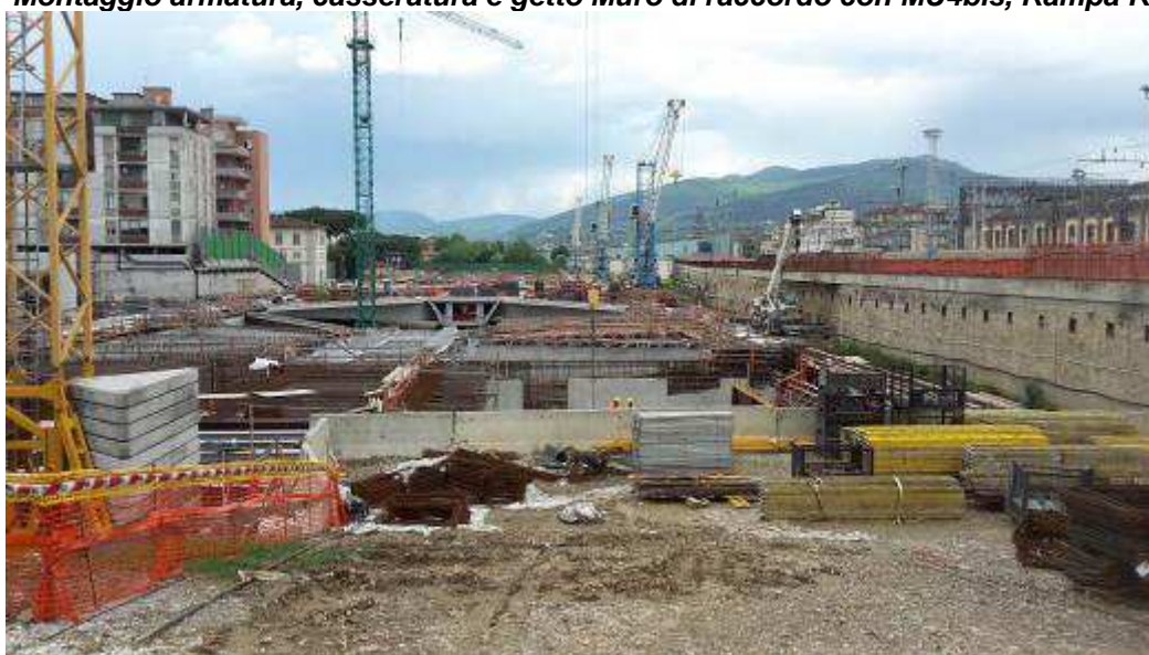
Foto 10 – Panoramica da Sud
