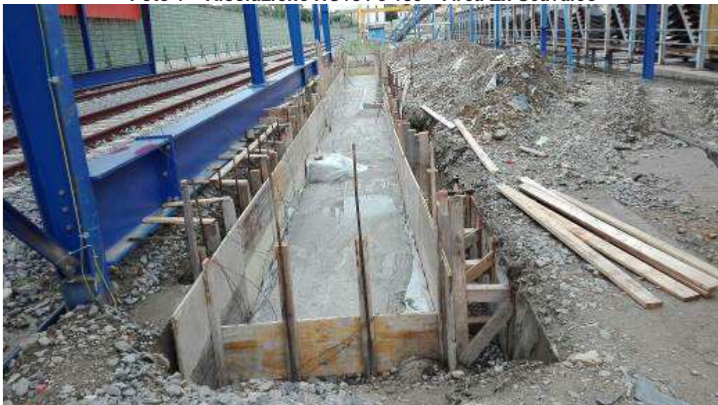
Foto 2 – Getto Fondazione barriere antirumore per schermatura nastro– Area Campo di Marte
