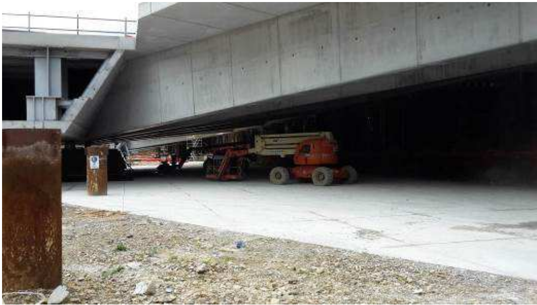
Foto 2 – Rimozione Puntelli e Banchinaggi, Ventaglio Asse 9
