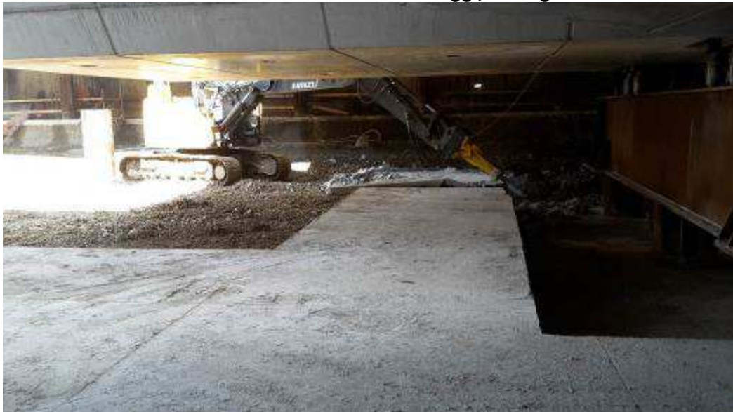
Foto 3 – Demolizione Magronature per appoggio puntelli, Ventaglio Asse 9
