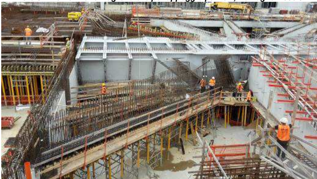
Foto 4 – Banchinaggio e Montaggio Armatura Travi T4 e T5 lato Est, Ventaglio Asse 33
