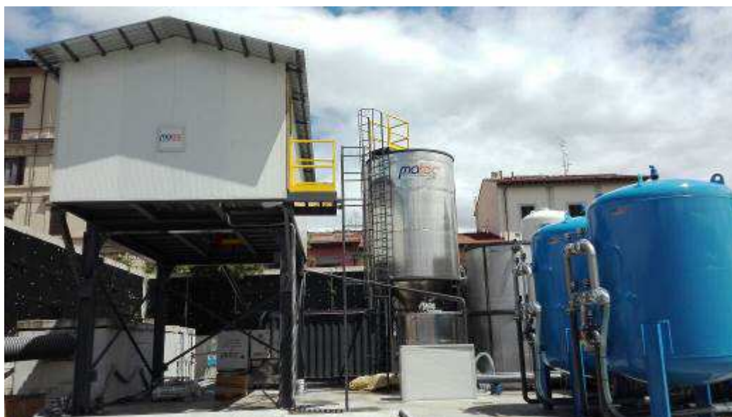
Foto 3 – Montaggio nuovo impianto trattamento acque Campo di Marte
