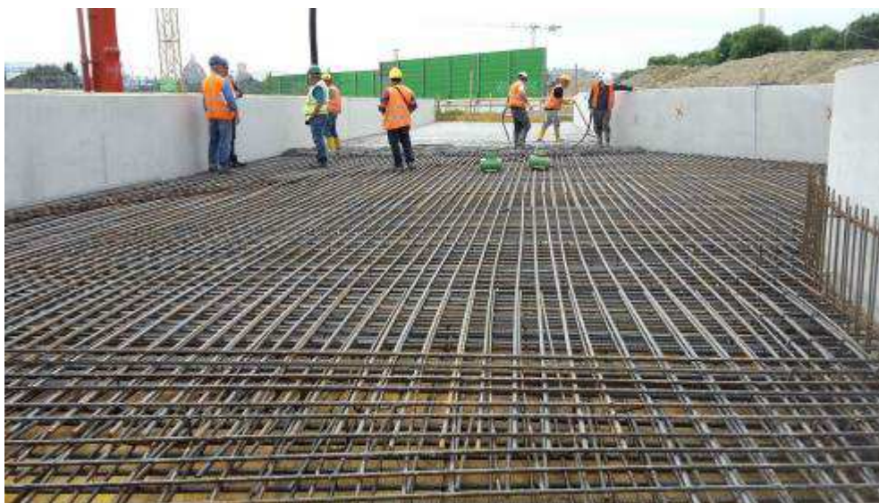
Foto 8 – Montaggio armatura, cassetatura e getto Soletta L0204, Rampa Kiss&Ride
