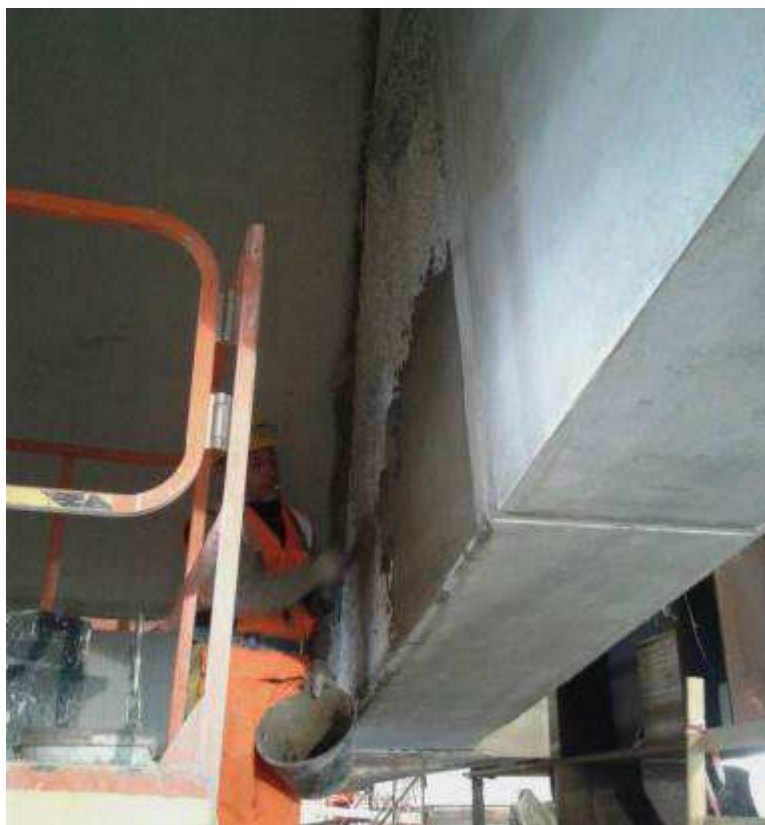
Foto 1 – Ripristini per risoluzione NC, Solaio fili 3-5
