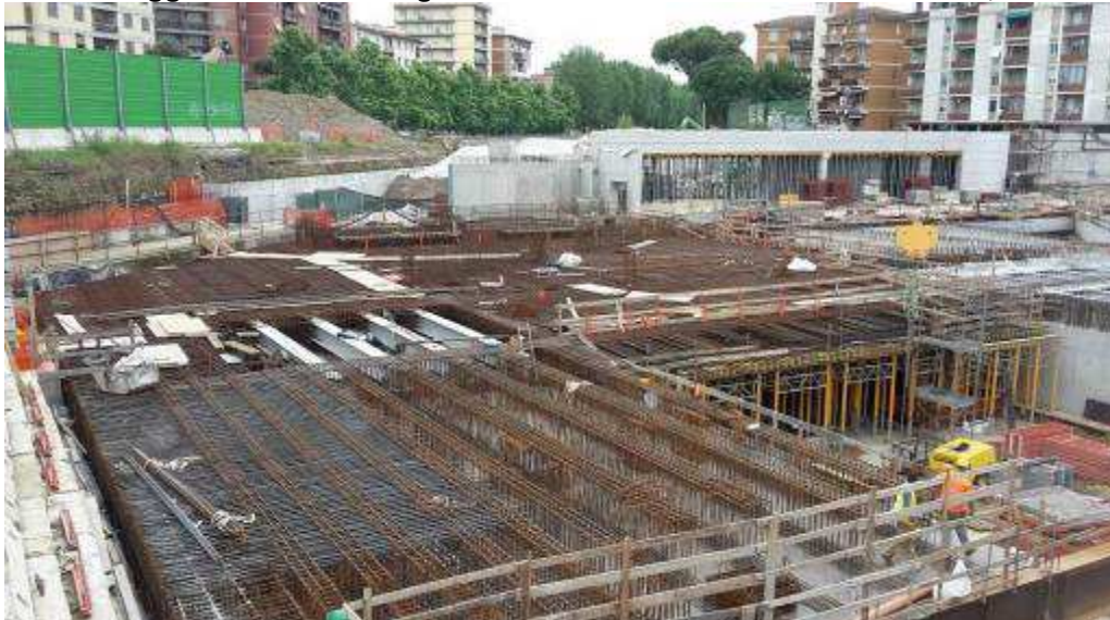
Foto 7 – Banchinaggio e Montaggio armatura Solaio liv. 00 Testata Sud - lato Est
