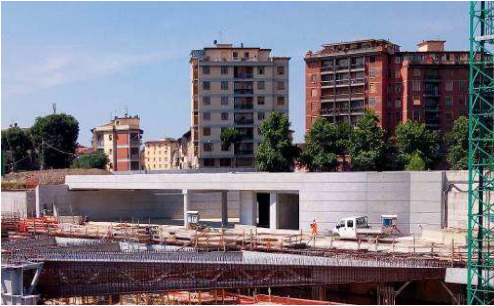
Foto 6 – Completamento opere in c.a., Rampa Kiss&Ride
