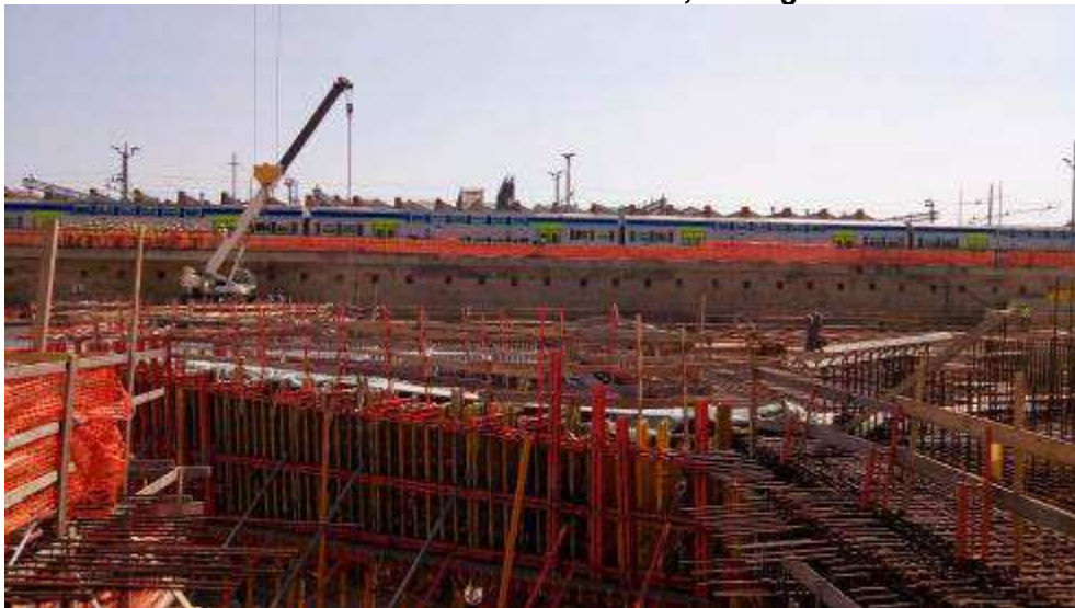
Foto 4 – Casseratura Trave T4 lato Ovest, Ventaglio Asse 33
