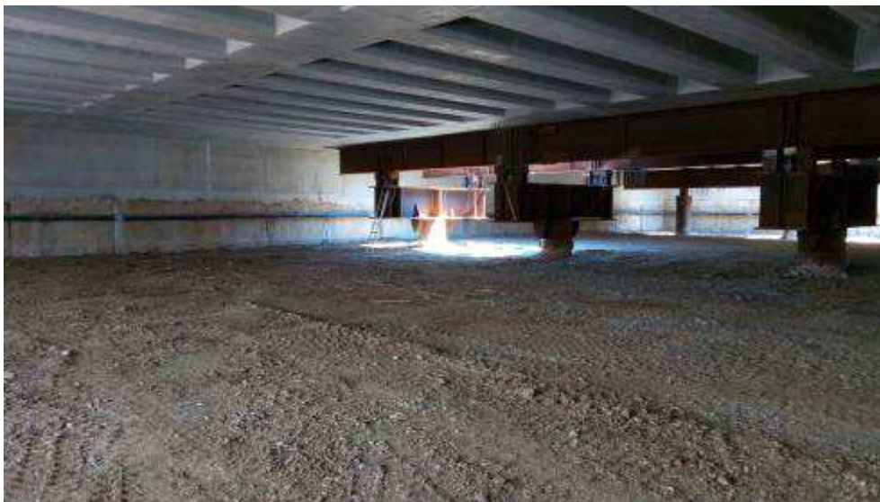
Foto 1 – Demolizione Magronature per appoggio puntelli, Testata Nord
