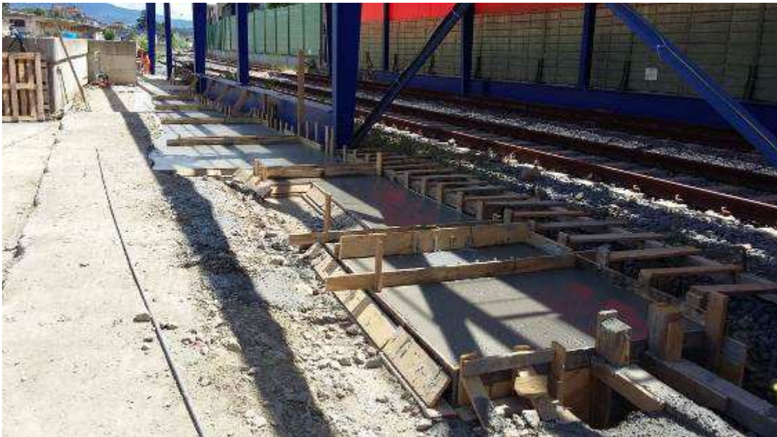
Foto 1 – Getto Fondazione barriere antirumore per schermatura nastro– Area Campo di Marte
