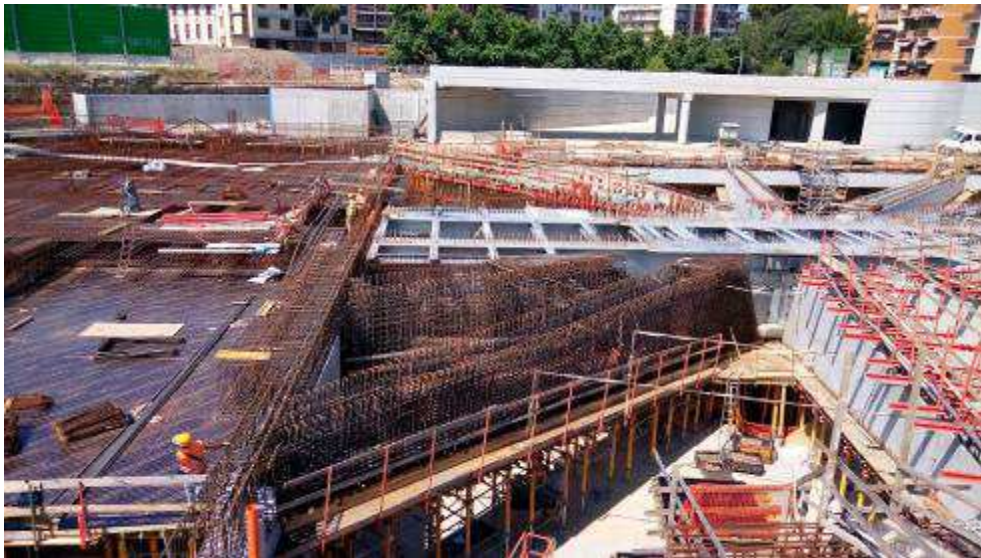
Foto 3 – Armatura Travi T4 e T5 lato Est, Ventaglio Asse 33
