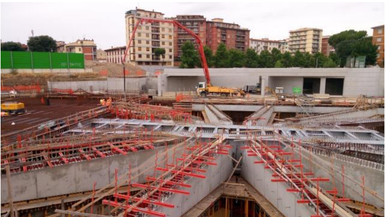
Foto 3 – Getto trave T5 lato Ovest, Ventaglio Asse 33
