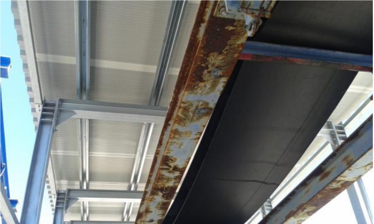
Foto 2 – Montaggio barriere antirumore per schermatura nastro – Area Campo di Marte
