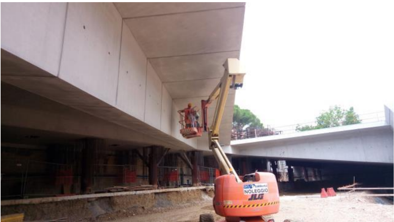
Foto 1 – Ripristino delle travi per la presentazione del faccia vista, ventaglio 9
