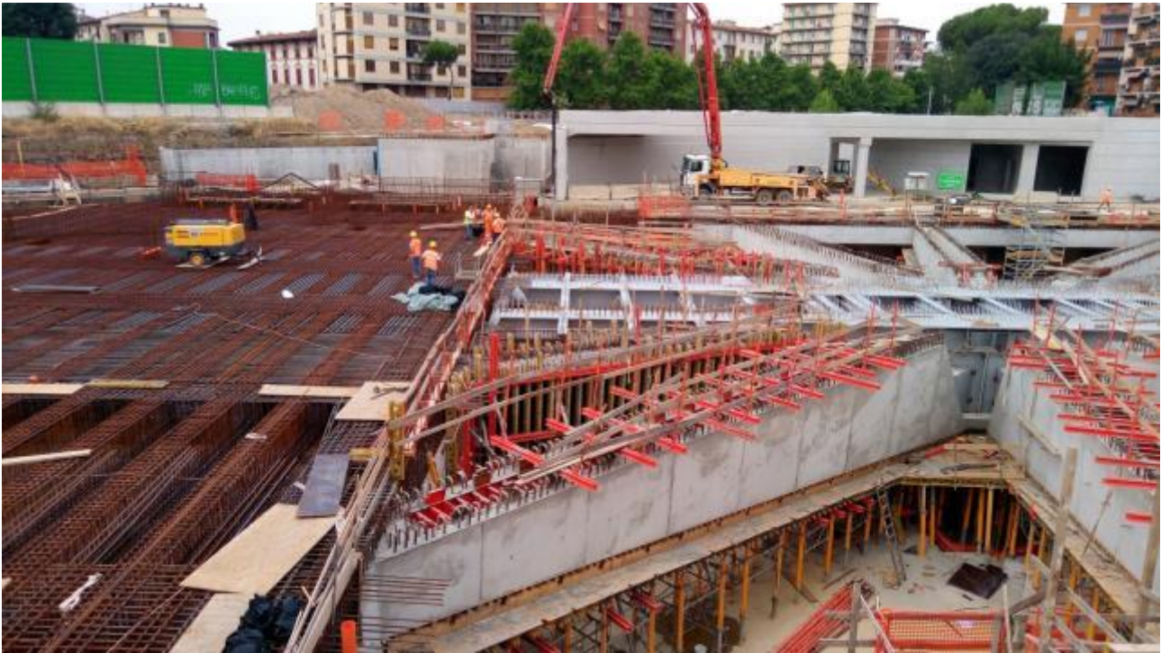
Foto 2 – Trave T5 lato Est gettata , Ventaglio Asse 33
