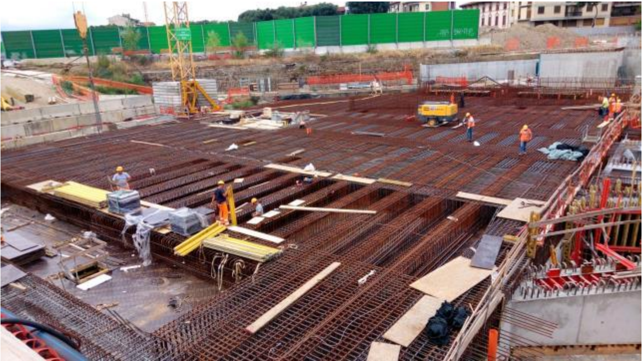
Foto 5 – Realizzazione a cassettoni e montaggio armatura Solaio liv. 00 Testata Sud - lato Est
