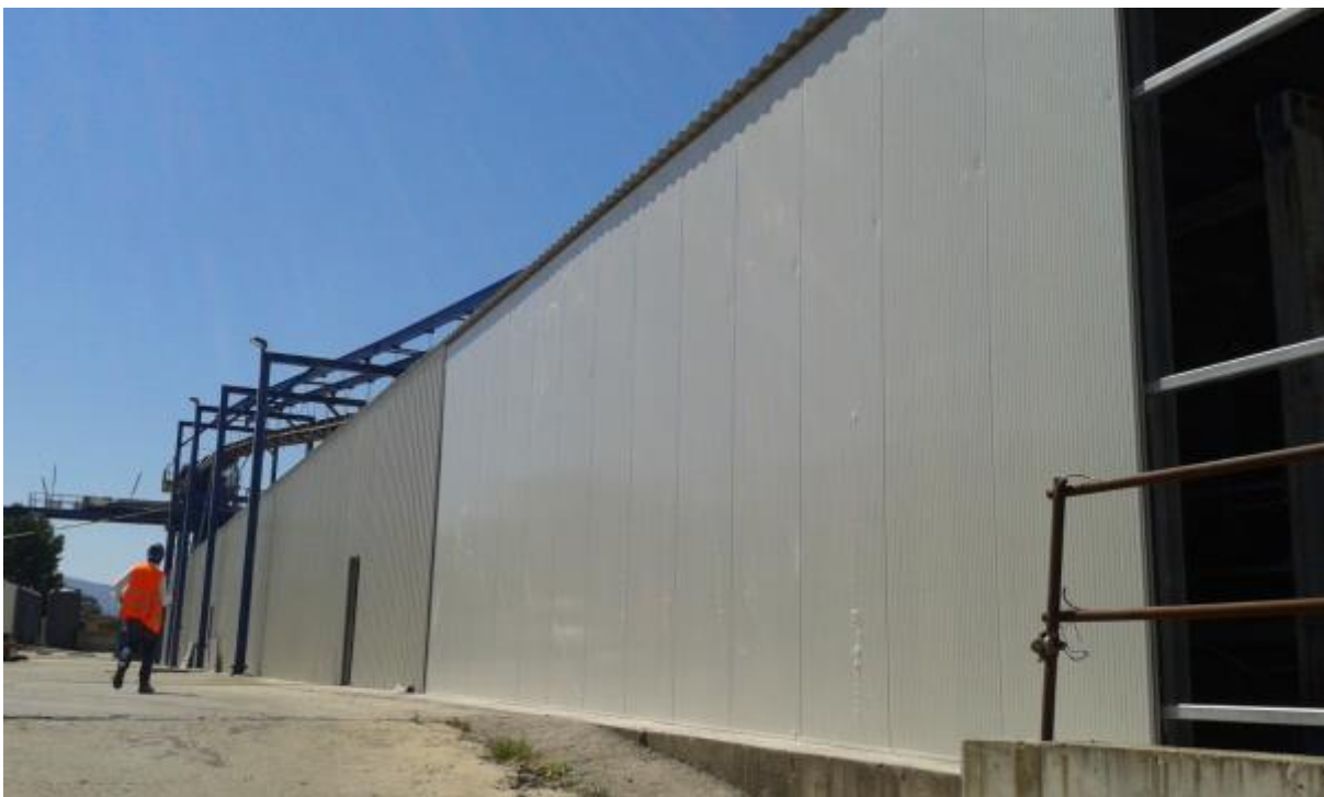
Foto 1 – Montaggio barriere antirumore per schermatura nastro – Area Campo di Marte
