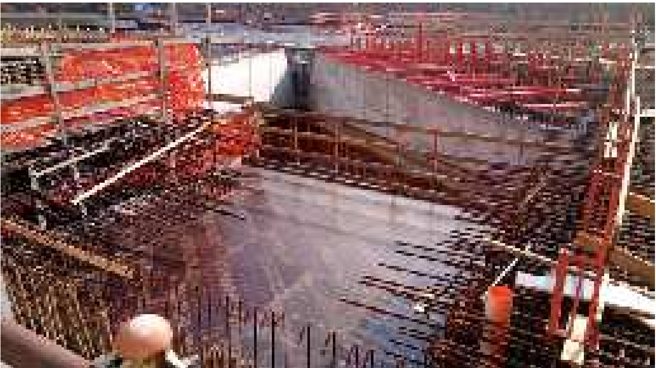
Foto 7 – Banchinaggio trave cuscino filo 34 lato Ovest
