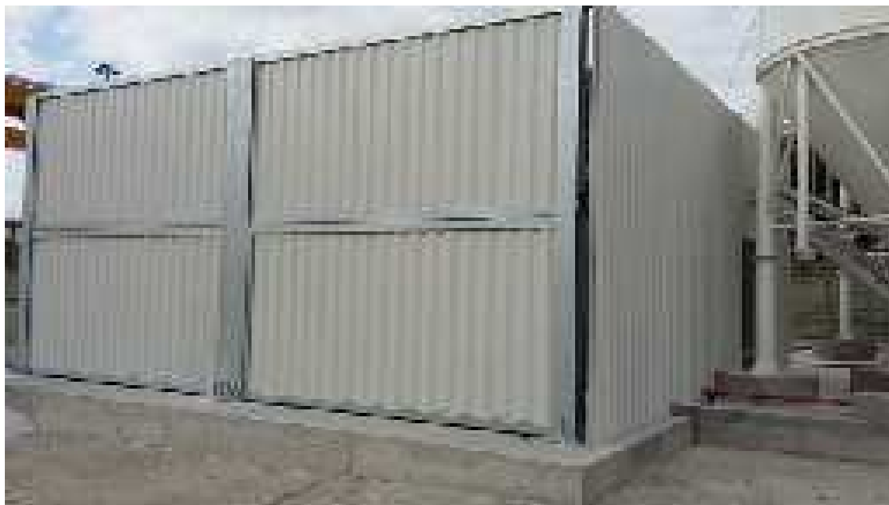
Foto 2 – Montaggio barriere antirumore per schermatura nastro – Area Campo di Marte
