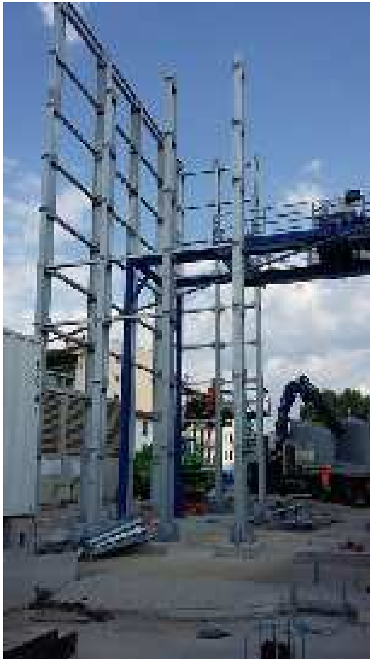
Foto 1 – Montaggio barriere antirumore per schermatura nastro – Area Campo di Marte
