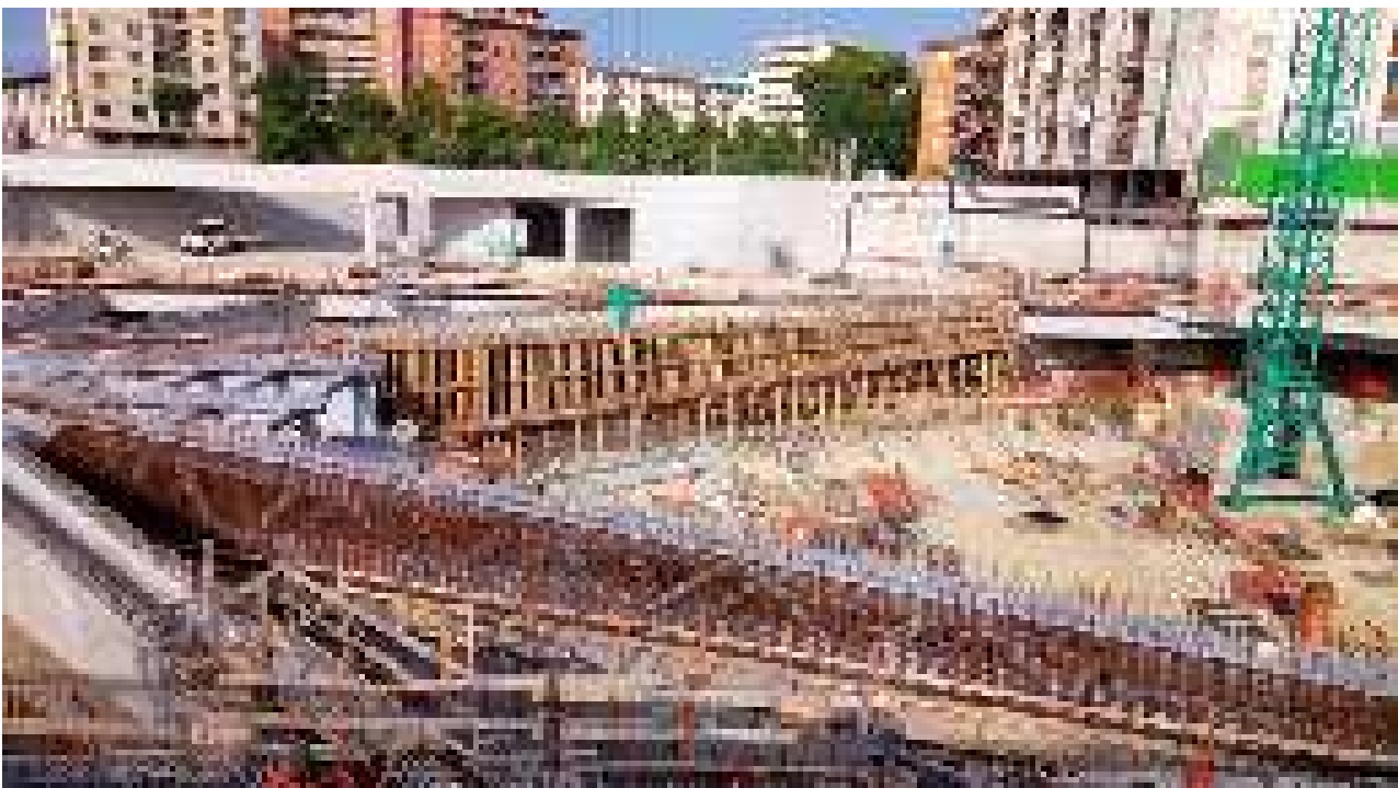
Foto 5 – Banchinaggio trave T1 lato Est, Ventaglio Asse 33
