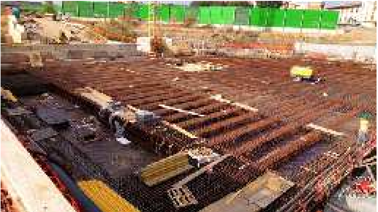
Foto 6 – Ultimata realizzazione cassettoni Solaio liv. 00 Testata Sud
