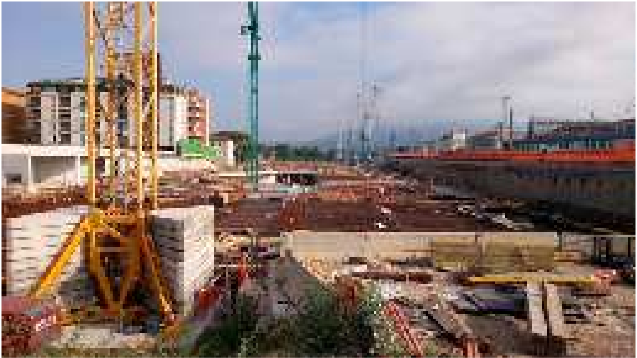
Foto 8 – Panoramica da Sud
