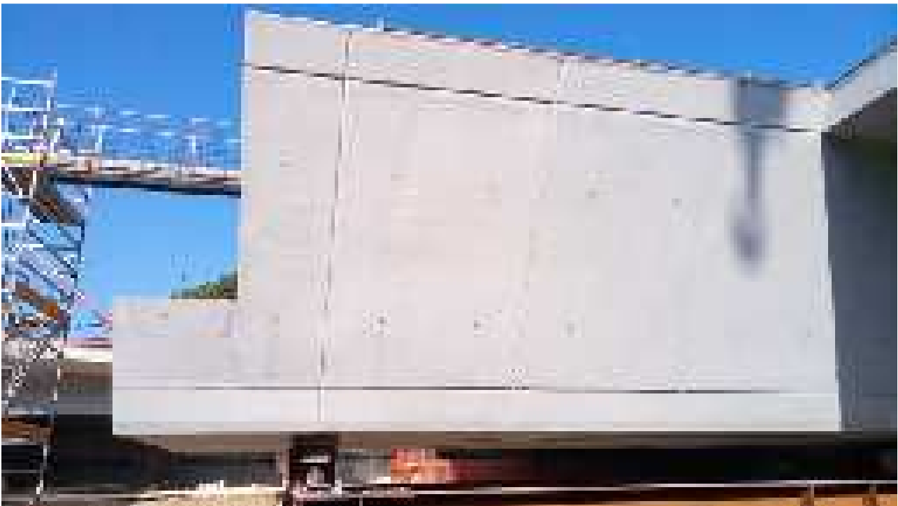
Foto 1 – Cassone con finitura faccia vista, Solaio fili 3-5
