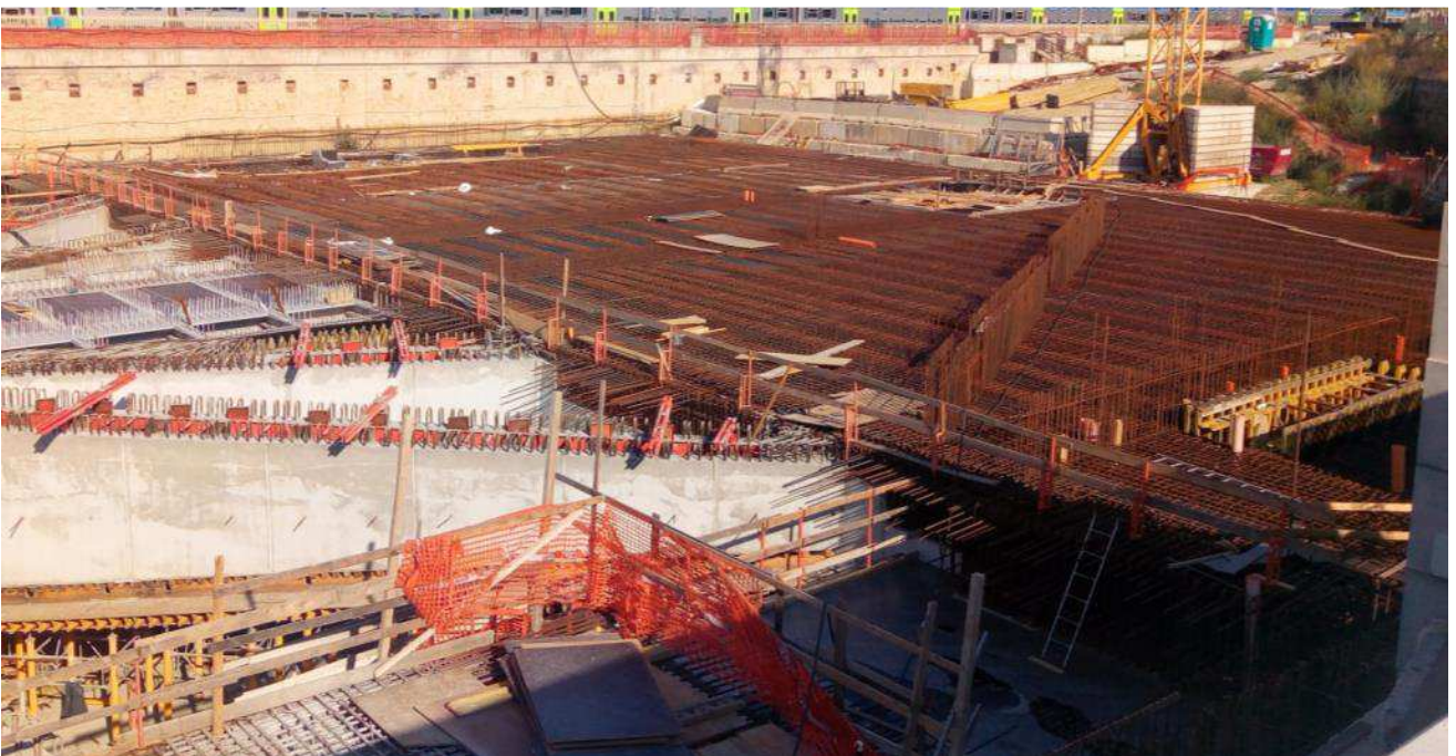
Foto 5 – Posa armatura Solaio liv. 00 Testata Sud
