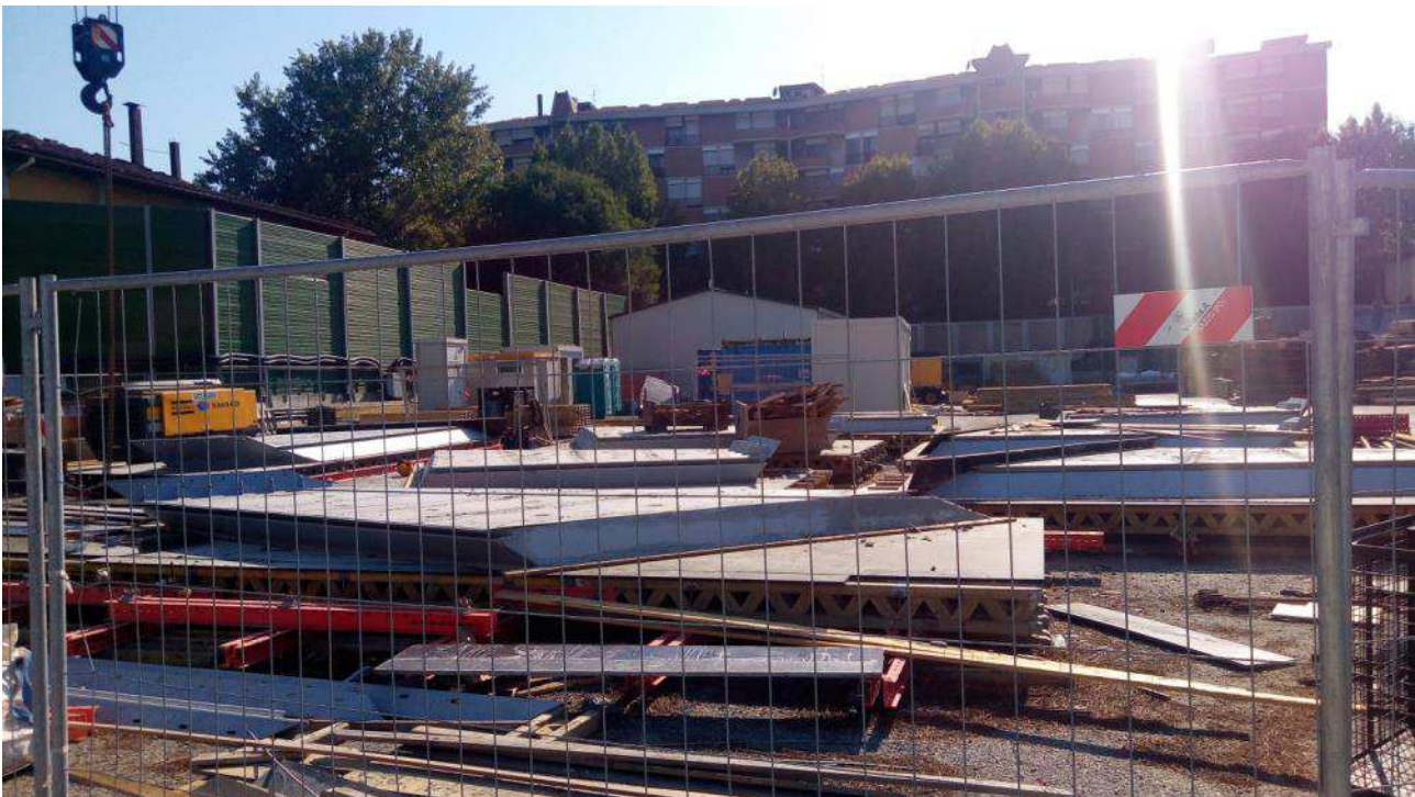
Foto 1 – Predalles prefabbricate con finitura faccia vista, Ventaglio Asse 33
