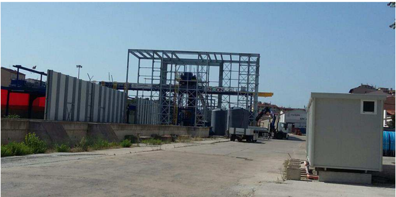
Foto 1 – Montaggio barriere antirumore per schermatura nastro – Area Campo di Marte
