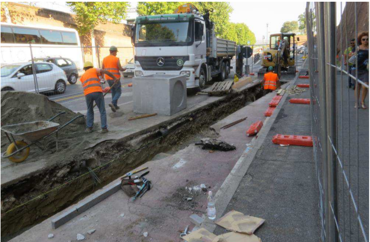
Foto 2– Scavo per posa canaletta tra Trincea 3 e Trincea 4 – Fortezza da Basso
