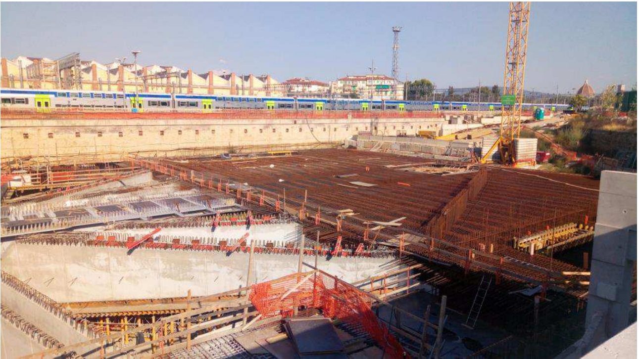
Foto 2 – Travi T5 con finitura faccia vista, ventaglio 33
