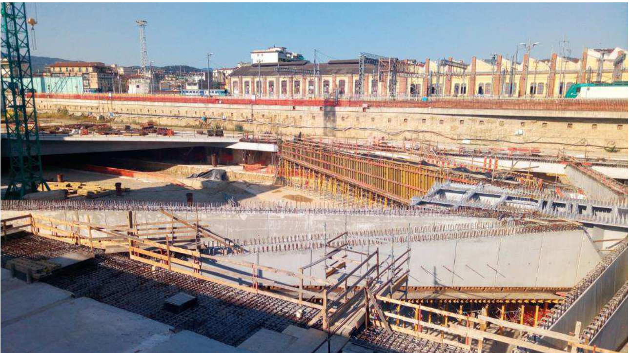
Foto 3 – Trave T1 lato Est scasserata e trave T1 lato Ovest gettata , Ventaglio Asse 33
