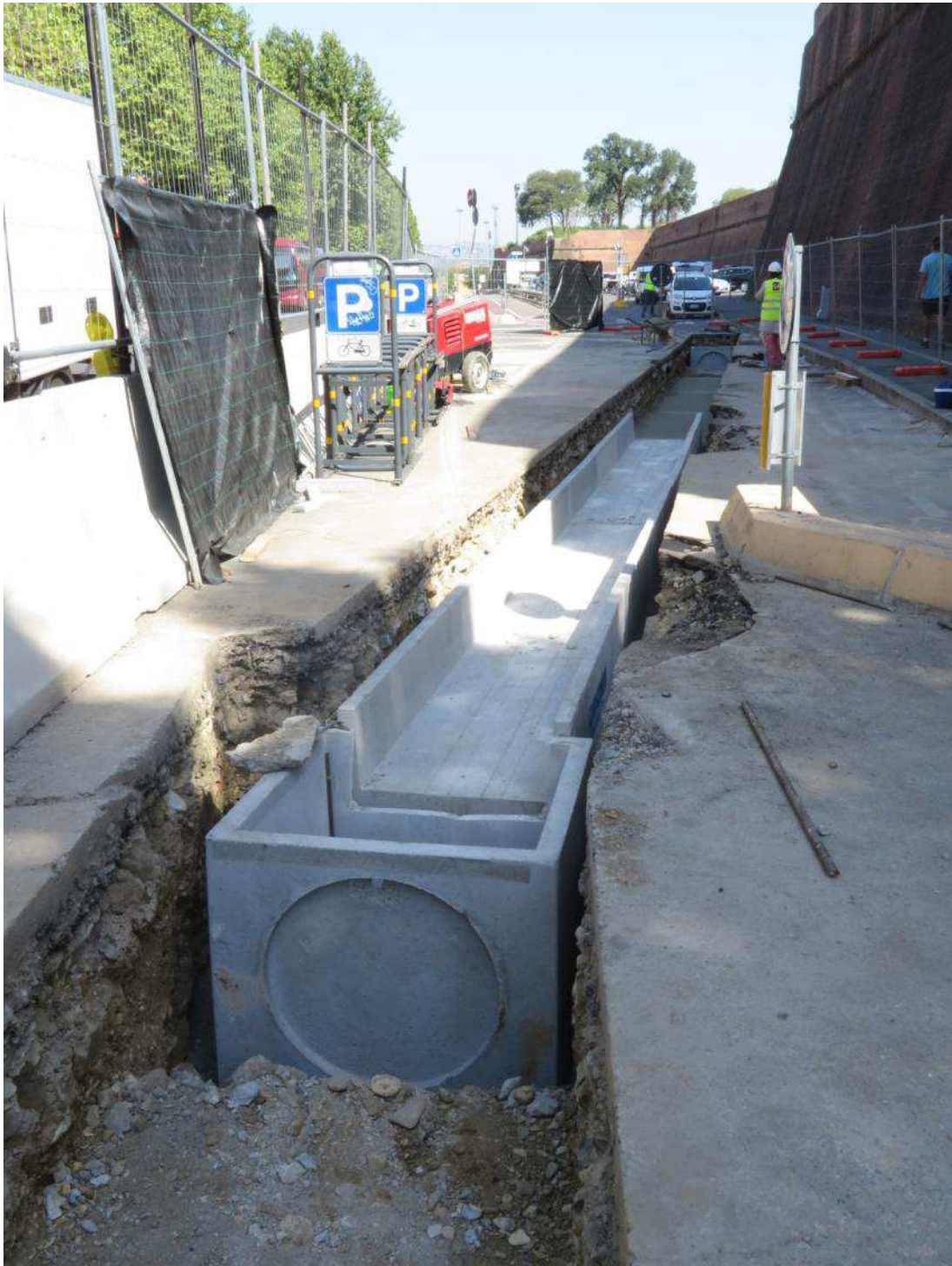
Foto 3– Posa canaletta tra Trincea 3 e Trincea 4 – Fortezza da Basso
