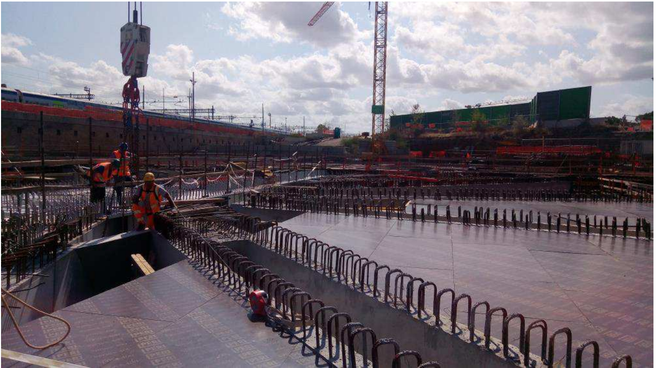
Foto 2 – Varo predalles tipo A lato ovest, Ventaglio Asse 33
