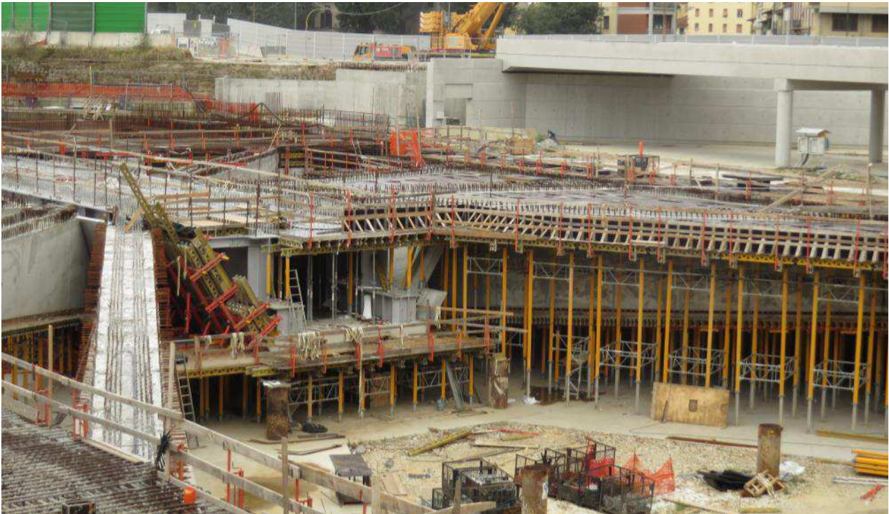
Foto 4 – Banchinaggio solaio, ventaglio 33
