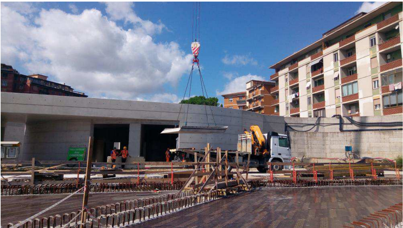
Foto 1 – Varo predalles prefabbricate, Ventaglio Asse 33
