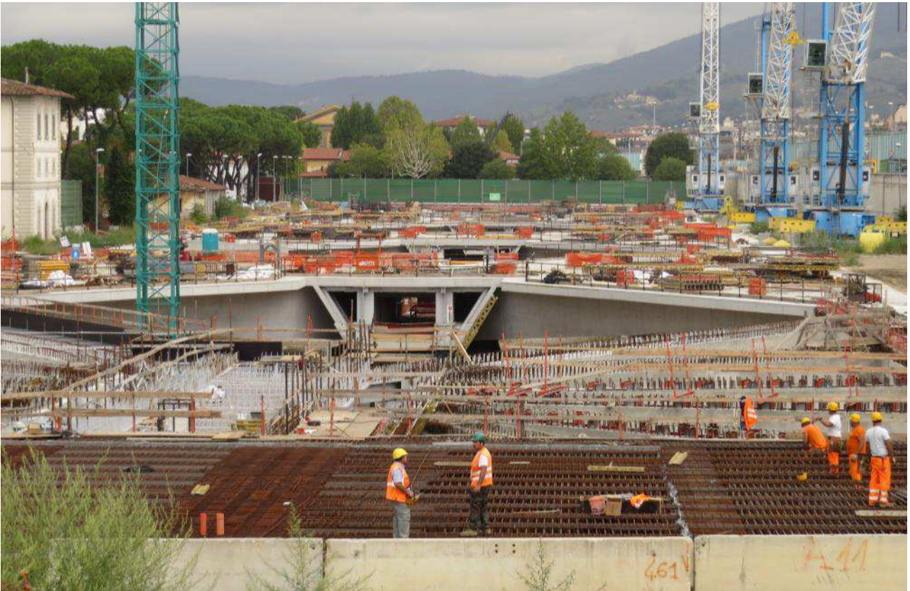
Foto 6– Panoramica da Sud
