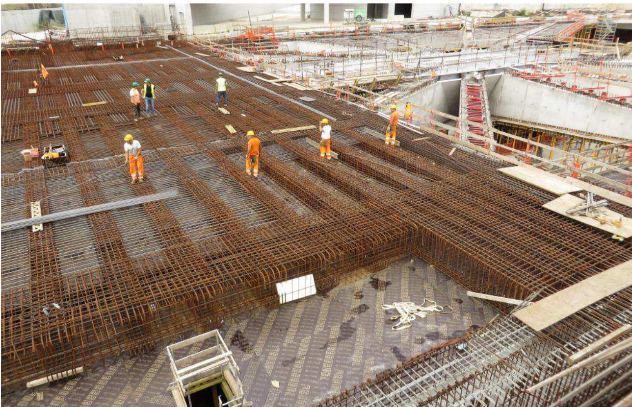
Foto 5 – Completamento armatura Solaio liv. 00 Testata Sud
