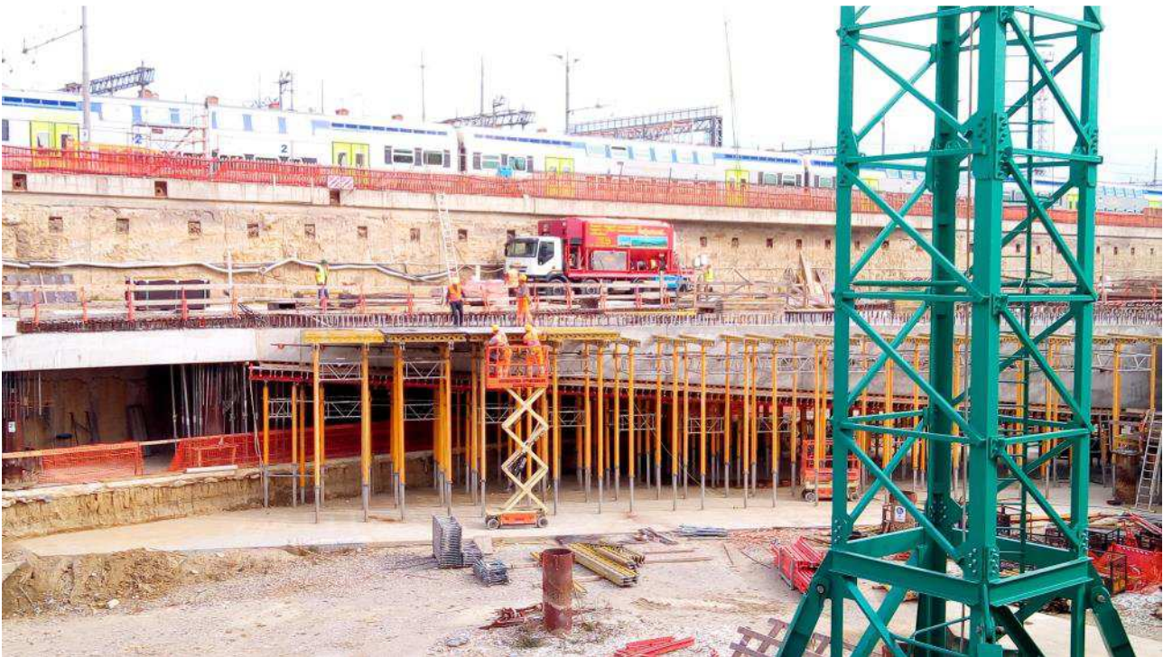
Foto 1 – Banchinaggio solaio liv. 00, Ventaglio Asse 33
