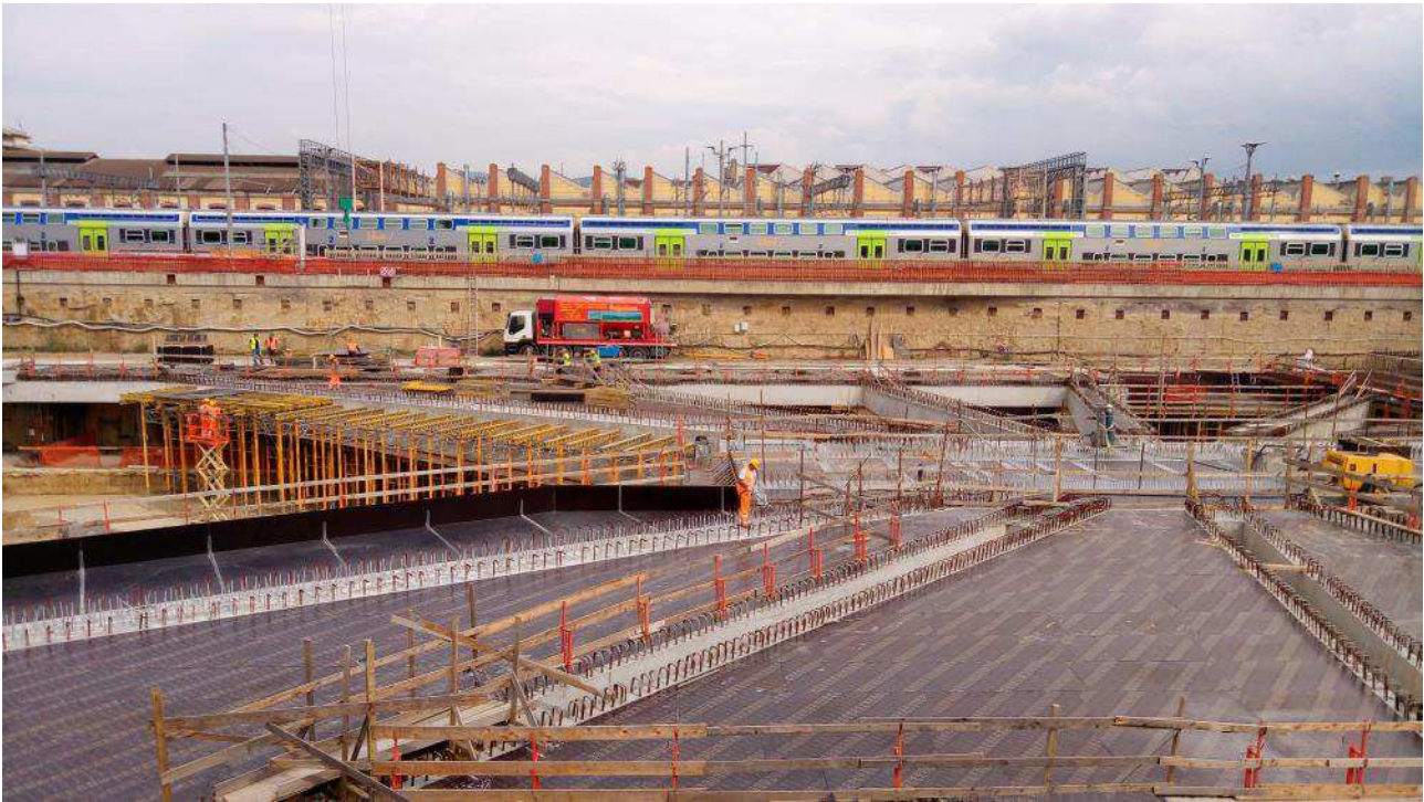
Foto 2 – Banchinaggio solaio liv. 00, Ventaglio Asse 33
