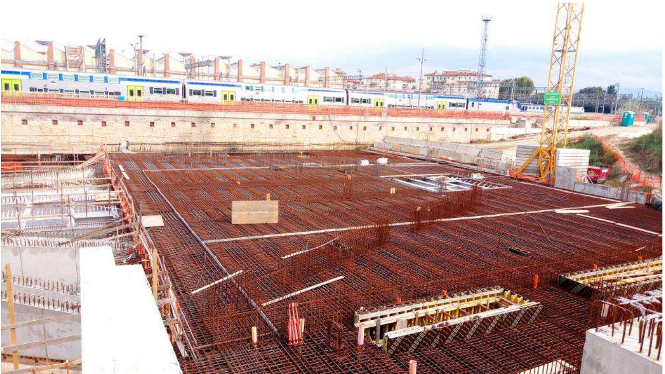
Foto 4 – Armatura solaio Testata Sud
