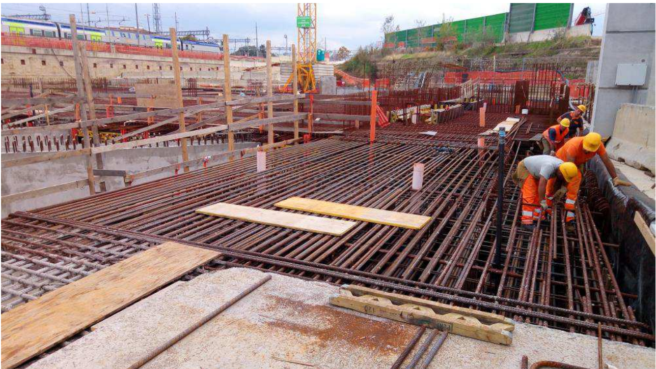
Foto 3 – Posa armatura trave cuscino ovest allineamento 34
