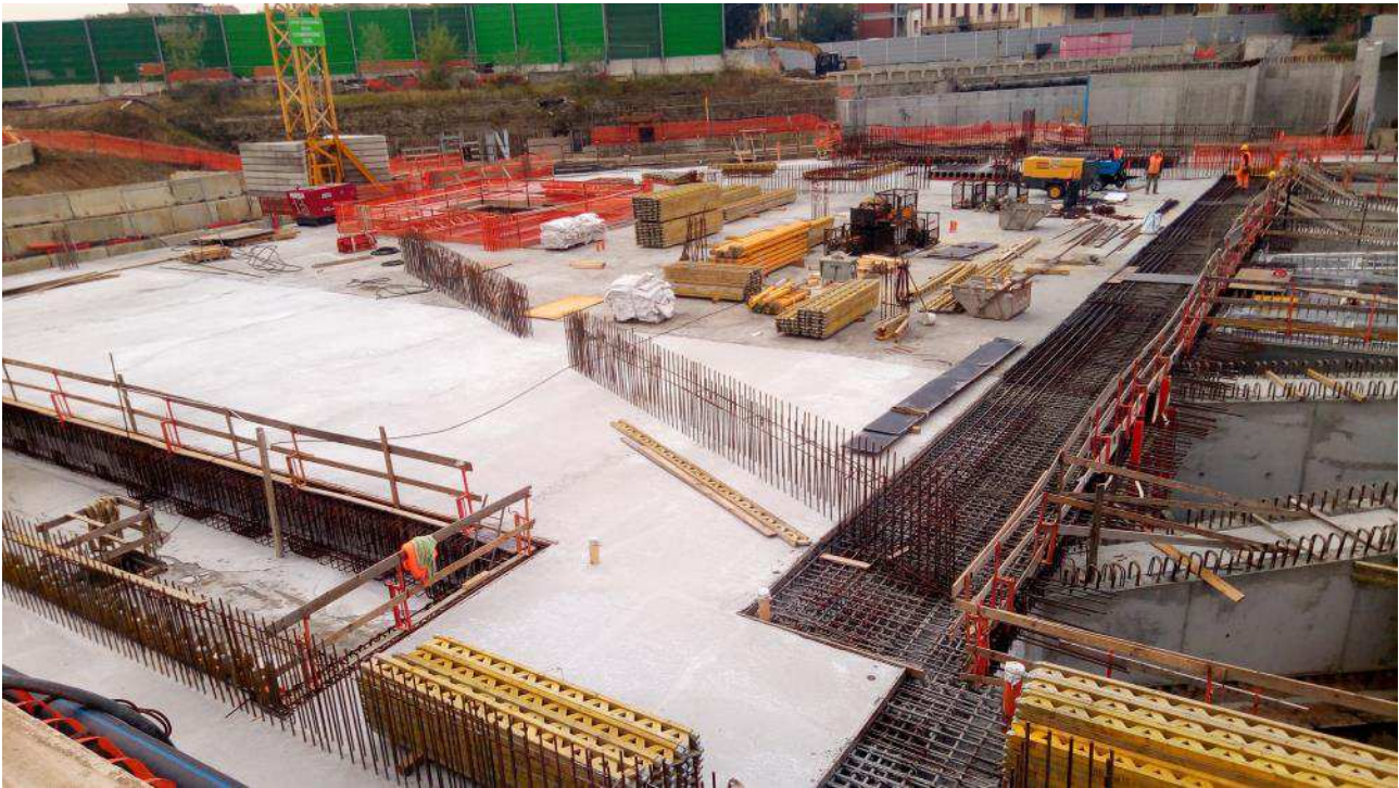
Foto 4 – Solaio Testata Sud ultimato
