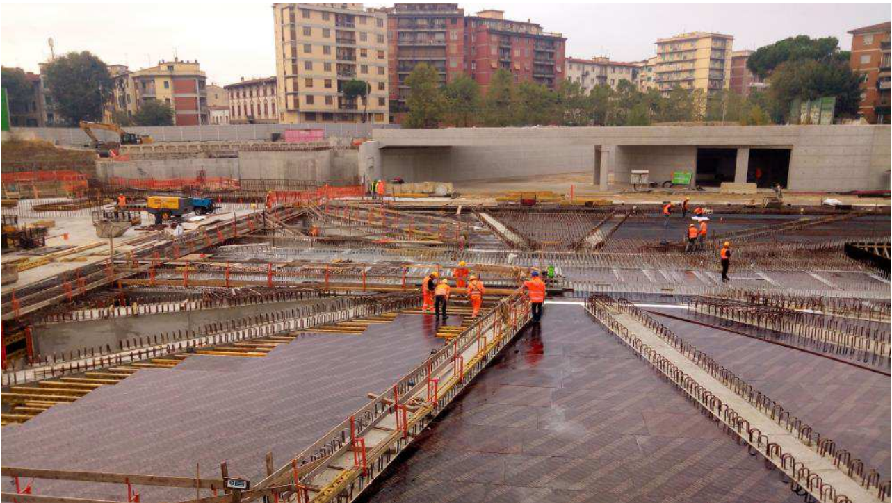
Foto 2 – Posa armatura solaio ventaglio 33
