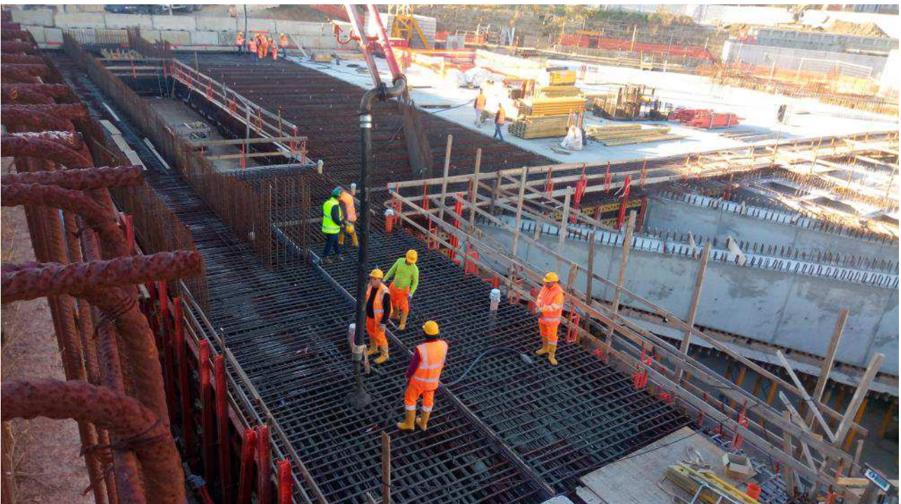
Foto 3 – Getto solaio Testata Sud e trave cuscino lato est filo 34
