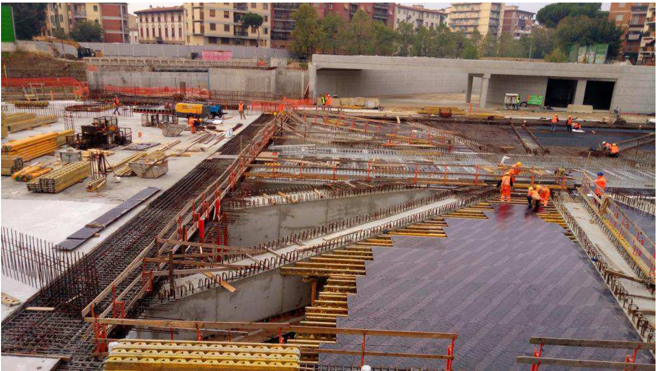
Foto 1 – Banchinaggio solaio liv. 00, Ventaglio Asse 33
