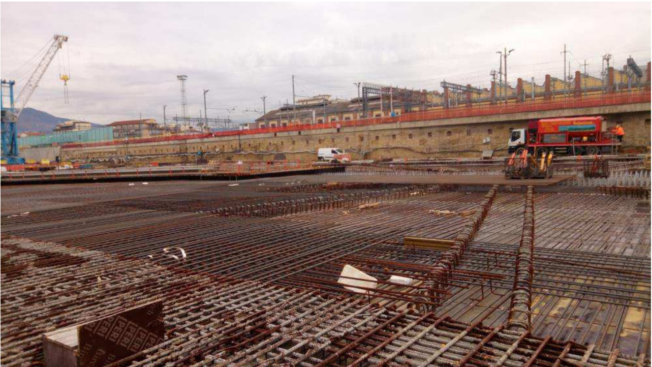
Foto 2 – Armatura solaio ventaglio 33
