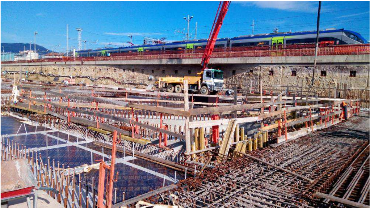
Foto 4 – Getto trave a T lato est – Testata Sud
