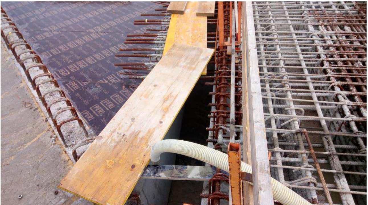
Foto 5 – Riempimento travi a T con calcestruzzo alleggerito – Testata Sud
