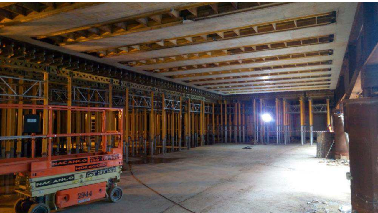
Foto 3 – Scassero solaio Testata Sud
