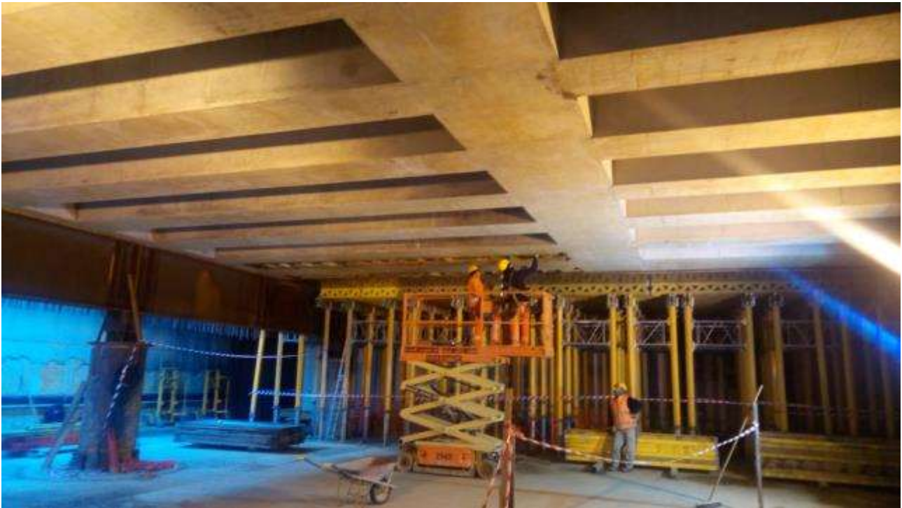
Foto 2 – Scassero solaio Testata Sud
