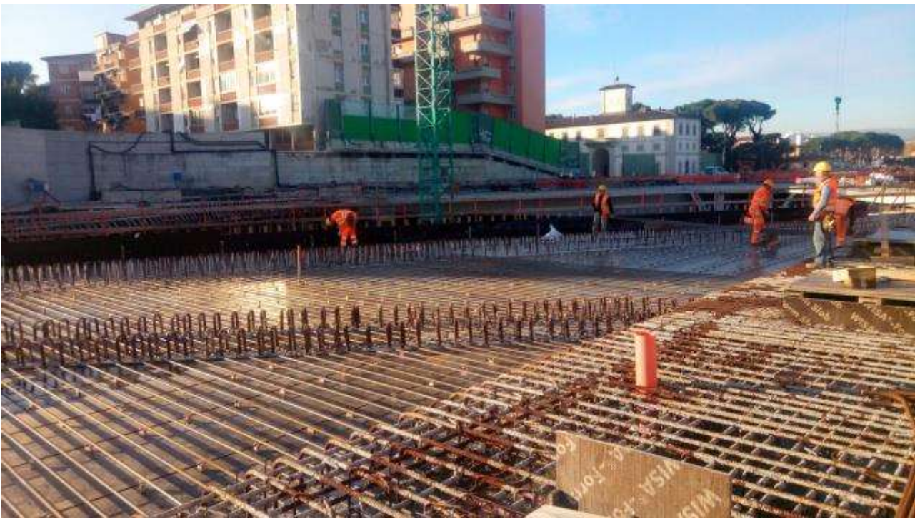
Foto 1 – Posa armatura solaio ventaglio 33
