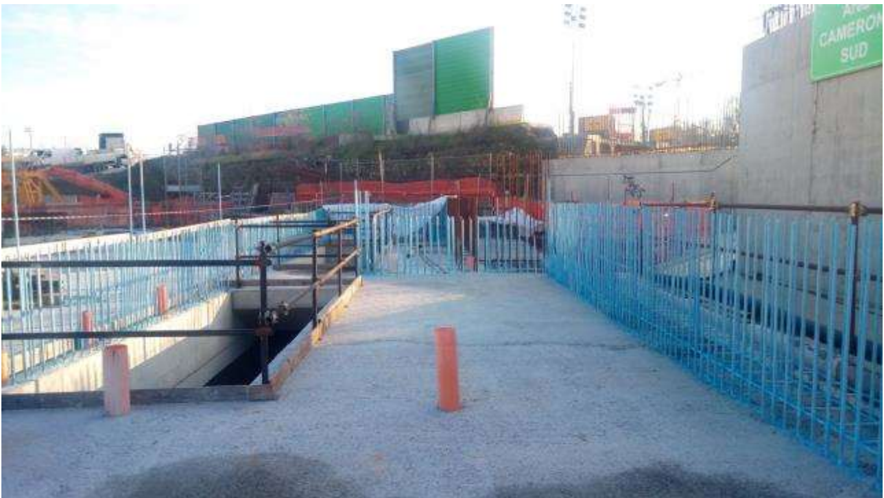
Foto 3– Passivante applicato sui ferri di attesa del solaio liv. 00
