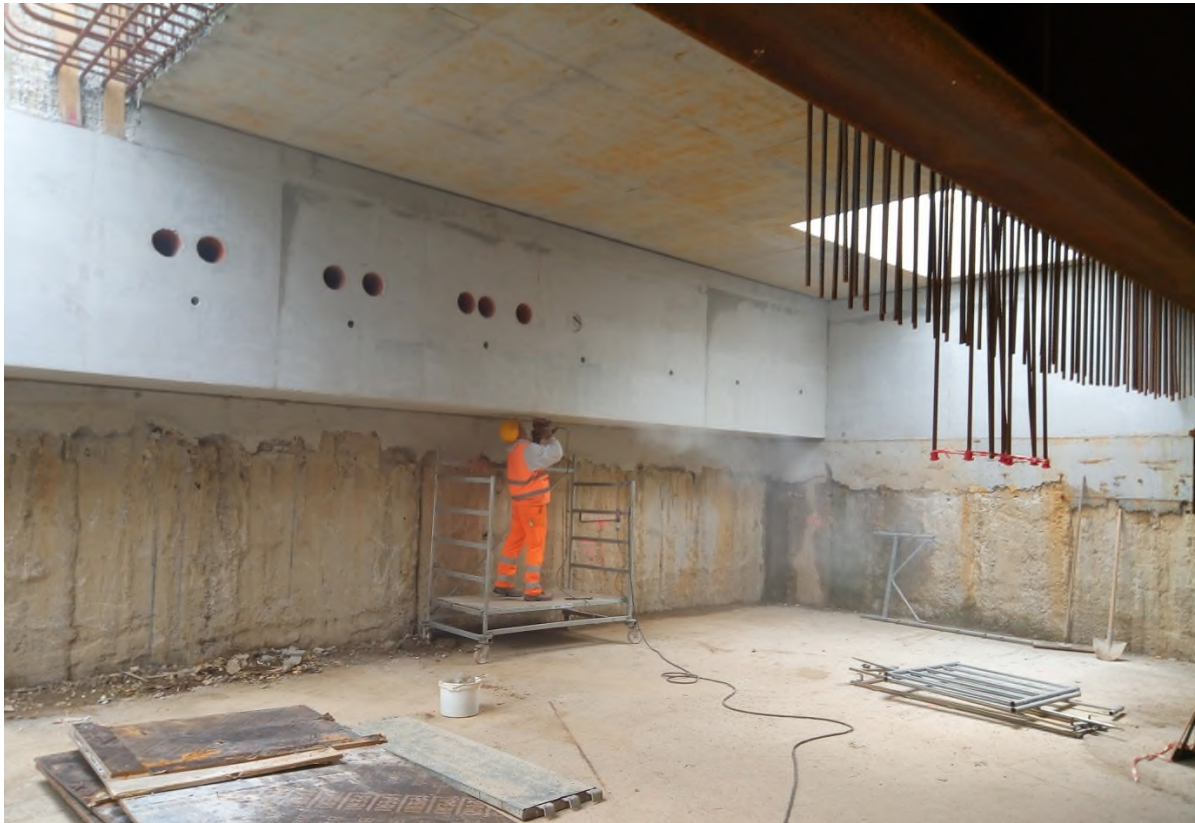
Foto 2 – Interventi di ripristino su solaio Testata Sud
