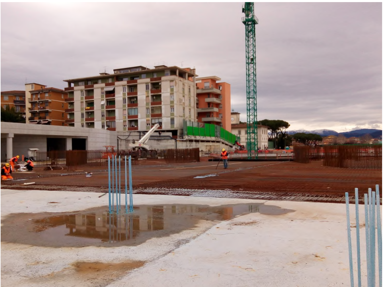
Foto 1 – Posa armatura solaio ventaglio 33
