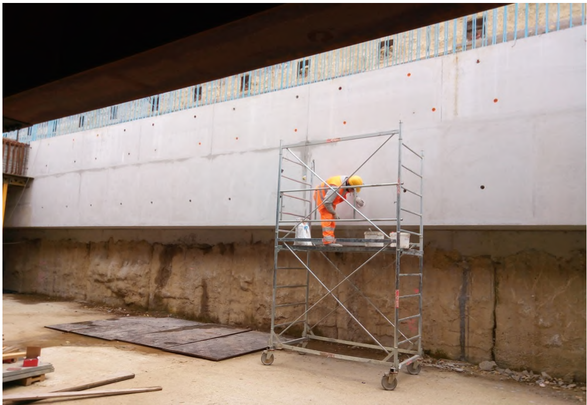
Foto 3 – Interventi di ripristino su solaio Testata Sud
