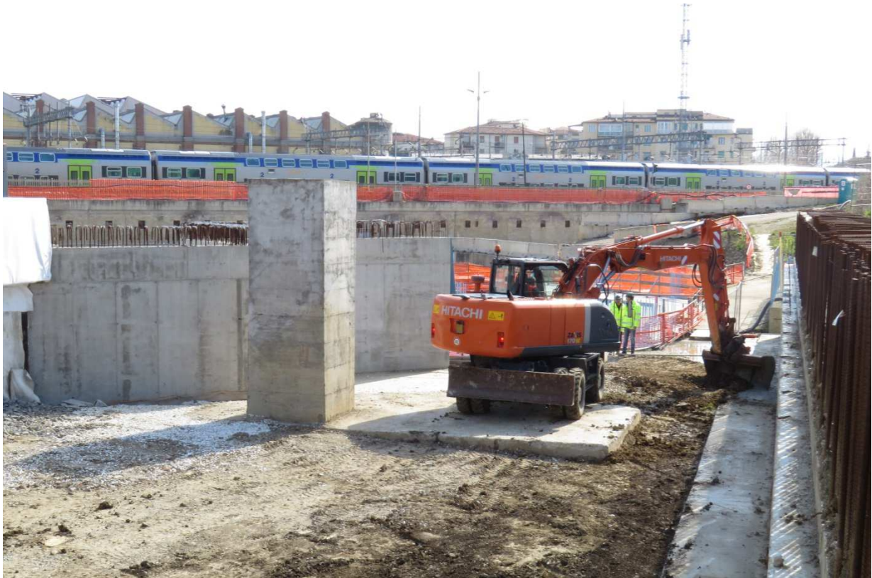
Foto 2 – Preparazione fondo rilevato a tergo rampa Kiss & Ride
