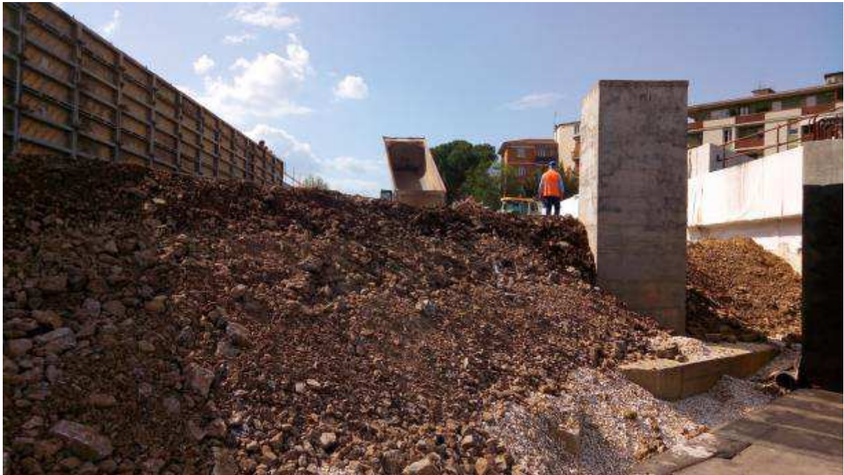
Foto 2 – Realizzazione rilevato a tergo rampa Kiss & Ride
