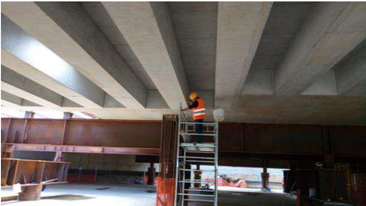
Foto 1 – Interventi di ripristino su solaio Testata Sud
