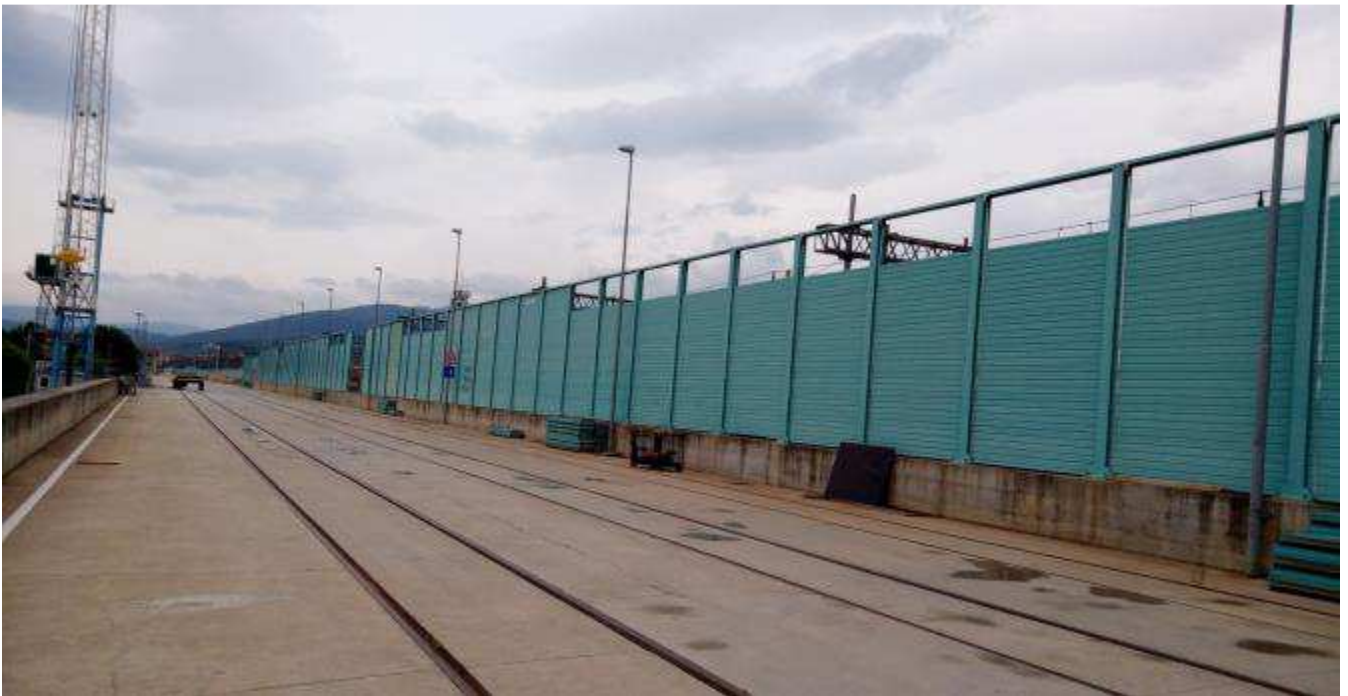
Foto 1 – Messa in sicurezza barriere antirumore corridoio attrezzato
