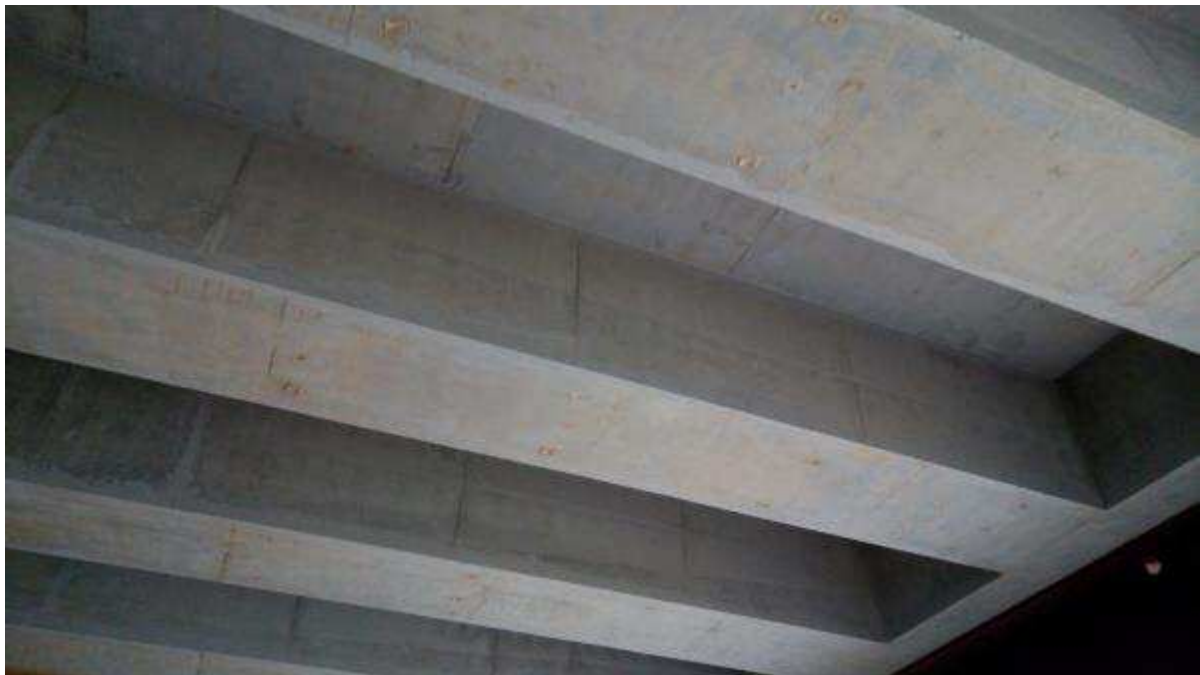
Foto 1 – Interventi di ripristino su solaio Testata Sud
