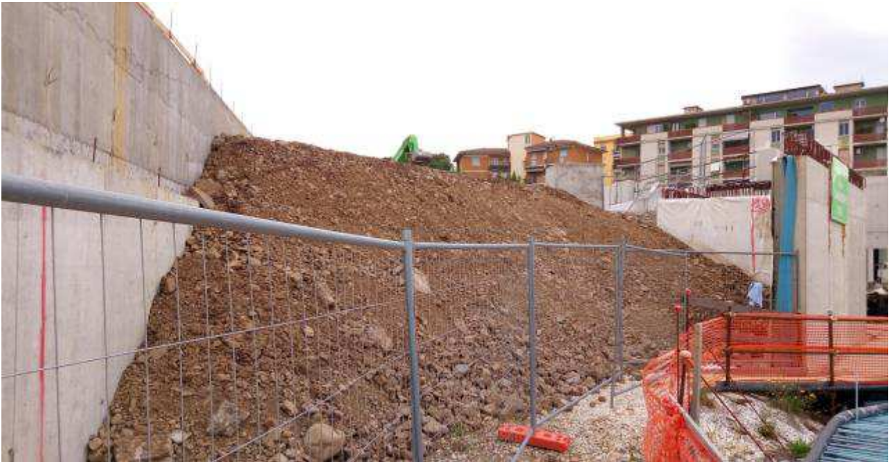
Foto 2 – Realizzazione rilevato a tergo rampa Kiss & Ride
