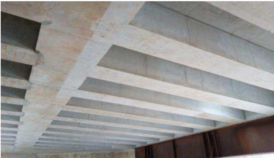
Foto 1 – Interventi di ripristino su solaio Testata Sud
