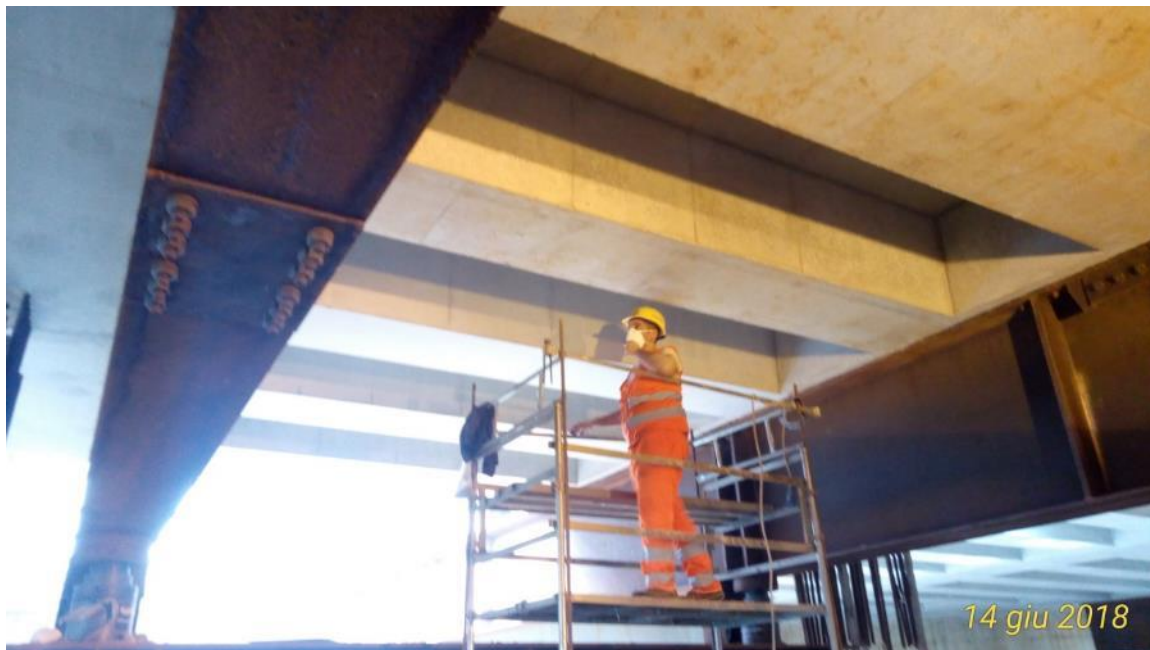
Foto 1 – Interventi di ripristino su solaio Testata Sud
