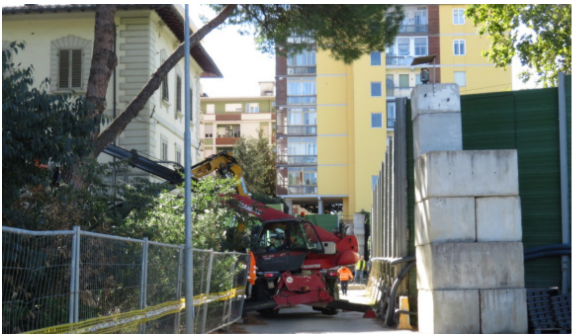
Foto 2 – Montaggio barriere antirumore, Casa dell'Orologio
