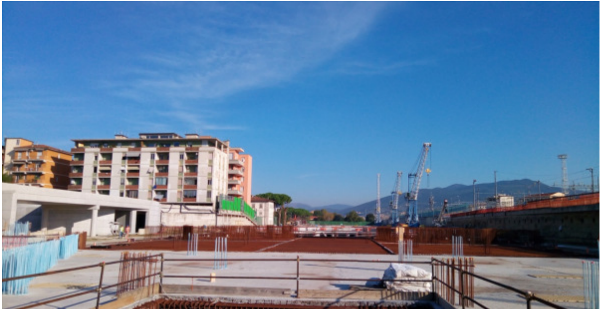
Foto 3 – Panoramica da Sud
