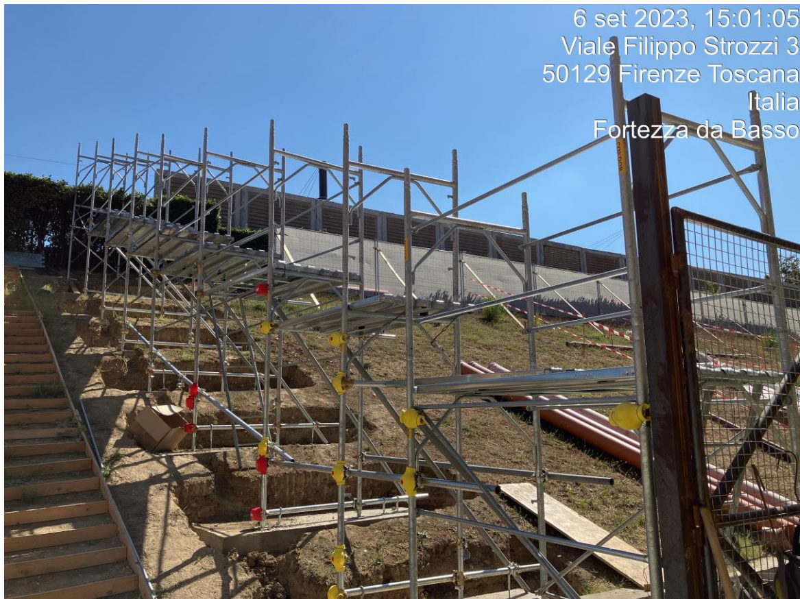
Figura 12 - Fortezza Area 2 – Installazione ponteggi
