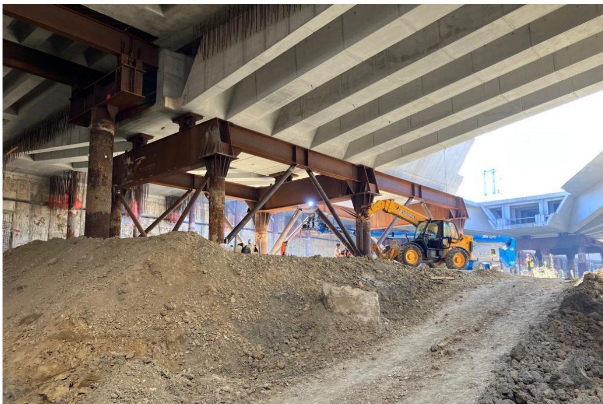
Figura 1 Stazione AV – Controventi castelletti
