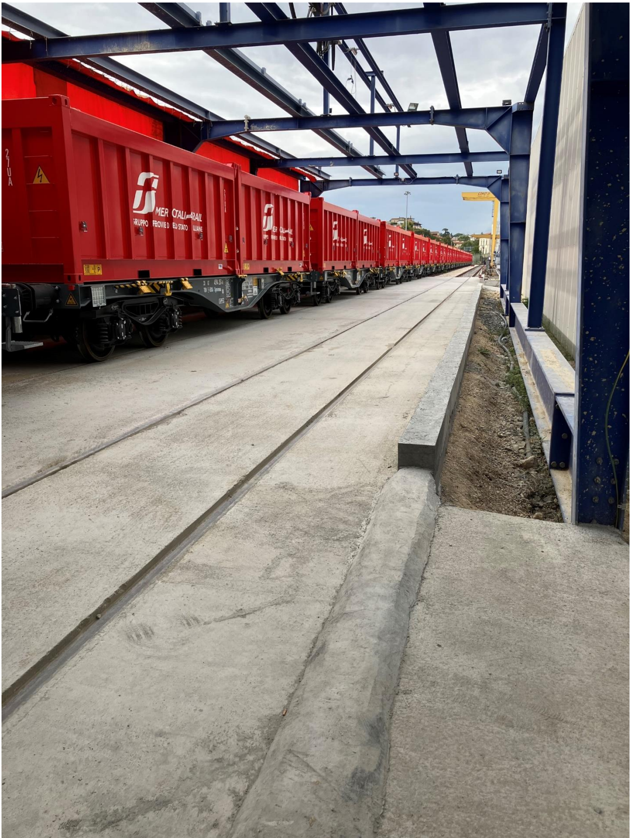
Figura 5 – Cantierizzazione aree di carico smarino su treni (Campo di Marte)
