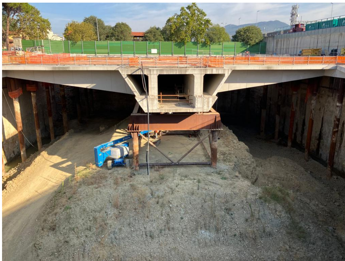
Figura 2 – Stazione AV Camerone – Controventi castelletti
