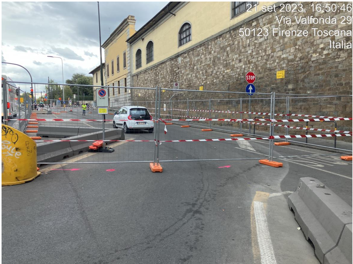
Figura 15 - Fortezza Area 3 - Allestimento cantiere
