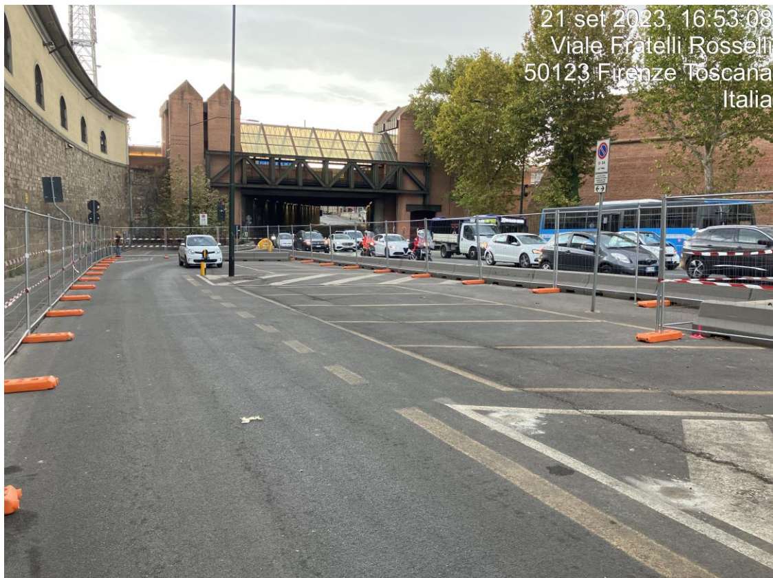
Figura 16 - Fortezza Area 3 - Allestimento cantiere
