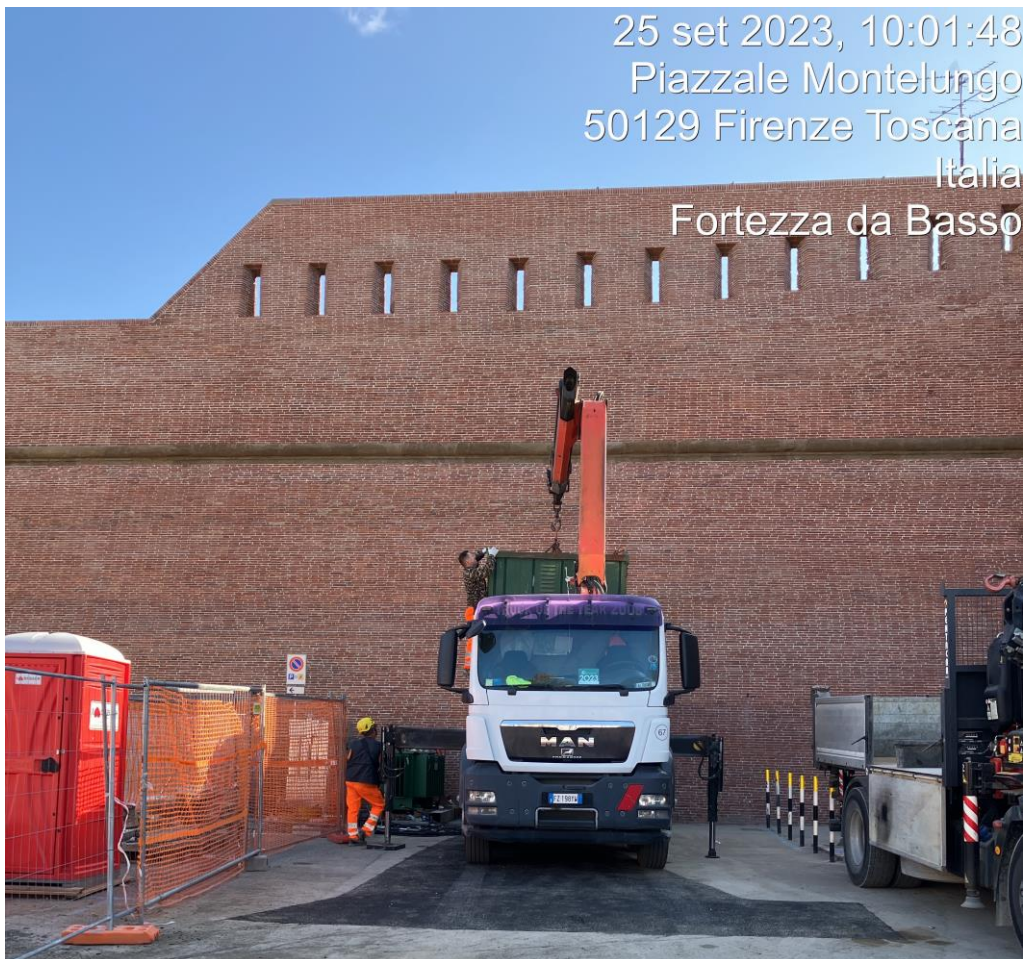
Figura 18 - Fortezza Area 4 – Interferenza Enel
