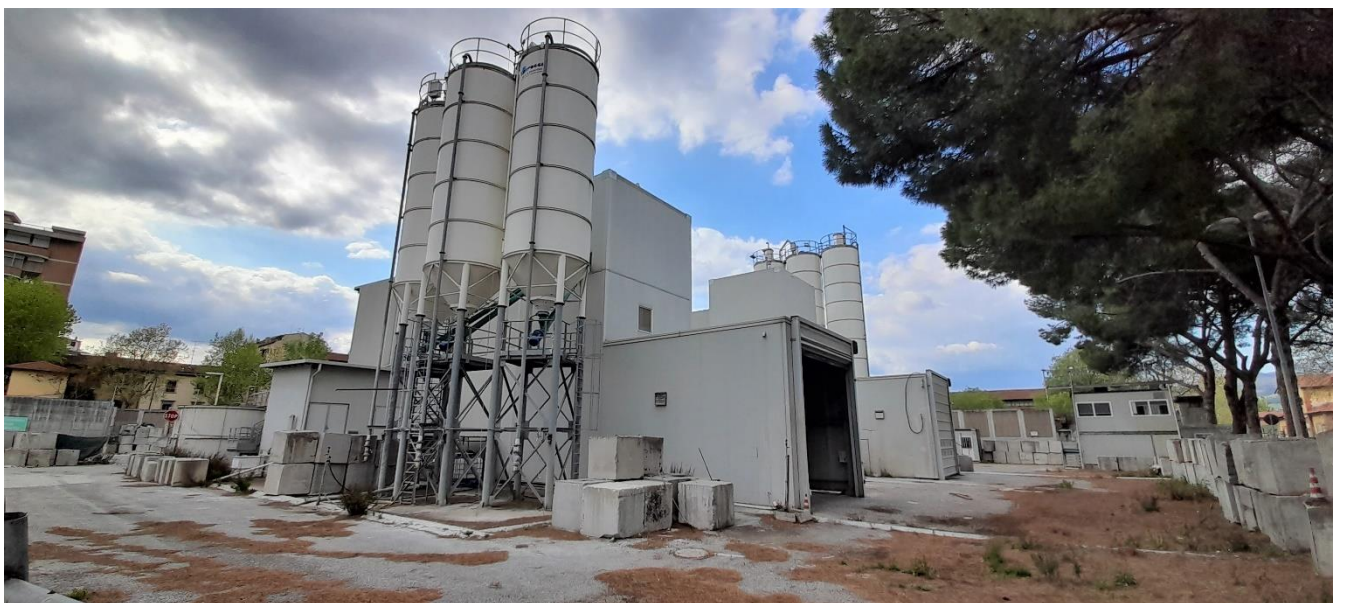
Figura 20 - Impianto di betonaggio
