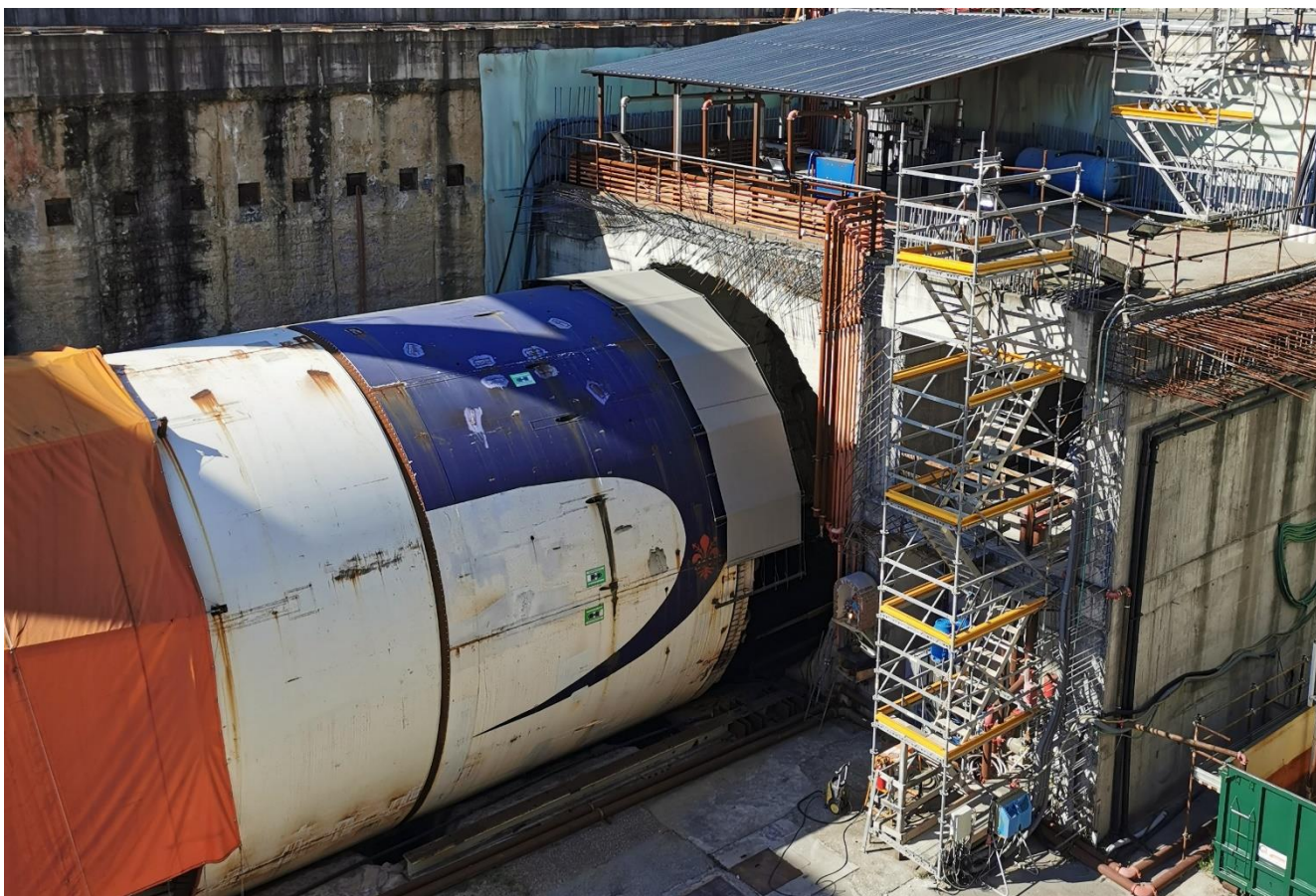
Figura 15 - Pozzo di lancio frese: dettaglio testa frese
