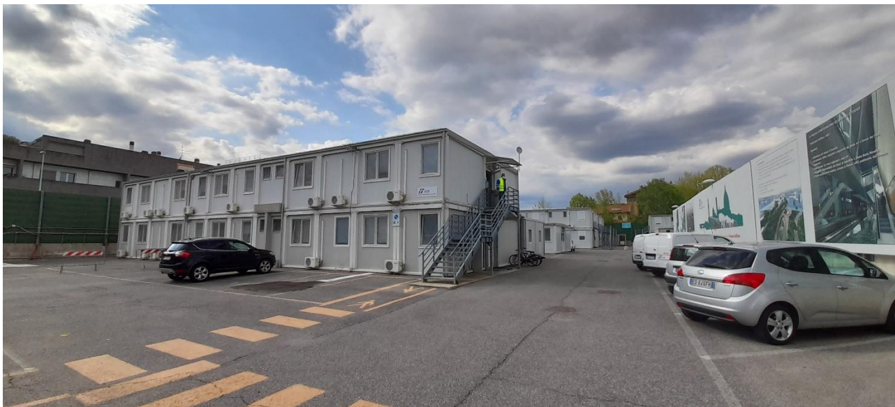
Figura 38 - Uffici campo base via Circondaria
