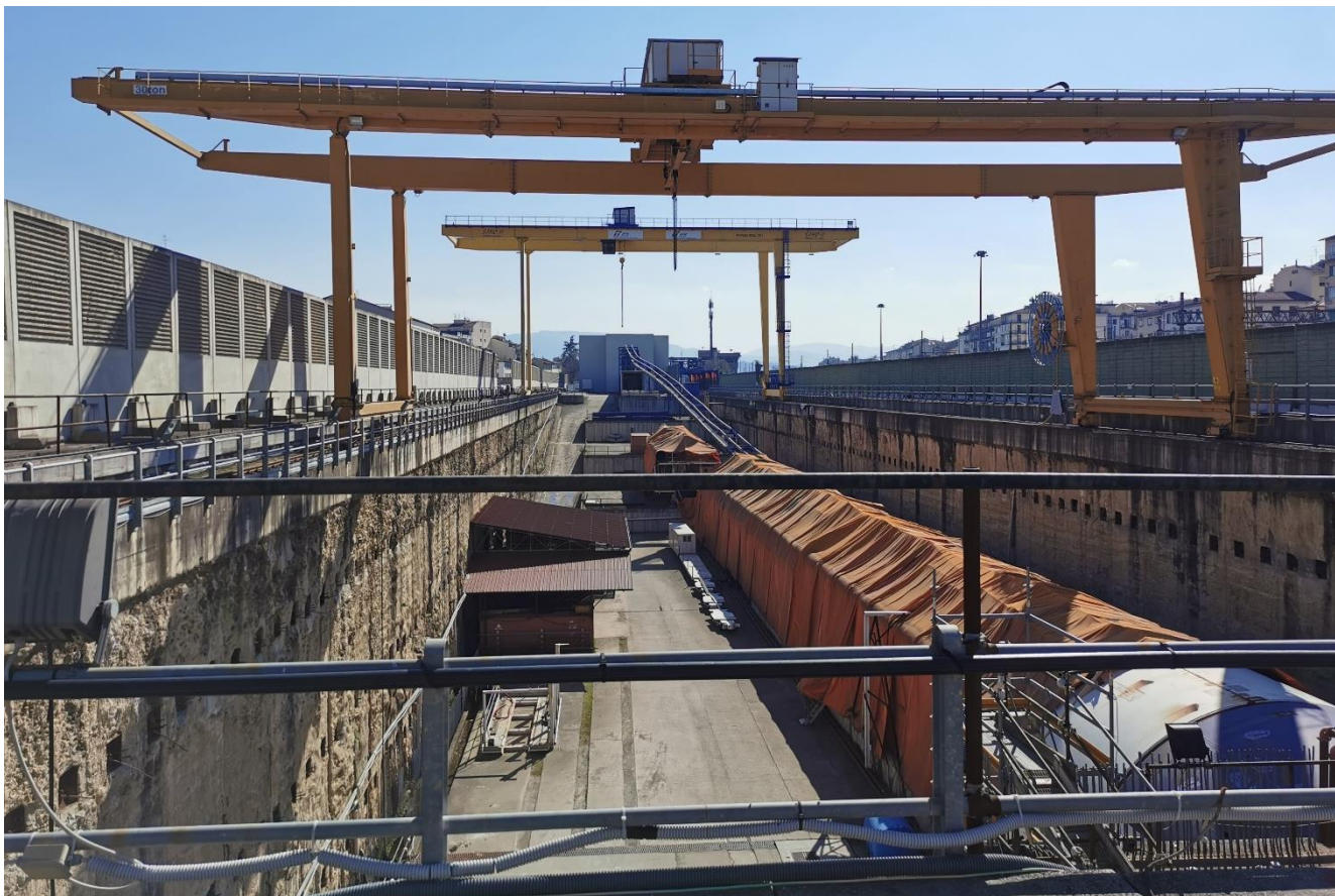
Figura 14 - Area Imbocco Sud: vista in direzione S
