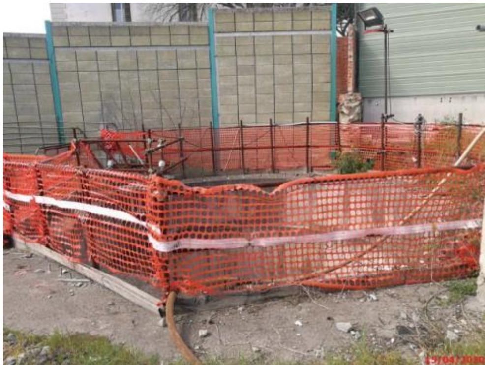
Figura 31 - Pozzo consolidamento Edificio 166: esterno pozzo
