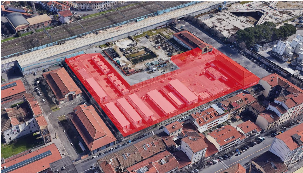
Figura 37 - Baraccamenti campo base via Circondaria
