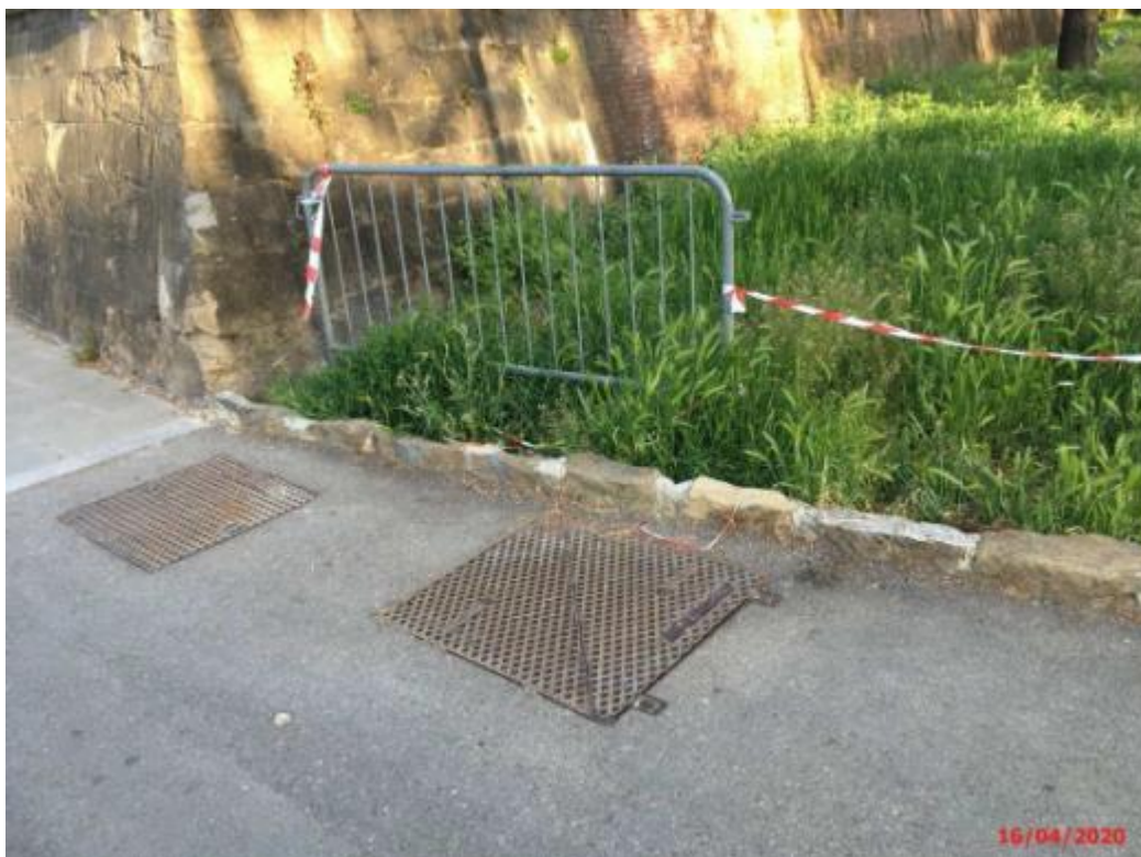
Figura 34 - Aree Fortezza da Basso: Pozzetto sulla polifora tra i cantieri 1 e 2
