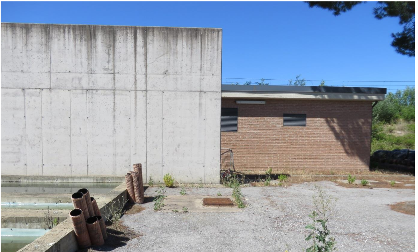
Figura 10 - Cabina di Media Tensione dell'area Triage Nord
