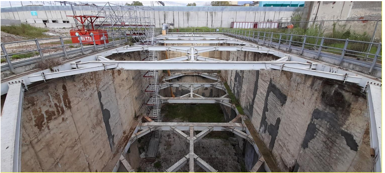
Figura 18 - Pozzo di ventilazione Nord
