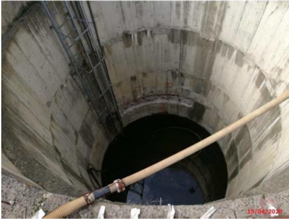
Figura 32 - Pozzo consolidamento Edificio 166: interno pozzo
