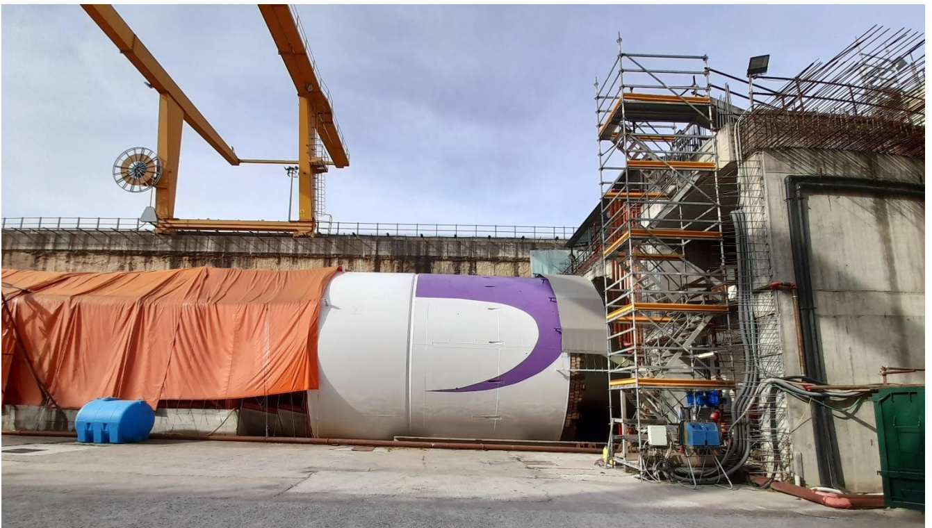
Figura 17 - Pozzo di lancio fresa: vista laterale fresa
